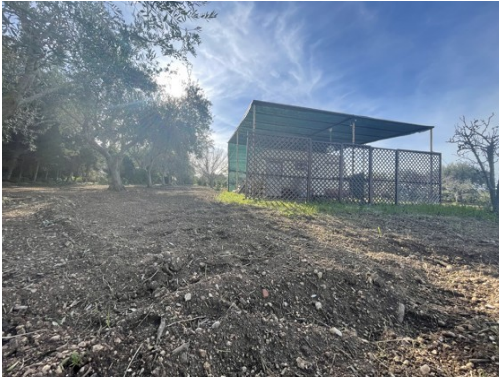
Fotografia C.5 - Noto-Foglio 411 p.lla 1263-Tettoia insistente (Struttura precaria)
