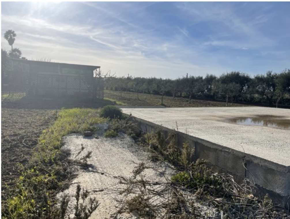
Fotografia C.6 - Noto-Foglio 411 p.lla 1263-Basamento murato con riempimento in pietra naturale
