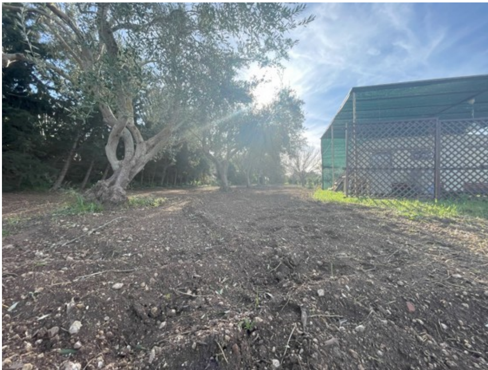
Fotografia C.4 - Noto-Foglio 411 p.la 1263-Tettoia insistente (Struttura precaria)
