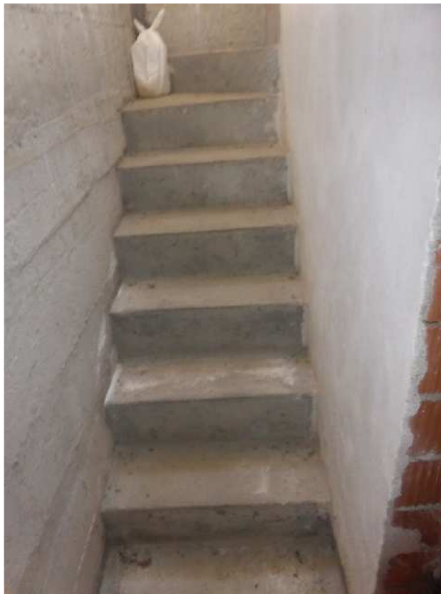
Foto 26: Vano scala (sub 1).
