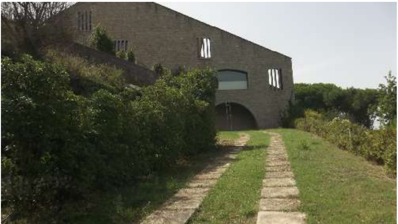
ESTERNO PROSPETTO LATO STRADA PUBBLICA ED INGRESSO POSTERIORE QUOTA SEMICANTINATO
