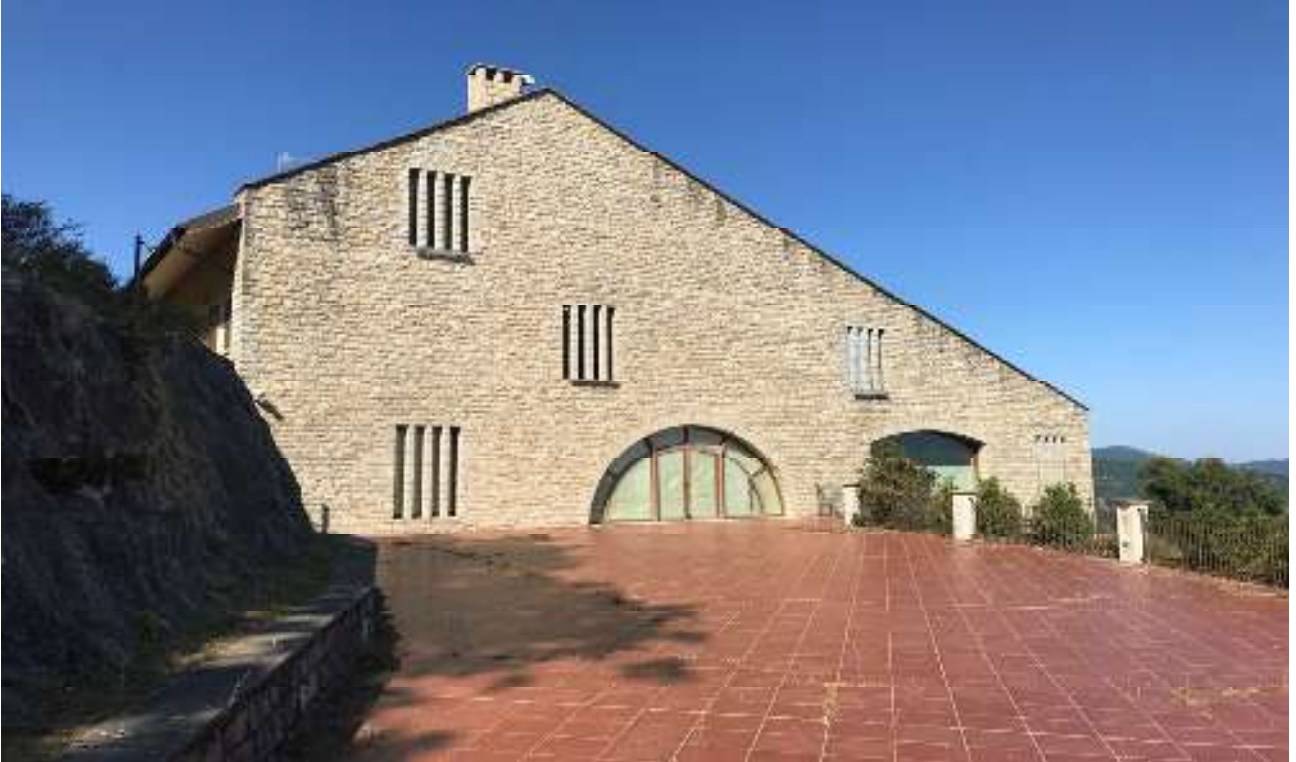
ESTERNO PROSPETTO LATERALE LATO TERRAZZO SALA RICEVIMENTI
