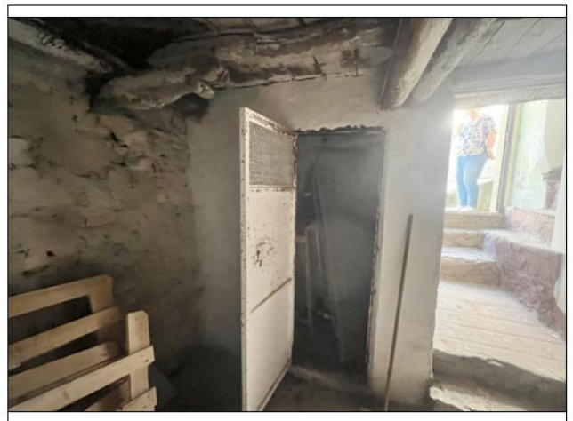
Magazzino al Piano Terra
