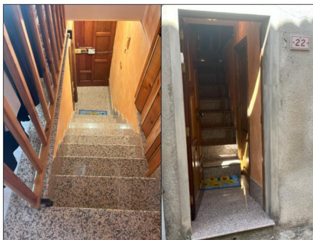
Vano Scala e accesso -Via Sant'Ippolito n. 22
