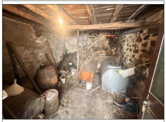
Vano magazzino al Piano Terra
