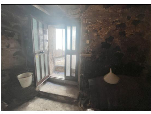
Vano magazzino al Piano Terra
