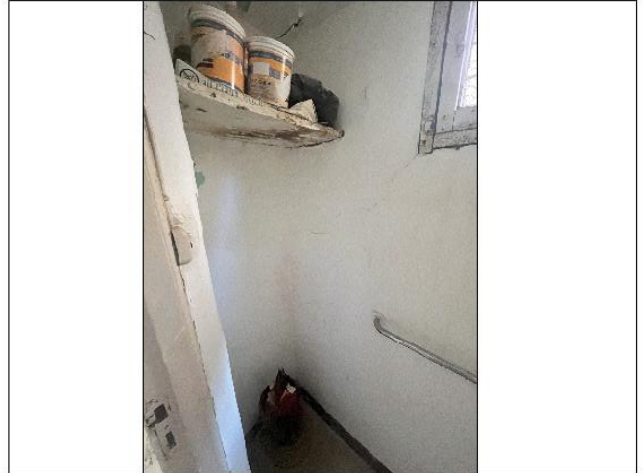
Servizio igienico Piano Primo
