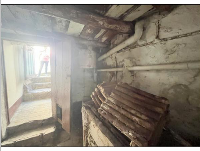
Magazzino al Piano Terra
