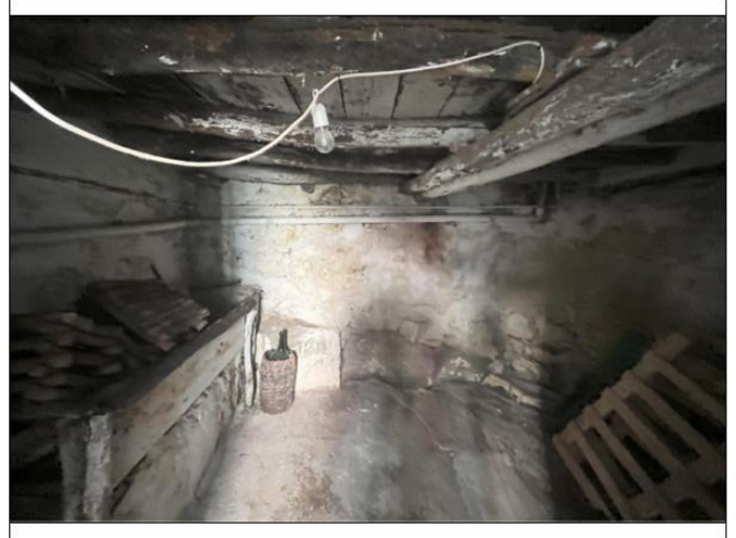
Magazzino al Piano Terra
