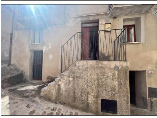
Scala di accesso al primo piano- Via Sant'Ippolito n.18
