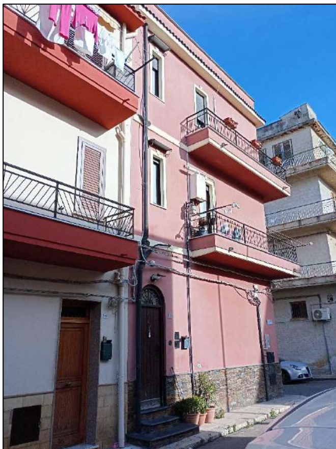
Foto 3 – Vista edificio residenziale
