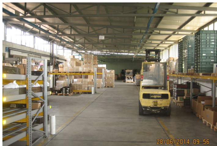
Vista interno del manufatto industriale - struttura in acciaio uso deposito
