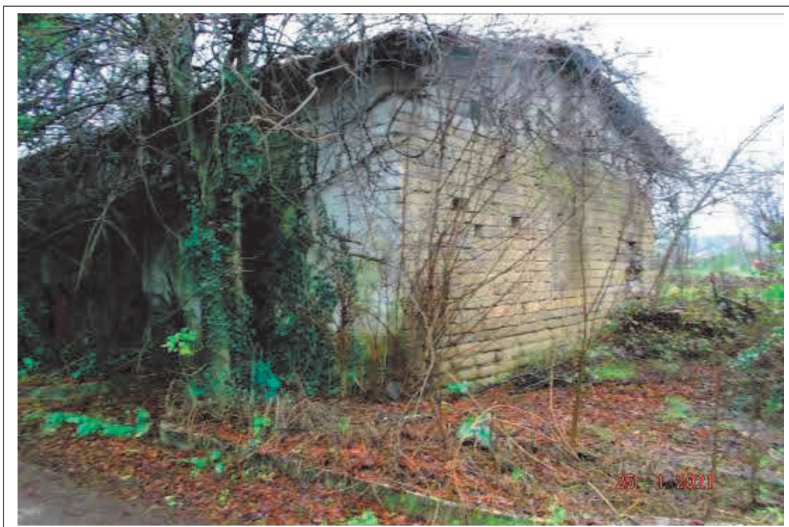
Foto n. 9 – Corpo accessorio uso deposito F. 47 p.lla 346 sub 3
