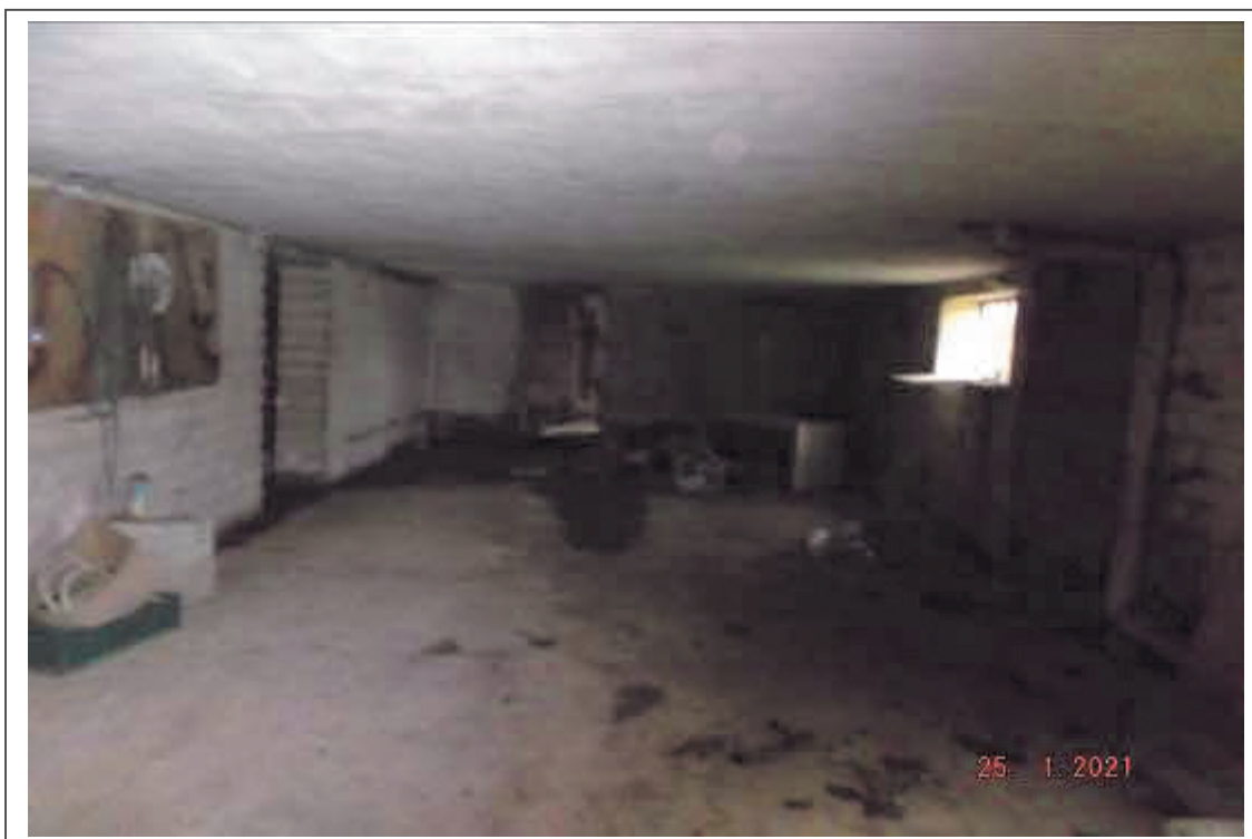
Foto n. 7 – Locali al P.T. del Fabbricato F. 47 p.lla 346 sub 2
