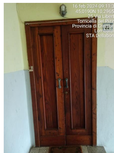
Figura 4- porta di ingresso al ballatoio
