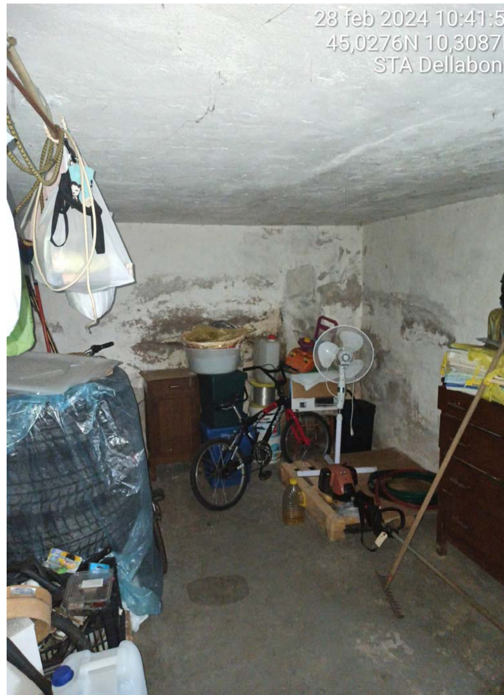
dettaglio interno cantina
