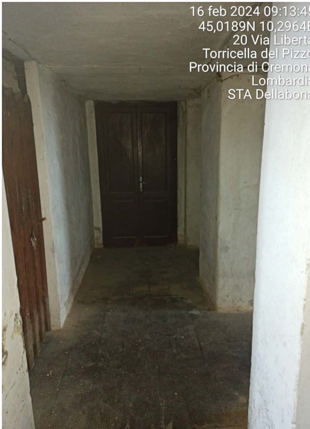
accesso alla cantina
