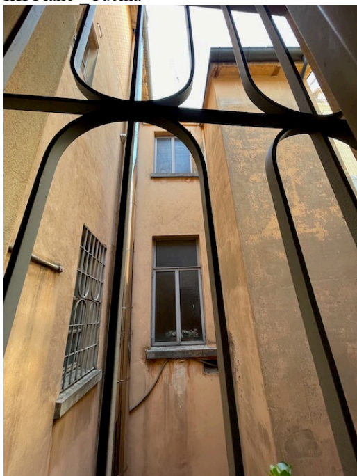
III Piano _Cavedio da cui prendono luce i vani di servizio
