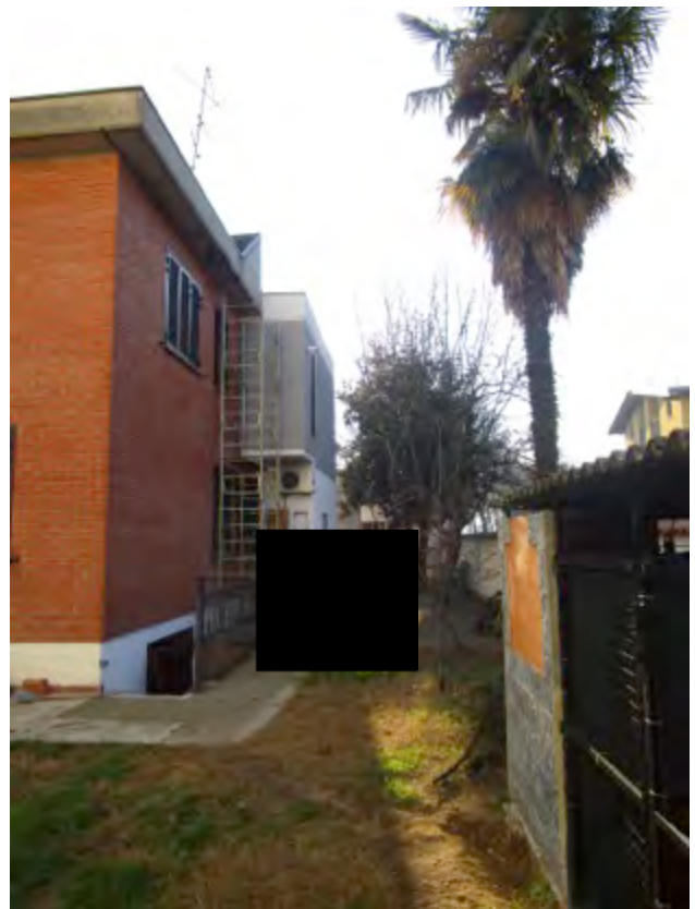
7. Area cortilizia lato ovest, vista verso sud.
