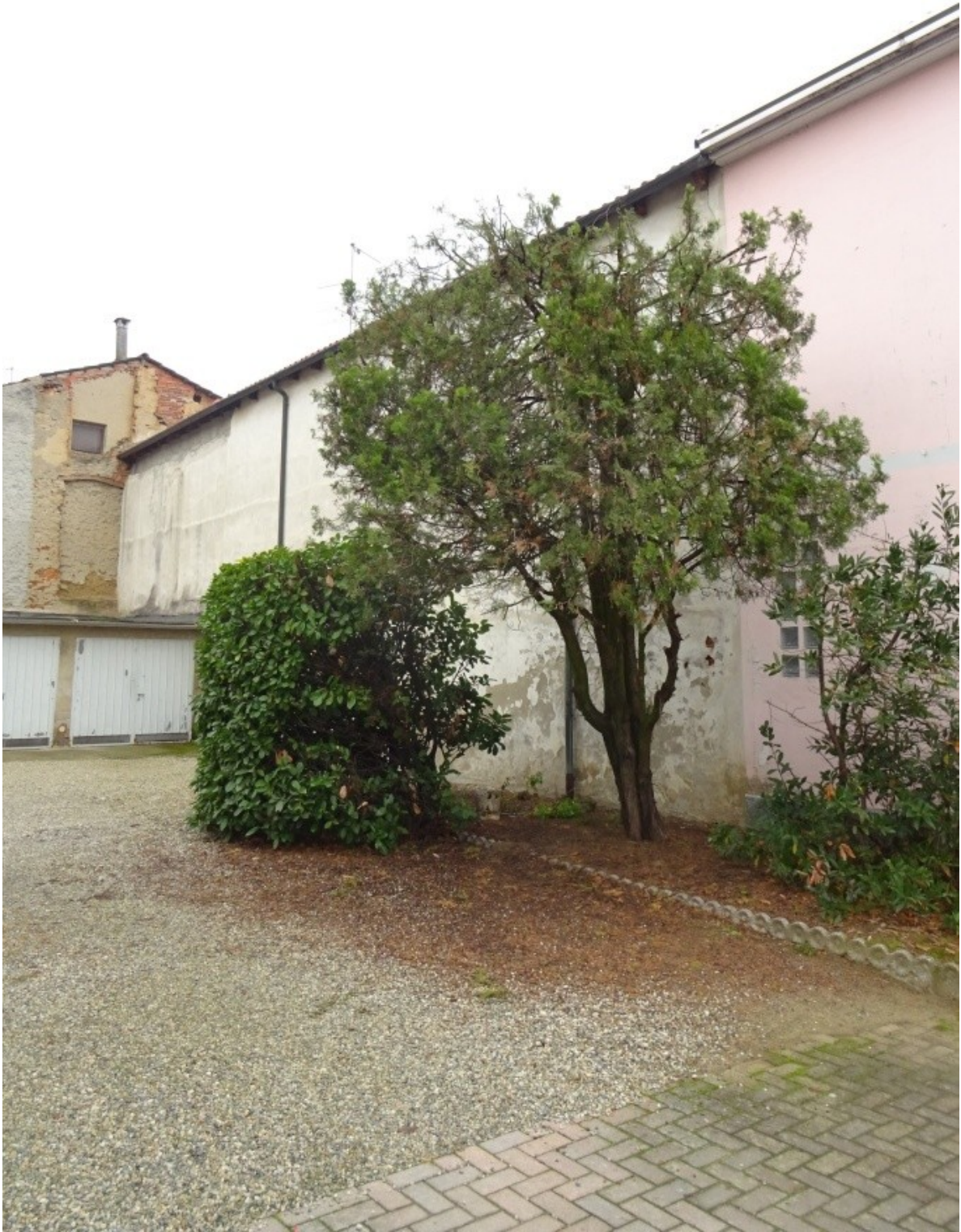
vista lato nord a confine verso terzi
