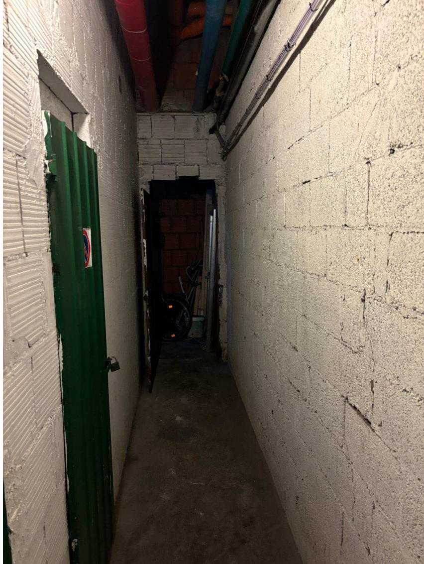
Corridoio condominiale di accesso alla cantina
