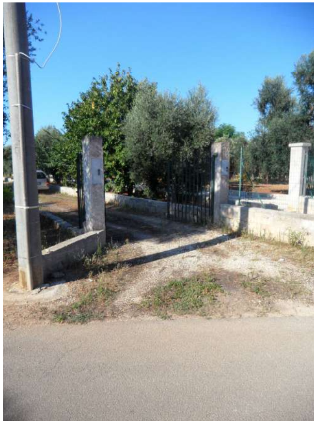
Foto 1 – Vista cancello di accesso al viale carrabile
