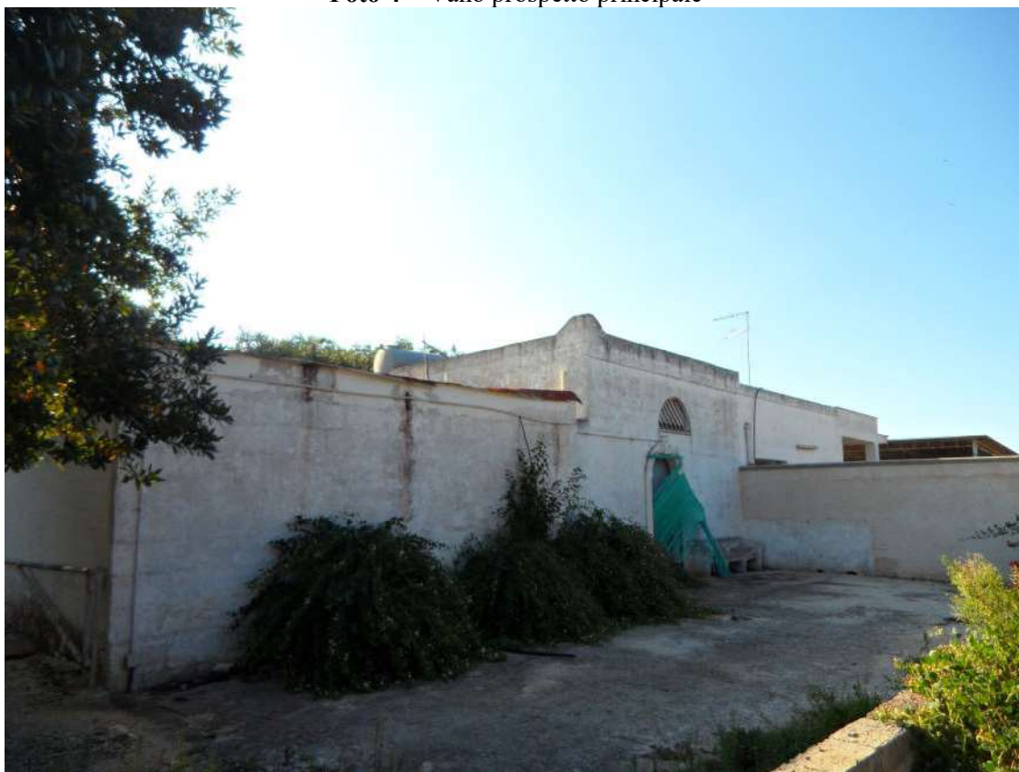
Foto 4 – Vano prospetto principale
