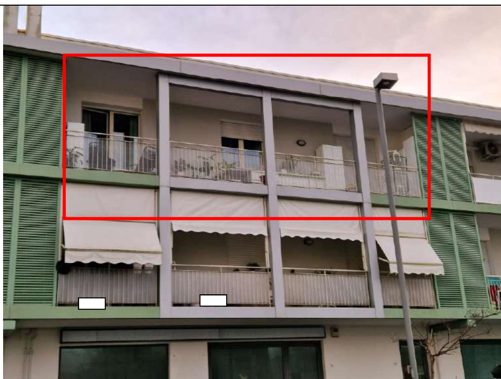
Foto n. 02: Vista prospetto lato Nord su immobile ad uso di civile abitazione, civico 4F, identificato catastalmente nel NCEU del Comune di Viareggio al Foglio 22, mapp. 667, sub. 51, piano 2, scala C, categoria A/3.
