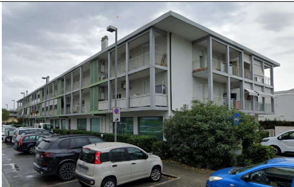
Foto n. 01: Vista lato Nord-Ovest, del complesso condominiale ad uso commerciale e residenziale denominato “ASTARTE 1”, sito nel Comune di Viareggio, in Via della Vetraia, elevato su tre piani fuori, oltre il piano interrato.
