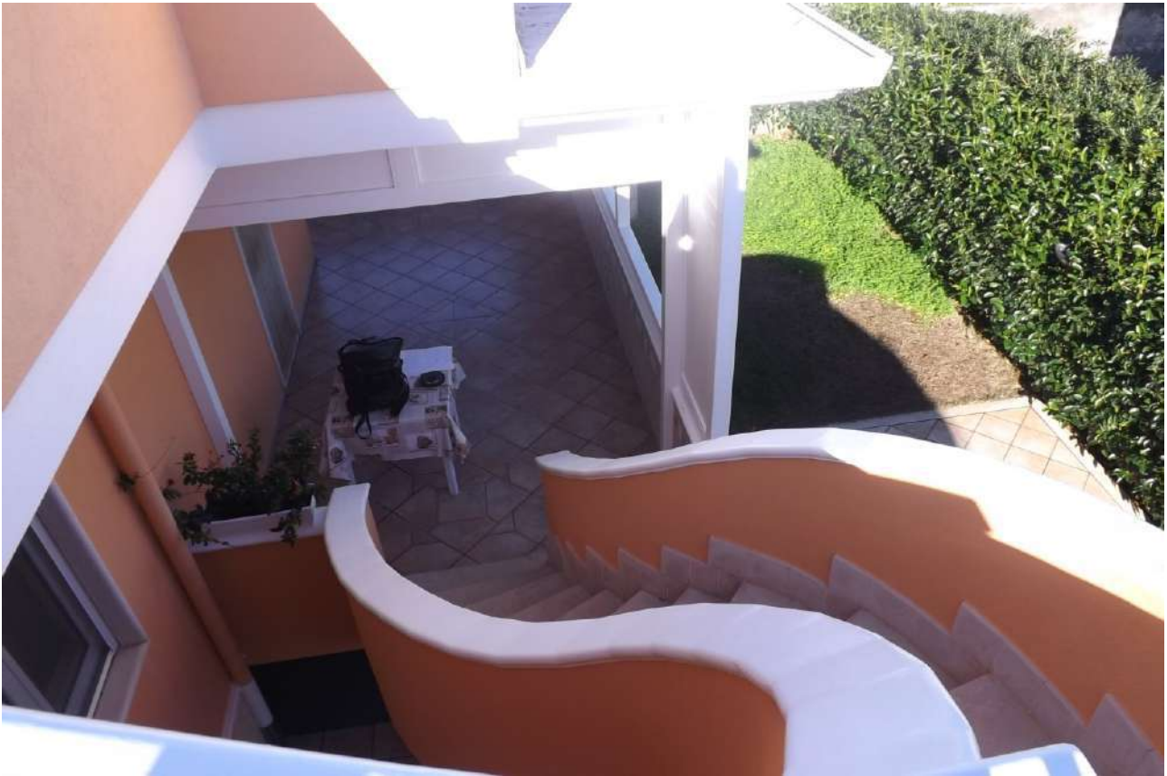
Foto 15_ Vista dall'alto della scala di collegamento esterna con la terrazza di copertura del fabbricato, della porzione di veranda prospiciente il prospetto nord-est.
