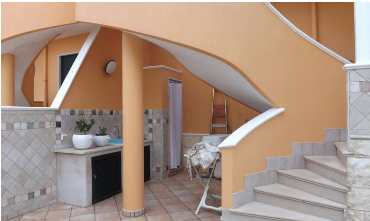
Foto 10_ Vista della porzione di area pertinenziale pavimentata, esposta a nord-est e ubicata al di sotto della scala di collegamento alla terrazza di copertura praticabile. Si rileva la realizzazione, in assenza di Titolo Edilizio, di un piccolo vano adibito a doccia (altezza utile mt. 2,20 e superficie utile 0,70 mq) e di un bancone in muratura attrezzato con lavello e scompartimenti chiusi con pannelli del tipo a persiana in alluminio.
