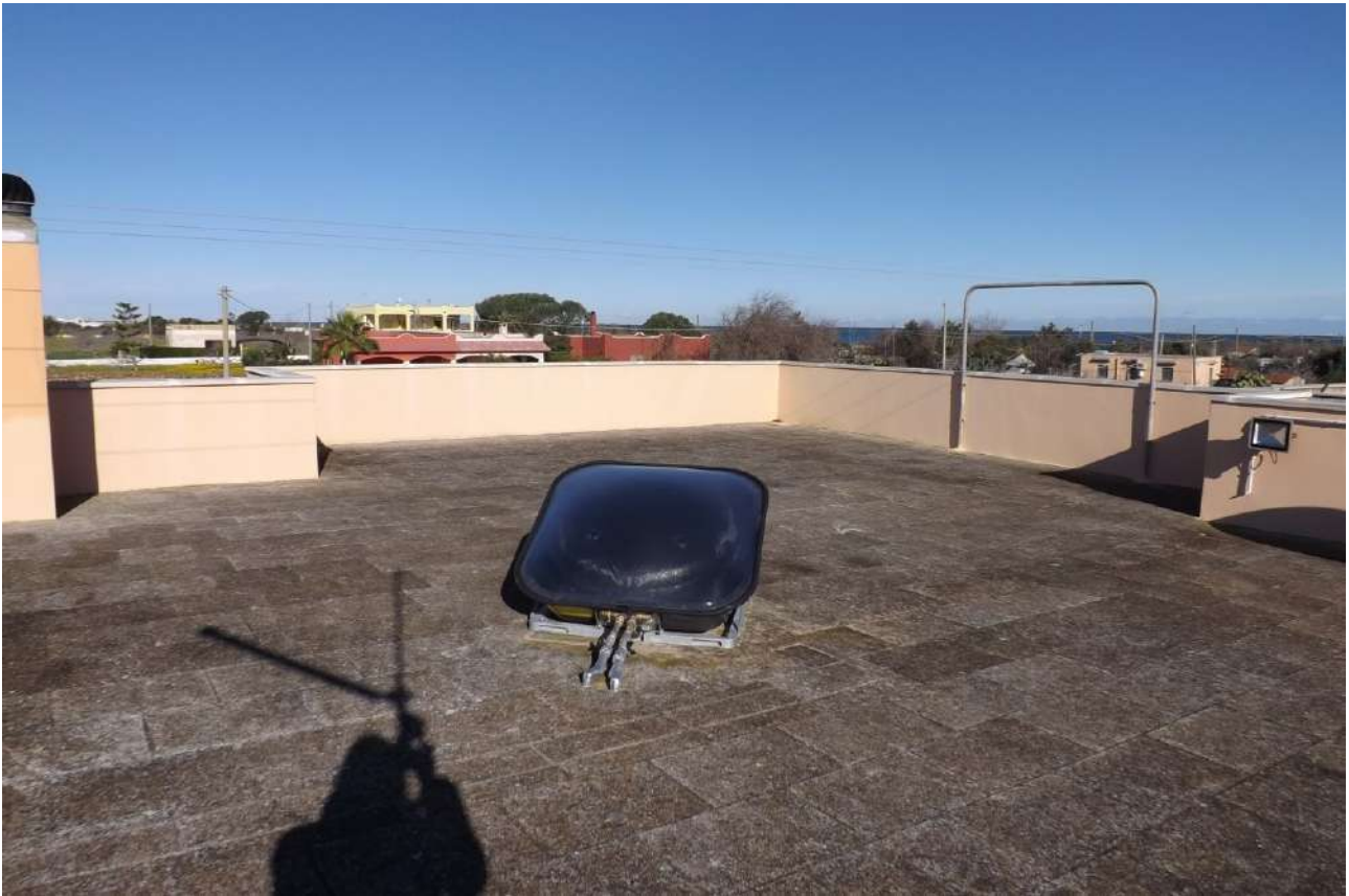
Foto 19_ Altra vista della porzione di terrazza praticabile del fabbricato bifamiliare a copertura dell’unità immobiliare oggetto di pignoramento.
