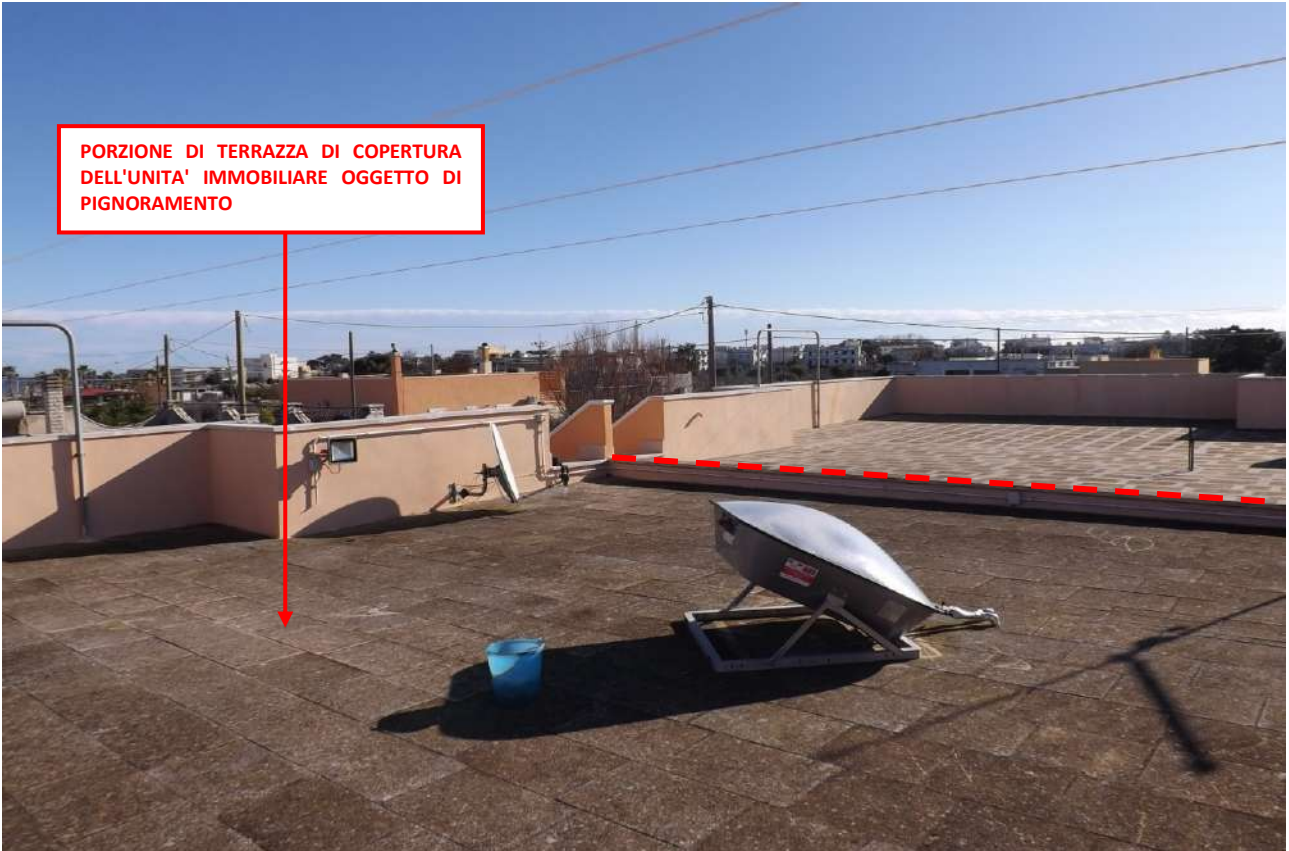
Foto 20_ Altra vista della porzione di terrazza praticabile del fabbricato bifamiliare a copertura dell’unità immobiliare oggetto di pignoramento.
