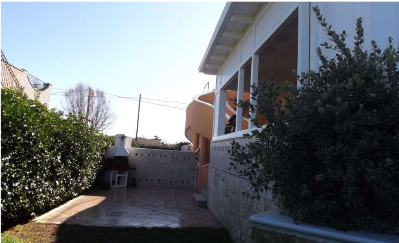
Foto 7_ Vista d'insieme del prospetto nord-est dell'immobile oggetto di pignoramento, della scala esterna di accesso alla terrazza di copertura del fabbricato e di porzione dell'antistante area pertinenziale pavimentata, posta a quota inferiore rispetto al piano di pavimento dell'abitazione.
