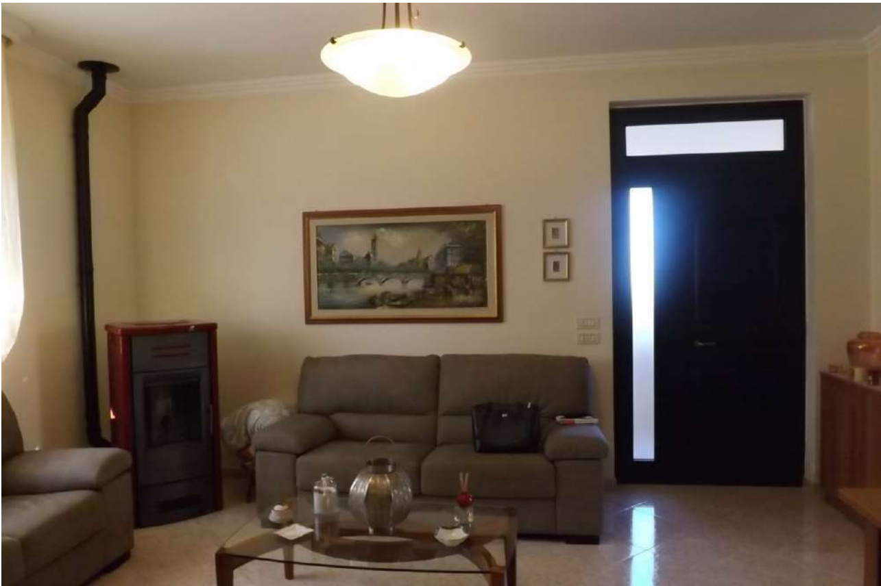
Foto 21_ Vista dal soggiorno/pranzo del portoncino di accesso all’unità immobiliare oggetto di pignoramento, realizzato in legno-alluminio ed inserto in vetro.
