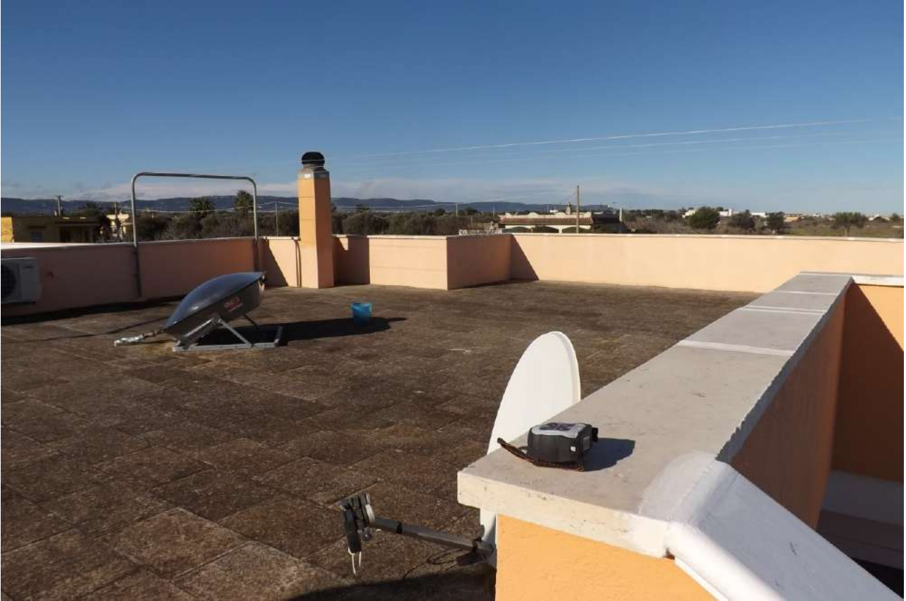
Foto 17_ Vista della porzione di terrazza praticabile del fabbricato bifamiliare a copertura dell'unità immobiliare oggetto di pignoramento.
