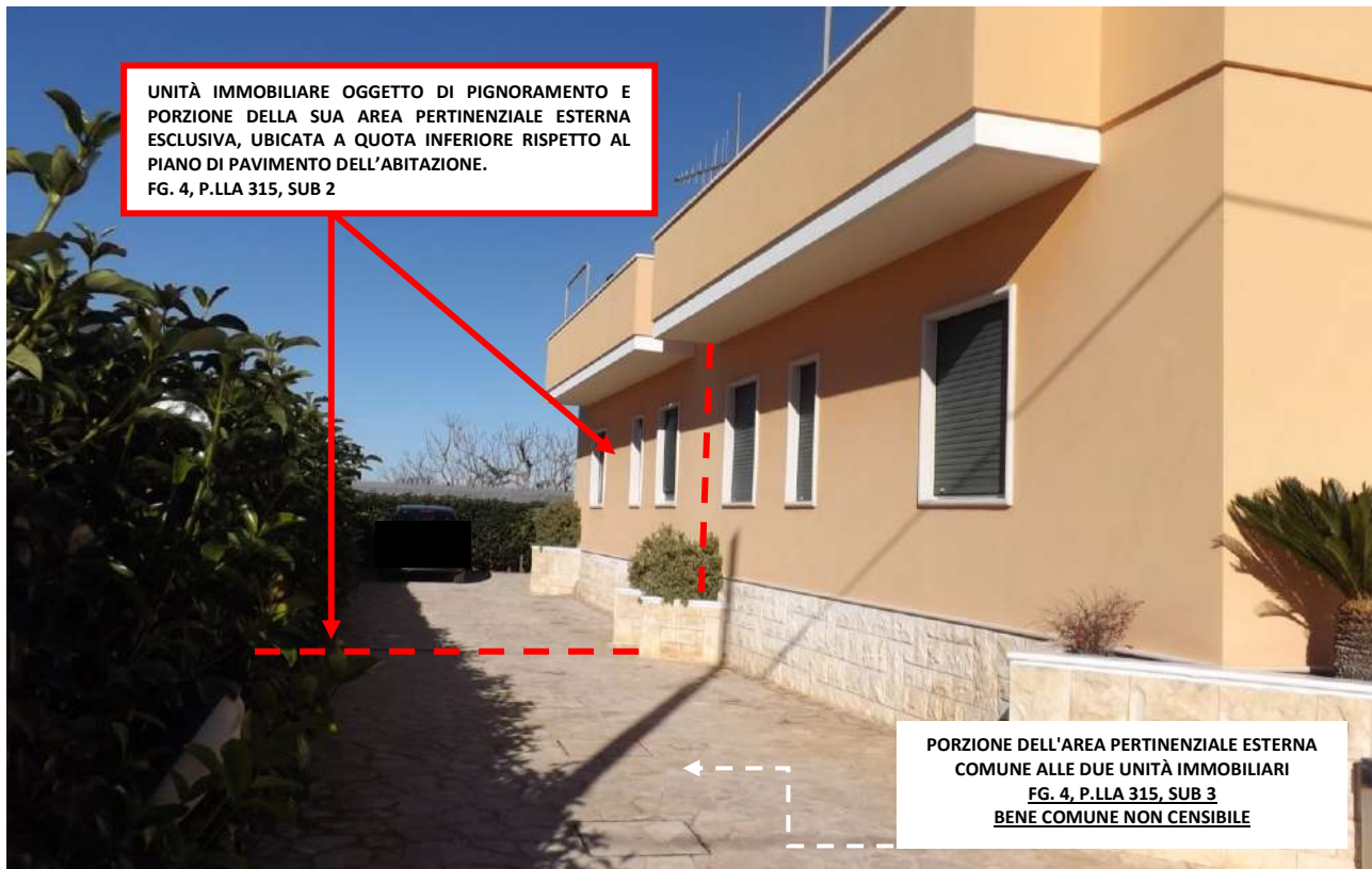
Foto 3_ Vista d'insieme del prospetto esposto ad ovest del fabbricato bifamiliare nel quale è ubicata l'unità immobiliare oggetto di pignoramento (censito in NCEU al Fig.4, p.lla 135 p.la sub 2) e dell'area esterna di pertinenza, in parte comune (NCEU fg.4, p.la 135 p.la sub 3- prospiciente gli accessi) ed in parte di proprietà esclusiva dell'unità immobiliare oggetto di pignoramento (NCEU Fig.4, p.la 135 p.la sub 2).
