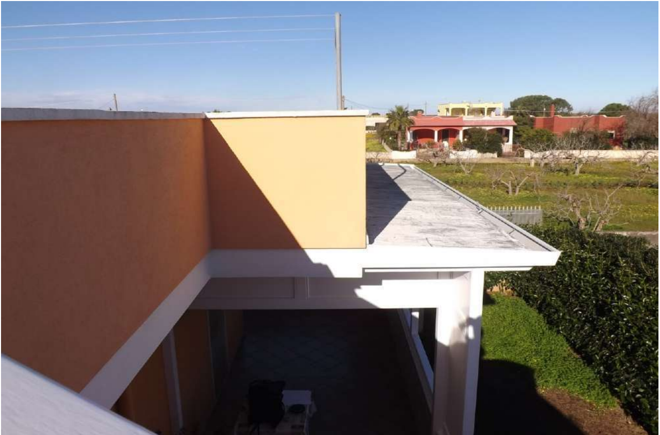
Foto 16_ Vista di dettaglio del prolungamento dell'orinaria porzione aggettante della terrazza di copertura del fabbricato ottenuto mediante la realizzazione di una pensilina in legno, in parte sostenuta da una struttura verticale in legno poggiante sul parapetto ed in parte aggettante.
