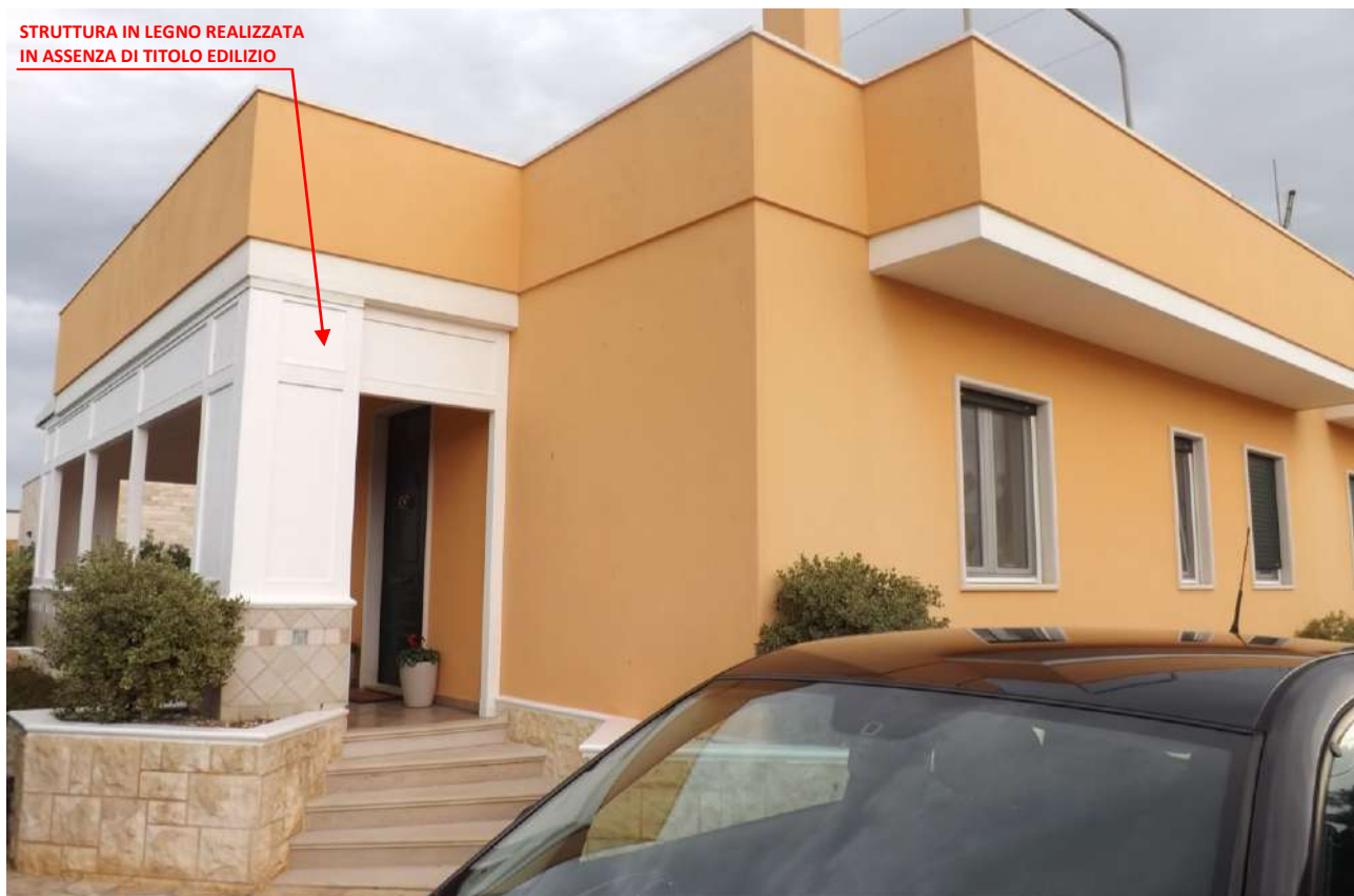
Foto 4_ Vista d'insieme dei prospetti ovest e nord-ovest dell'unità immobiliare oggetto di pignoramento. Si rileva che l'originaria superficie adibita a veranda aperta, delimitata unicamente da un parapetto in muratura di 0,85 cm di altezza e con copertura aggettante, è stata trasformata, in assenza di Titolo Edilizio, in una struttura assimilabile ad una veranda chiusa costituita da pannelli e montanti agganciati al parapetto esistente e alla porzione aggettante della terrazza di copertura.
