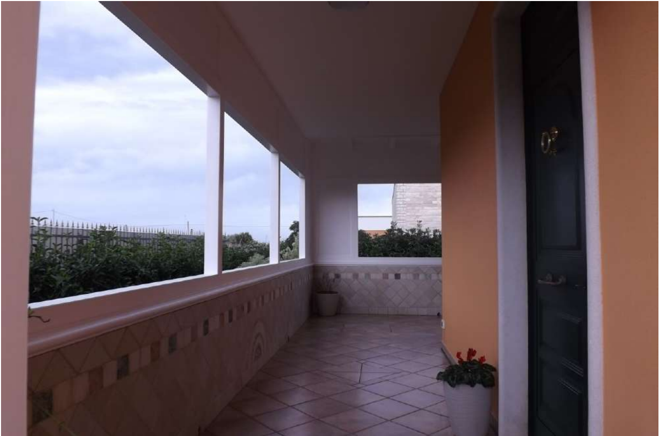
Foto 12_ Vista d'insieme della porzione di veranda realizzata in assenza di Titolo Edilizio e prospiciente il prospetto nord, dal quale si accede, per mezzo di un portoncino in legno-alluminio, all'unità immobiliare oggetto di pignoramento.
