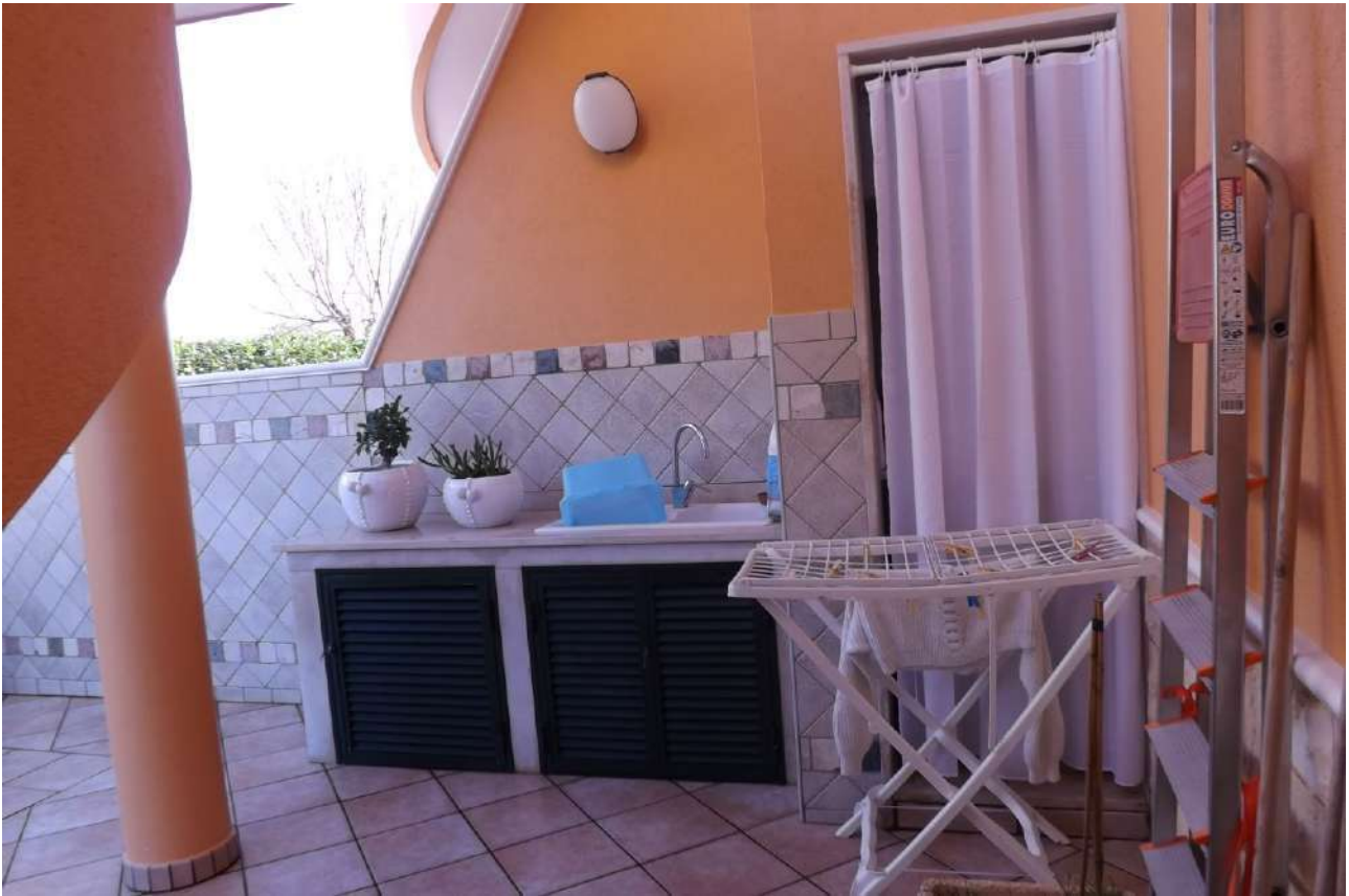
Foto 11_ Vista di dettaglio del vano adibito a doccia e dell'adiacente bancone in muratura attrezzato con lavello e scompartimenti chiusi con pannelli del tipo a persiana" in alluminio.
