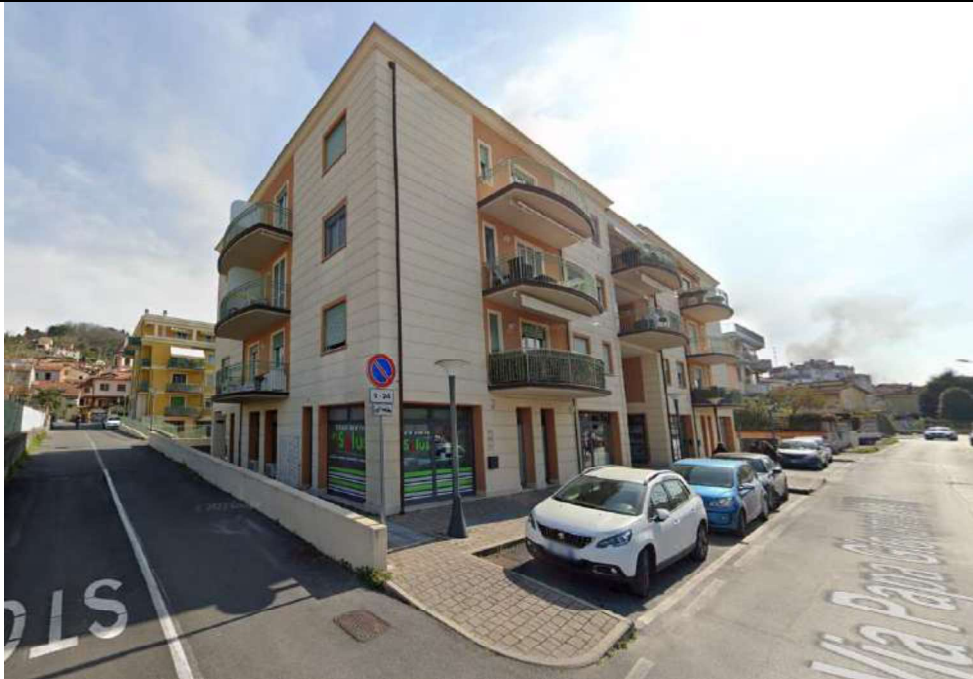
Foto n. 03: Vista prospetto lato Sud-Ovest, del complesso condominiale ad uso residenziale-direzionale- commerciale denominato "MEISSA".
