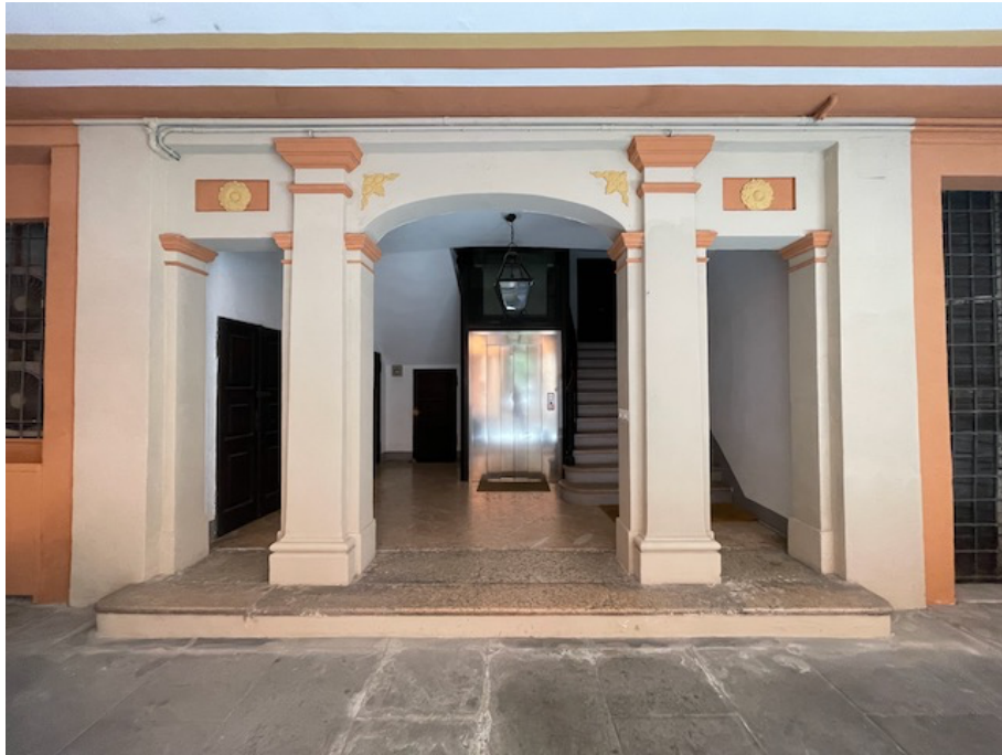
Ingresso al vano scala condominiale (sub 24)
