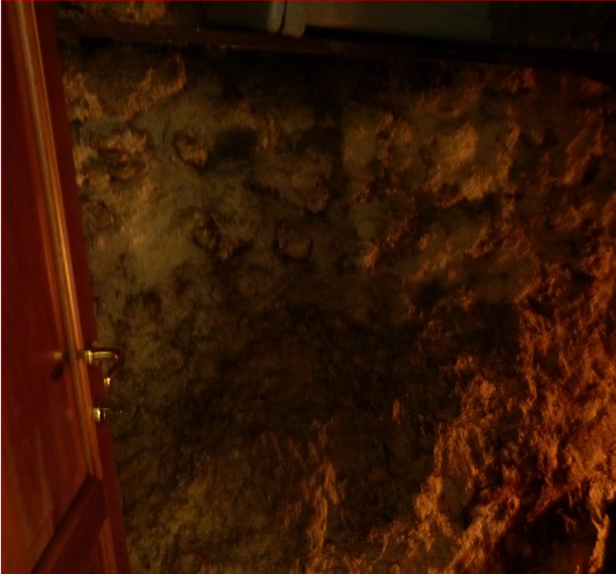
Figura 6 caità ipogea sotto scala
