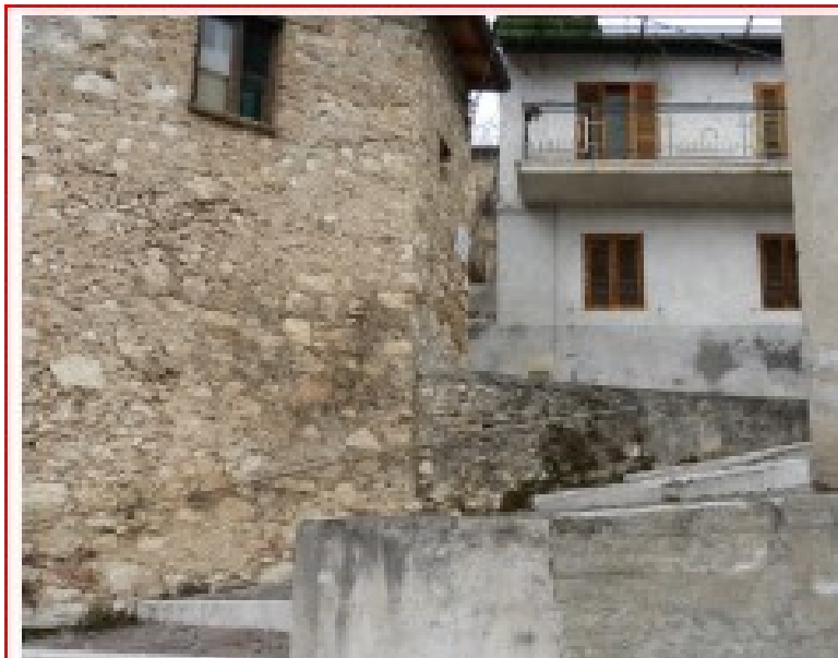
Figura 1 scalinata di accesso
