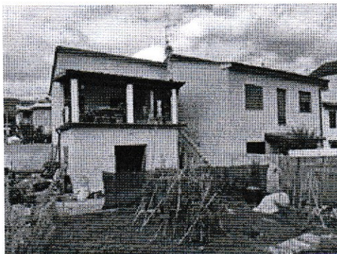
Appartamento al P.I con sottostante deposito/magazzino - Prospetto Sud
