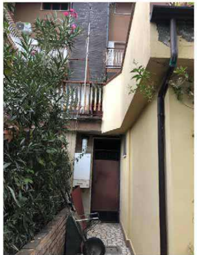
Foto 8 – Ingresso locale caldaia al piano seminterrato lato Ovest.
