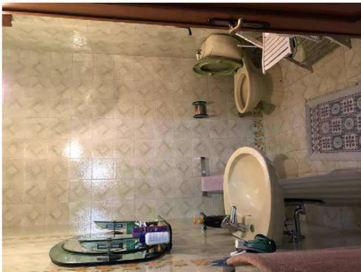
Foto 30 – Bagno al piano primo.
