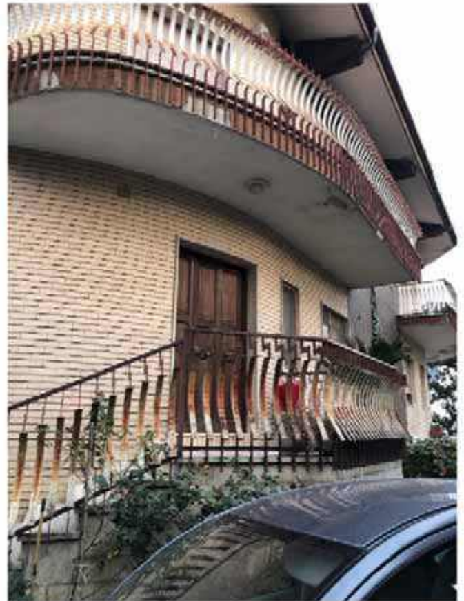
Foto 7 – Ballatoio scala di accesso esterna al piano terra lato Est.
