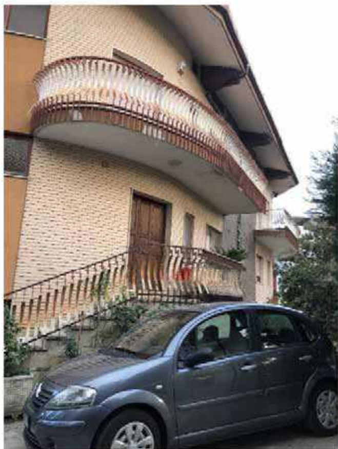
Foto 2 – Scala esterna di ingresso lato Est.
