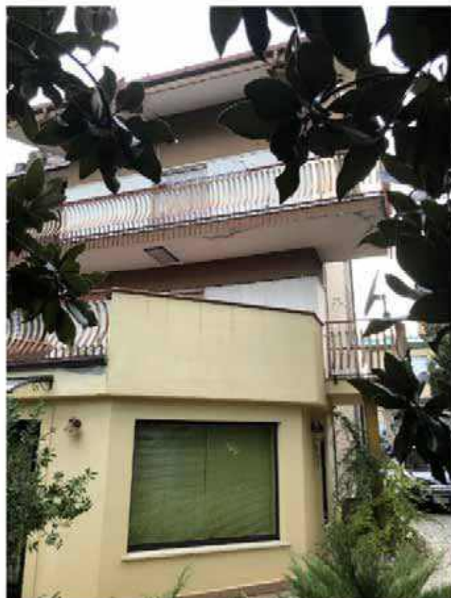
Foto 3 – Terrazzo piano terra lato Ovest
