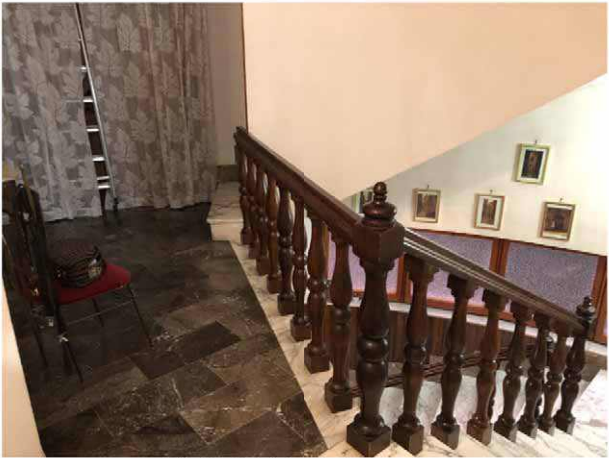
Foto 23 – Ballatoio scala al piano primo.
