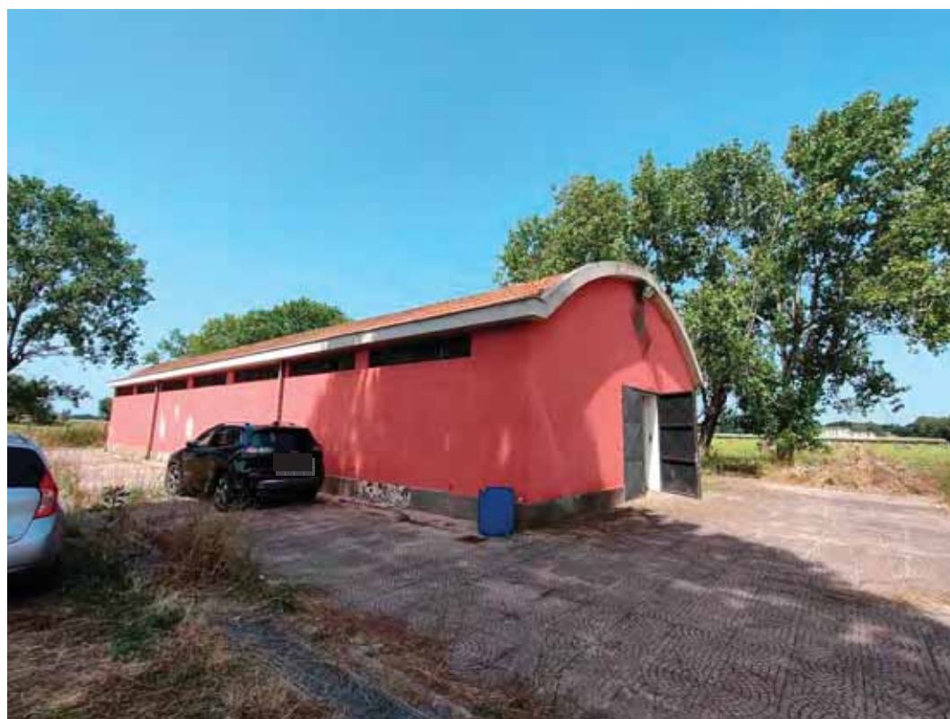
FOTO N. 5: Particolare fabbricato part. 111 - esterno
