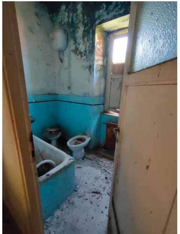
FOTO N. 23: Particolare interni – piano primo
