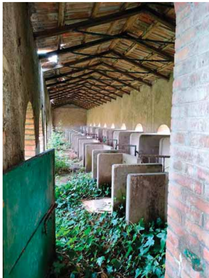
FOTO N. 36: Particolare fabbricato part. 117- esterno
