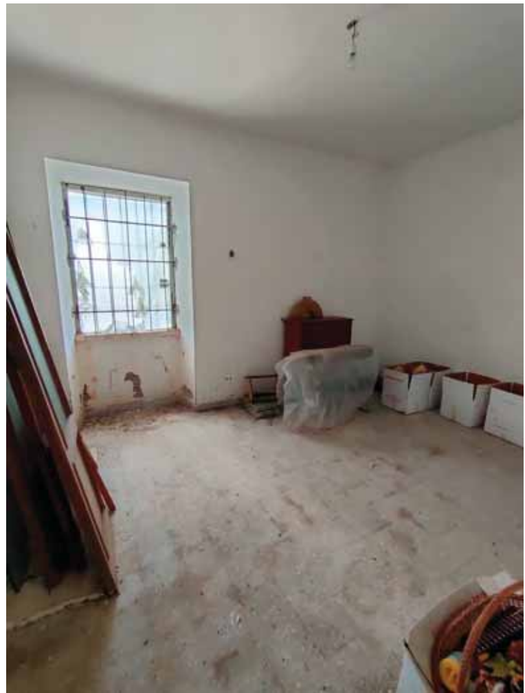
FOTO N.49: Particolare fabbricato part. 117- interno
