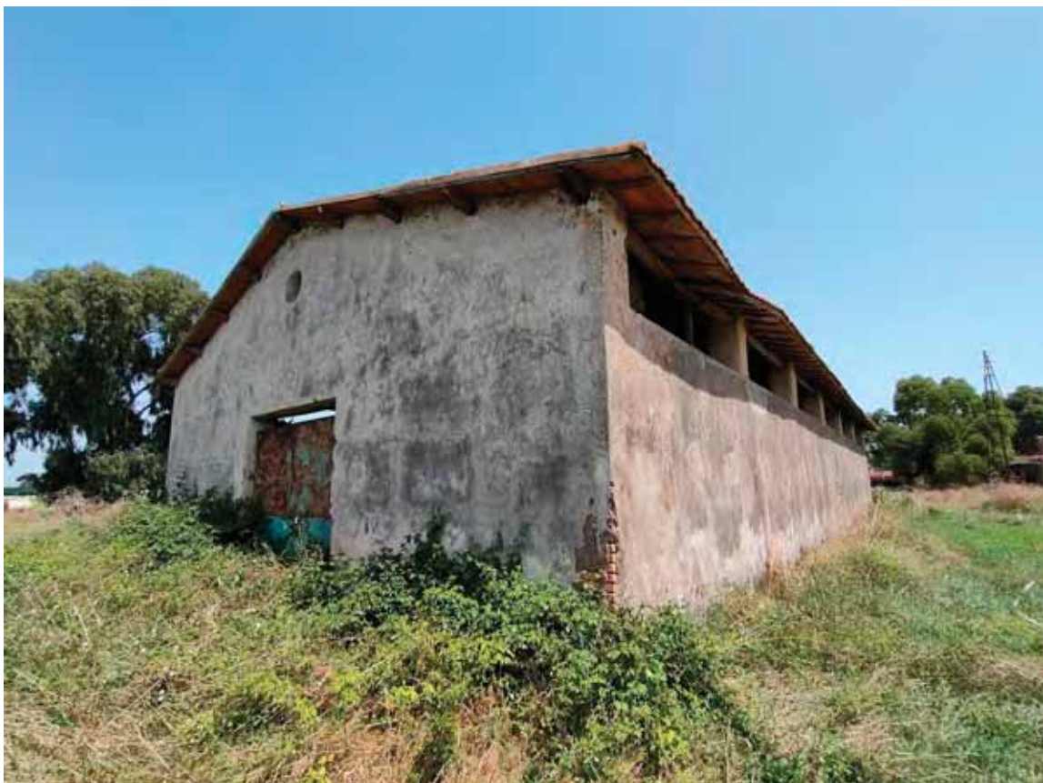
FOTO N. 52: Particolare fabbricato part. 118- esterno
