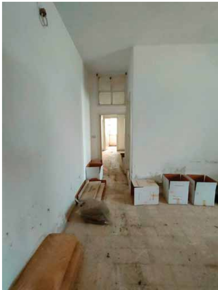
FOTO N.47: Particolare fabbricato part. 117- interno
