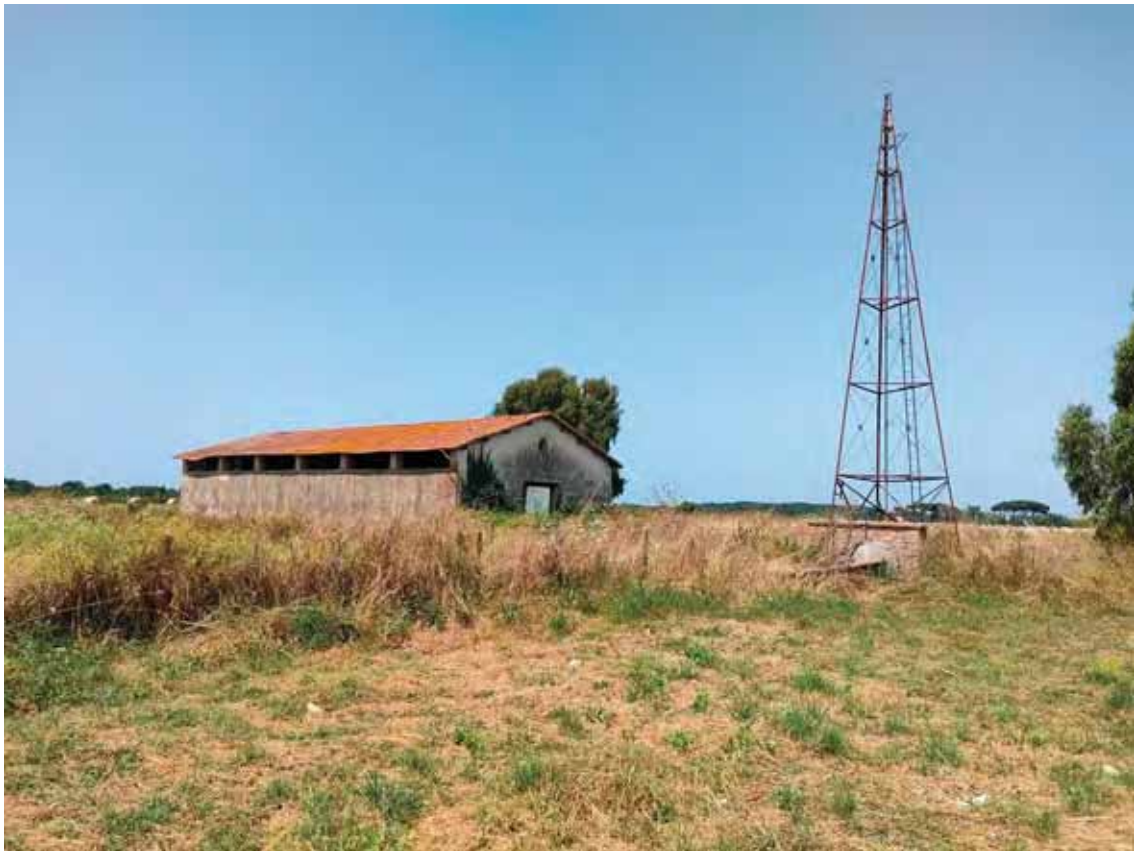
FOTO N. 51: Particolare fabbricato part. 118- esterno
