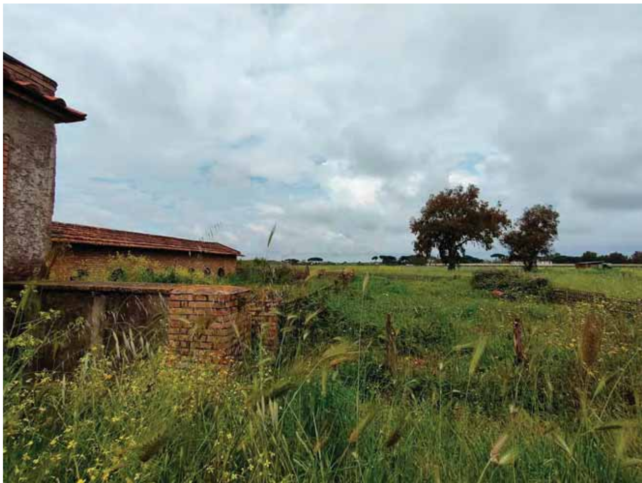
FOTO N. 37: Particolare fabbricato part. 117- esterno
