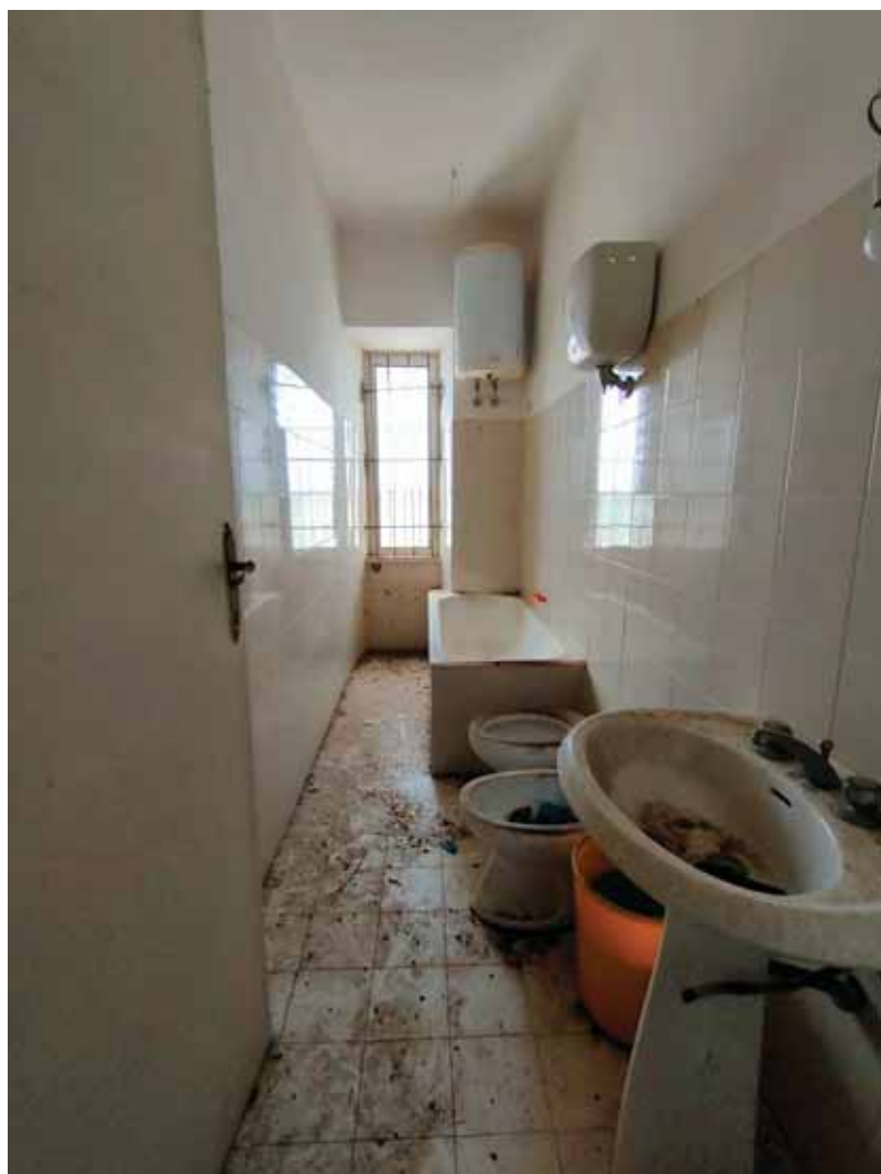
FOTO N. 48: Particolare fabbricato part. 117- interno
