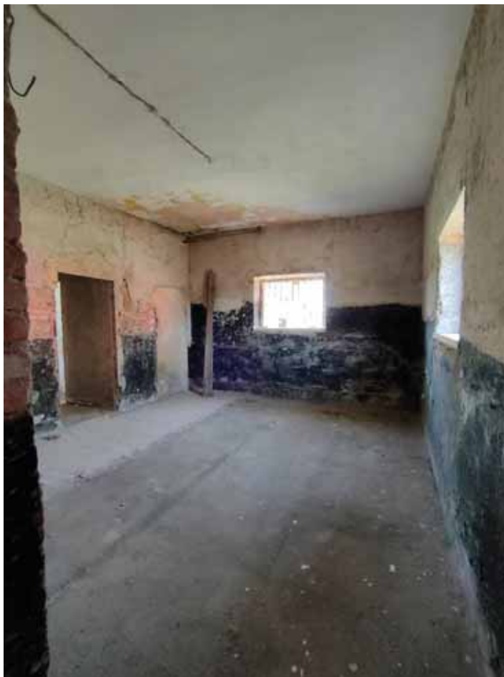
FOTO N. 13: Particolare interni – piano terra
