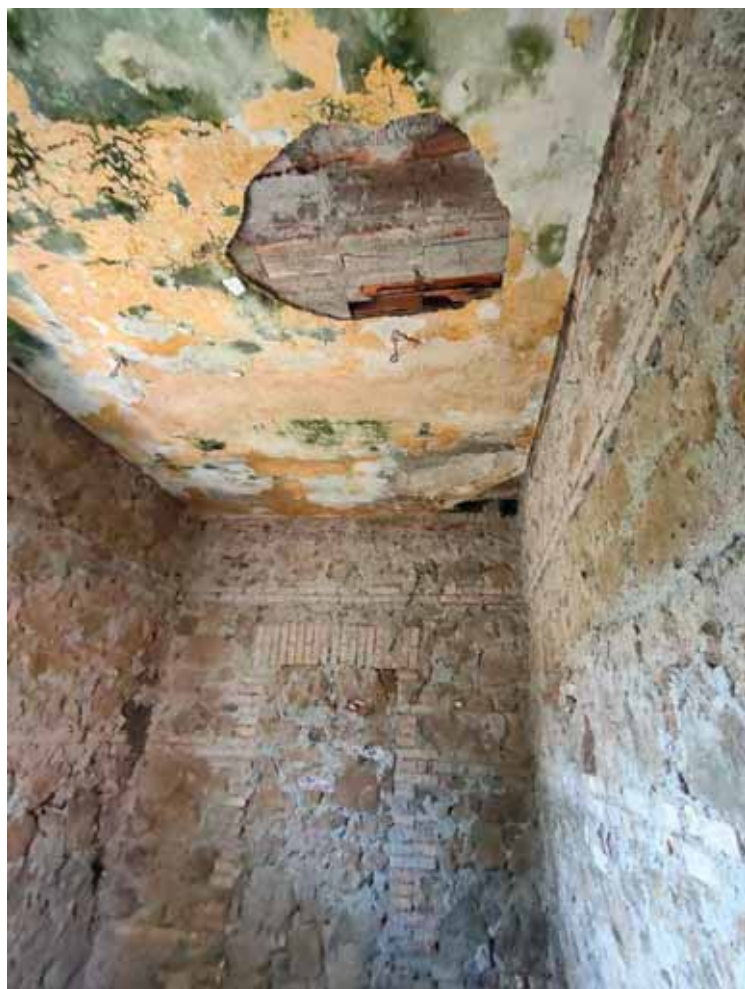
FOTO N. 15: Particolare interni – piano terra
