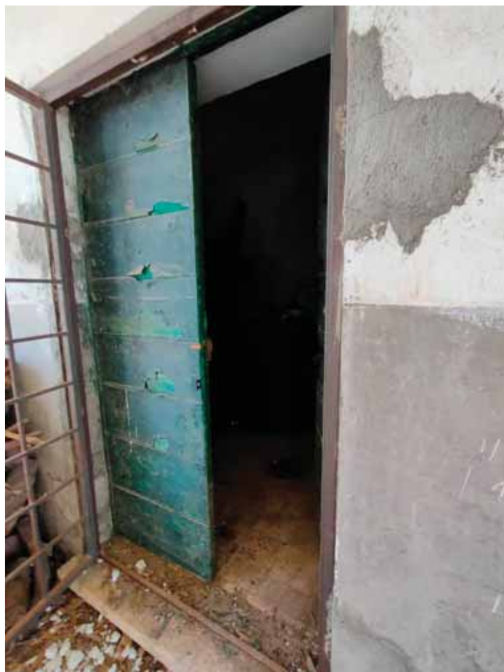
FOTO N. 44: Particolare fabbricato part. 117- interno
