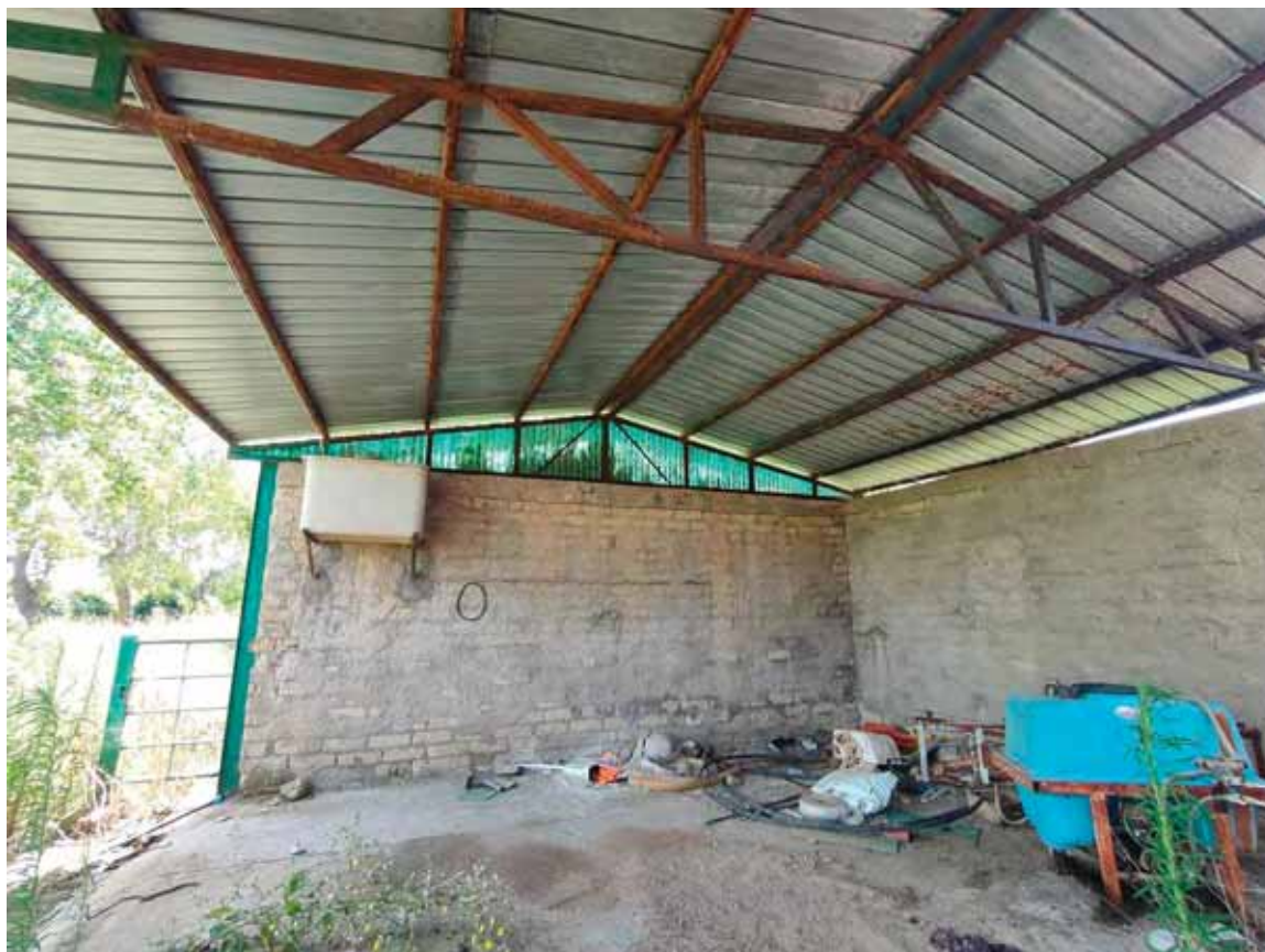
FOTO N. 53: Particolare fabbricato part. 115- interno
