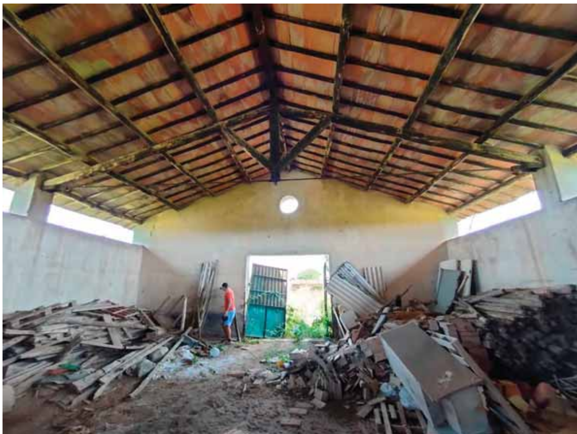
FOTO N. 54: Particolare fabbricato part. 118- interno
