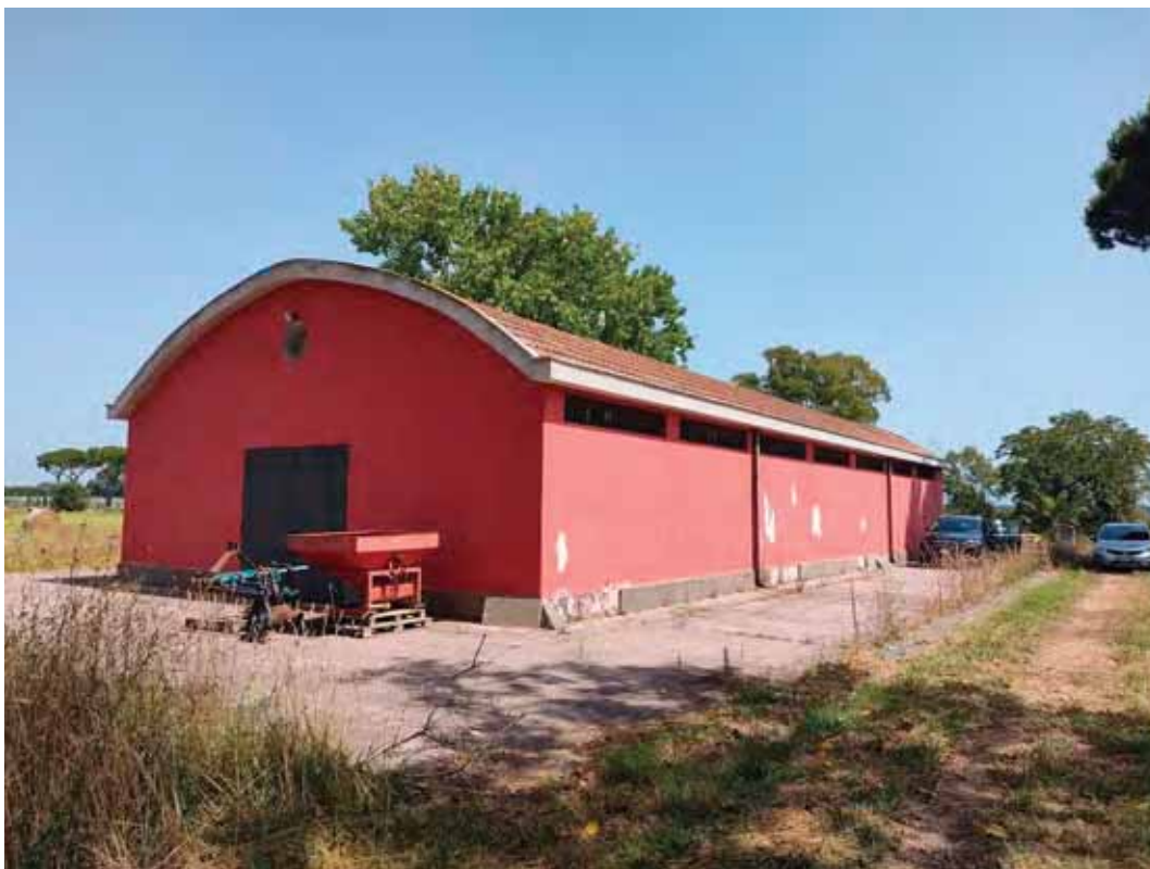
FOTO N. 4: Particolare fabbricato part. 111 - esterno
