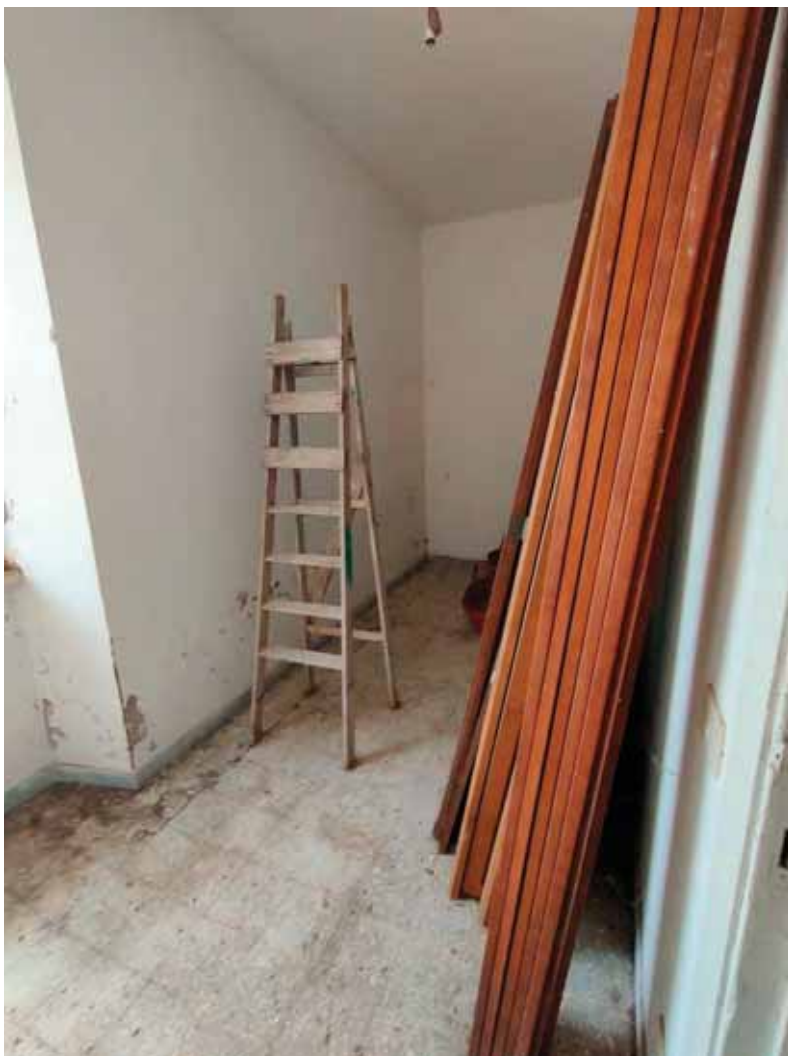
FOTO N. 50: Particolare fabbricato part. 117- interno
