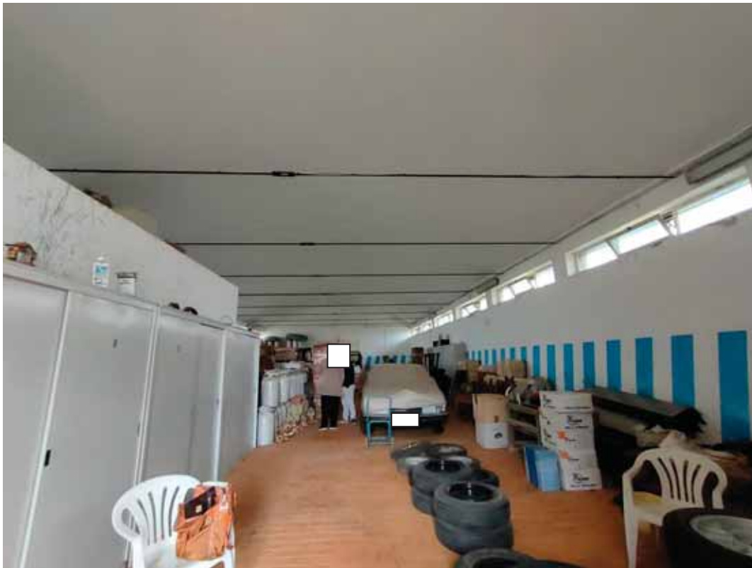
FOTO N. 6: Particolare fabbricato part. 111 - interno
