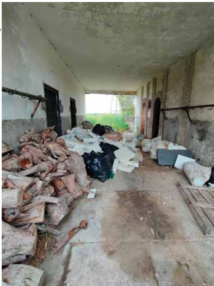
FOTO N. 38: Particolare fabbricato part. 117- interno
