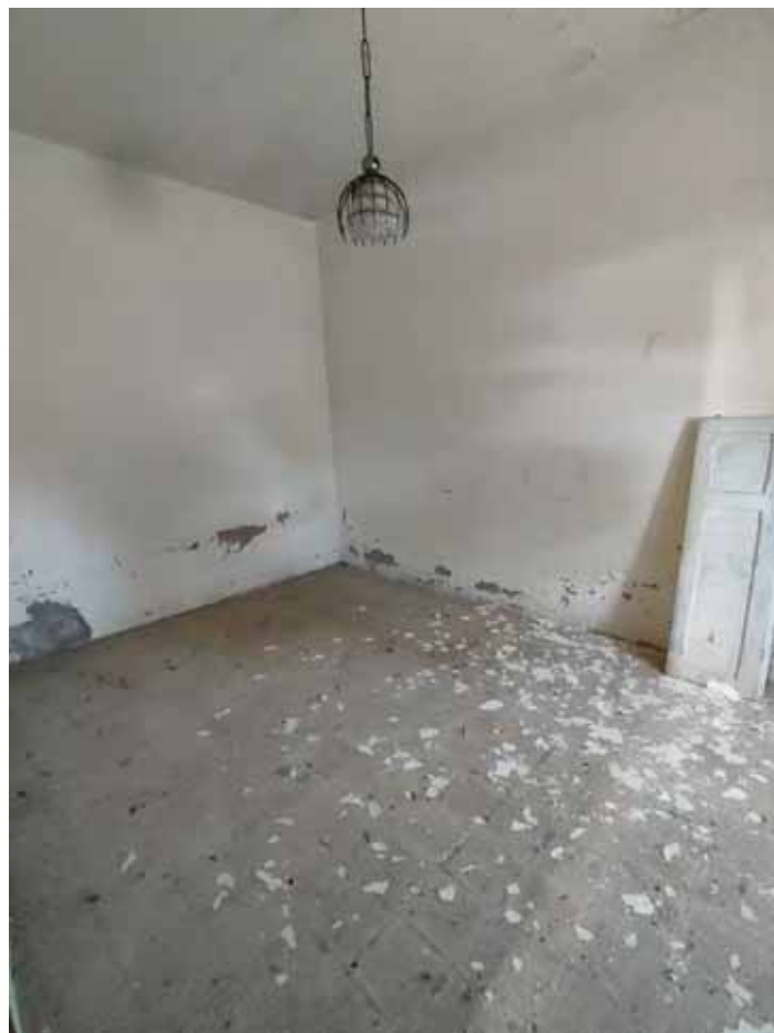
FOTO N. 42: Particolare fabbricato part. 117- interno
