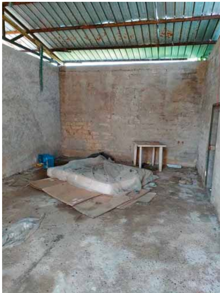
FOTO N. 54: Particolare fabbricato part. 115- esterno
