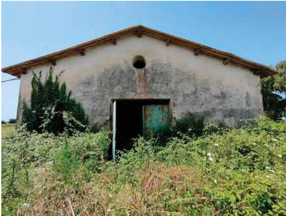
FOTO N. 53: Particolare fabbricato part. 118- esterno
