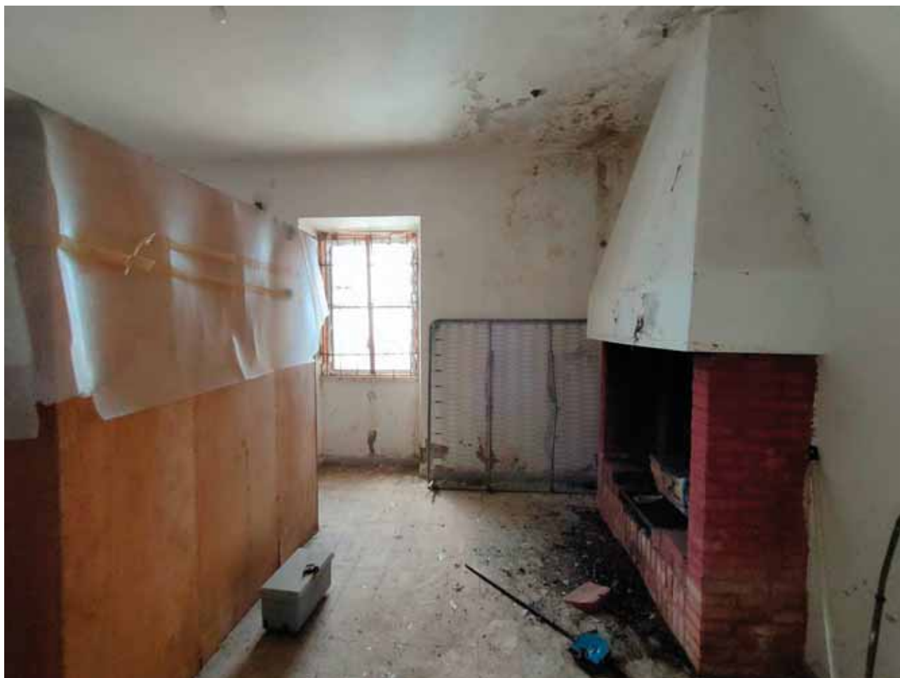
FOTO N. 46: Particolare fabbricato part. 117- interno
