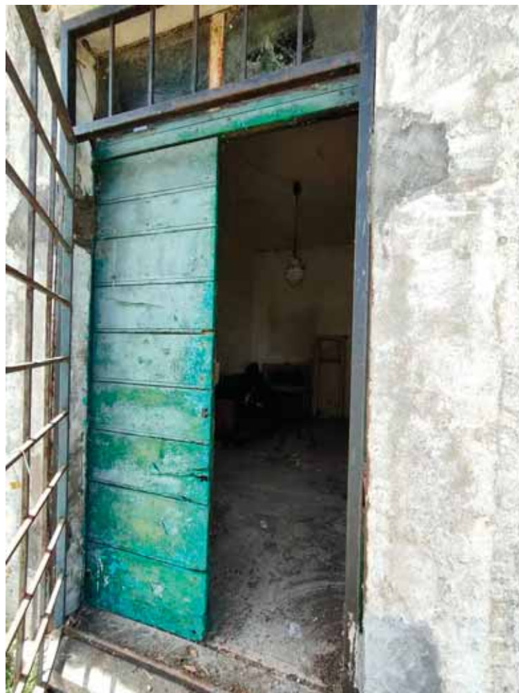
FOTO N.45: Particolare fabbricato part. 117- interno
