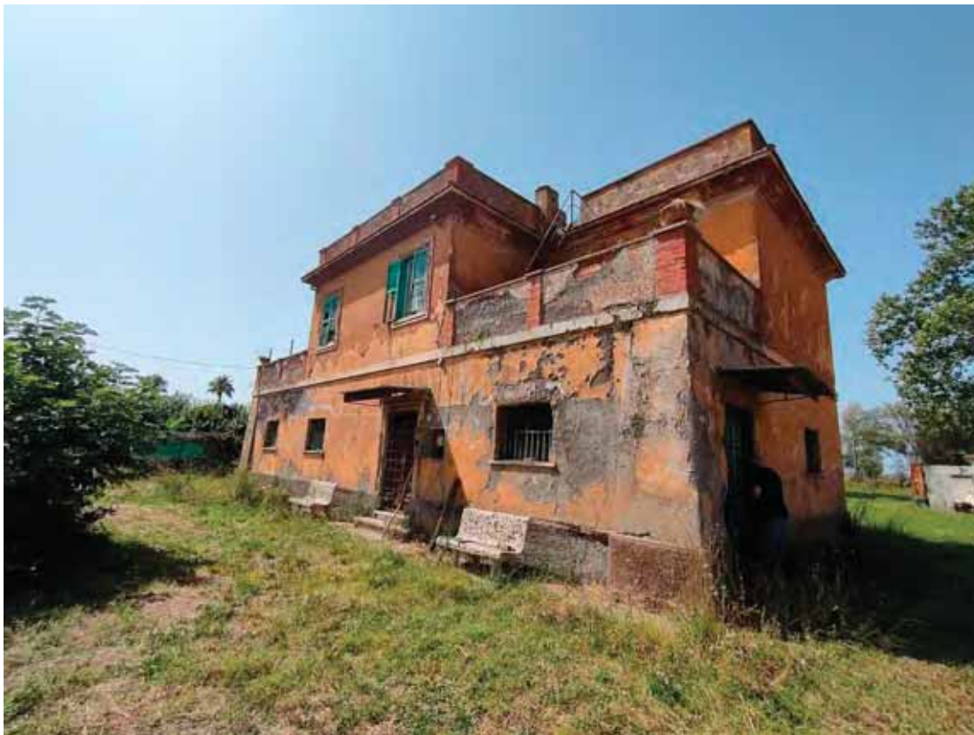
FOTO N. 8: Particolare fabbricato part. 112 - esterno
