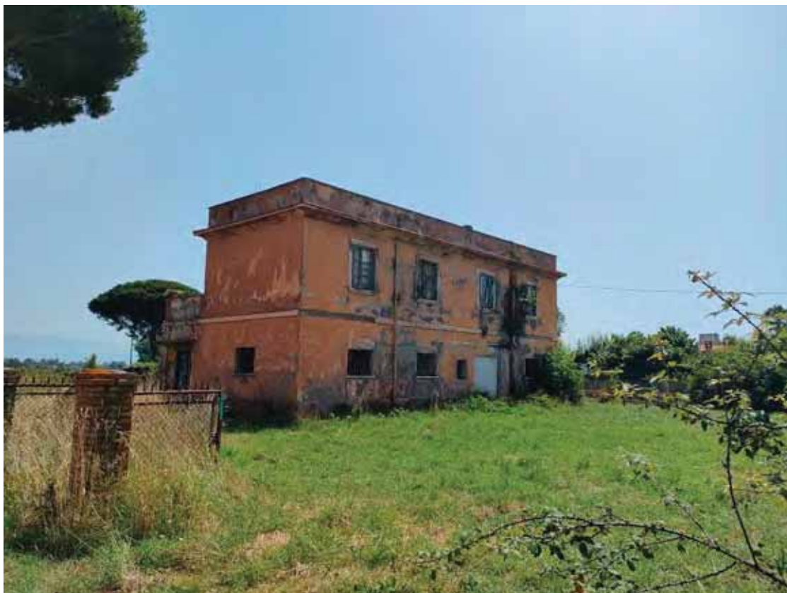
FOTO N. 9: Particolare fabbricato part. 112 - esterno
