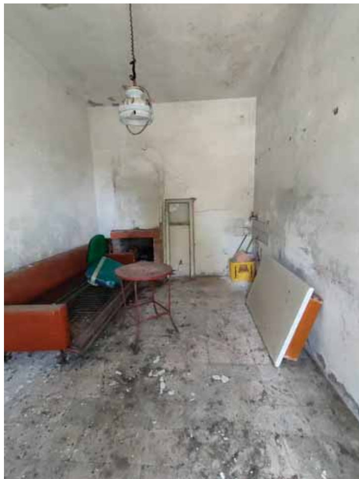
FOTO N. 40: Particolare fabbricato part. 117- interno
