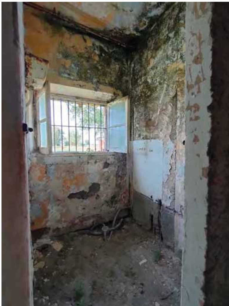
FOTO N. 14: Particolare interni – piano terra
