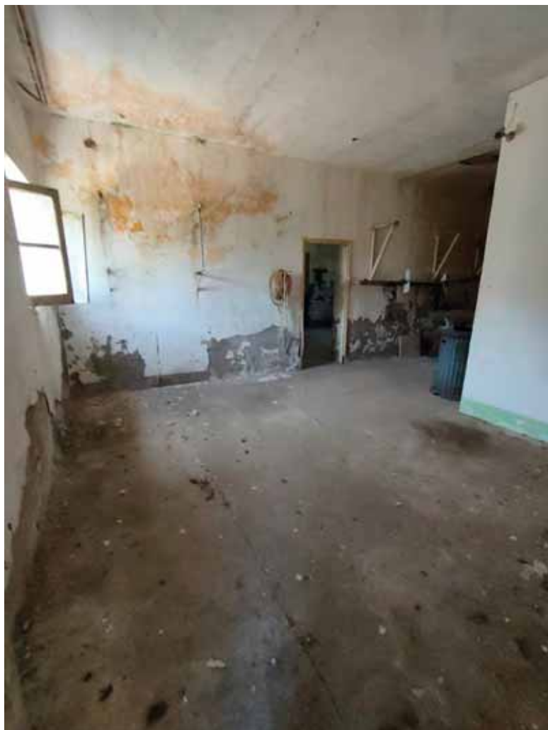
FOTO N. 17: Particolare interni – piano terra
