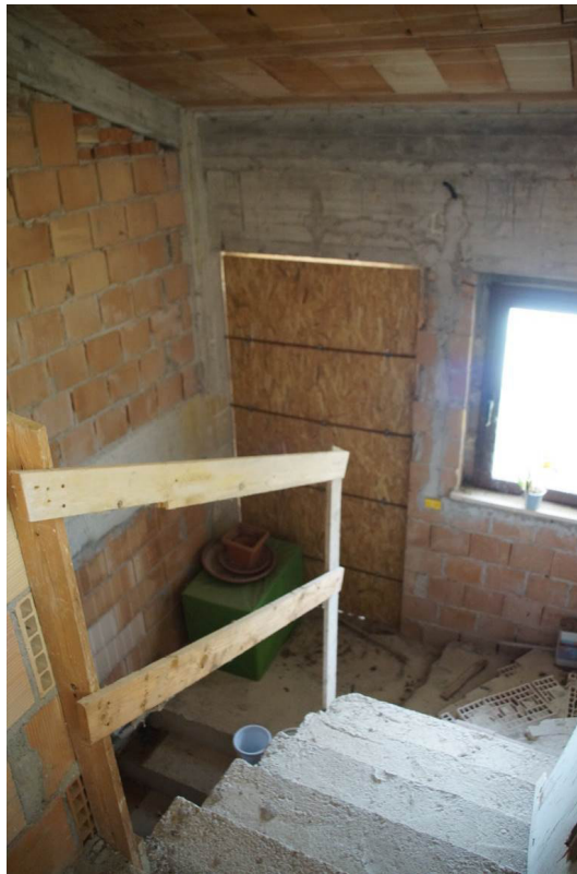
Foto n°17: particolare dell'accesso interno dal vano scala.
