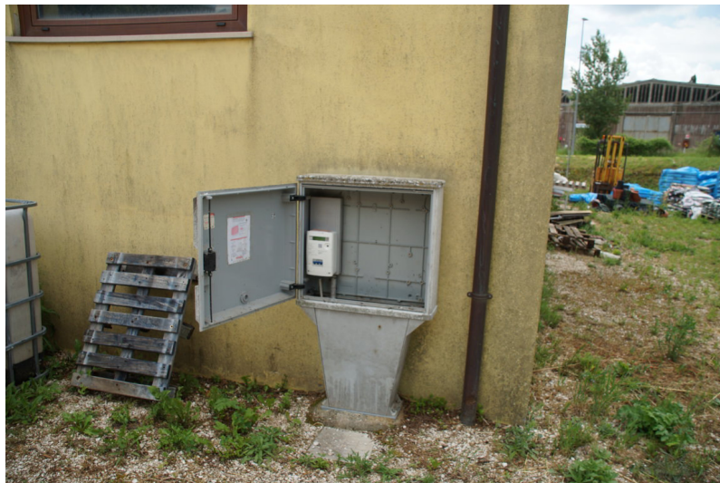
Foto n°16: particolare dell'alloggiamento del contatore della luce posto lungo il lato Nord dell'edificio.
