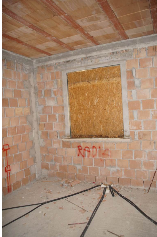
Foto n°23: particolare della terza camera da letto.
