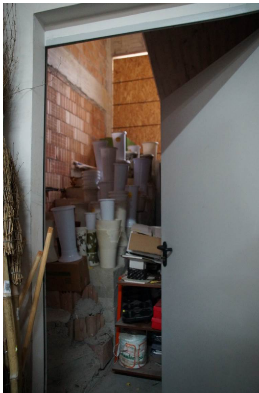
Foto n°10: particolare dell'accesso interno al vano scala che mette in comunicazione il capannone con l'appartamento.
