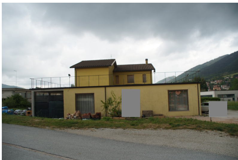
Foto n°2: altro particolare della vista lato Sud, si notino il tetto dell'appartamento a falda doppia ed i canali di gronda con i pluviali discendenti in rame.
