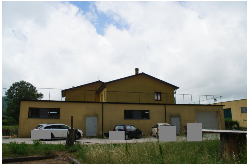
Foto n°4: vista lato Est del fabbricato.
