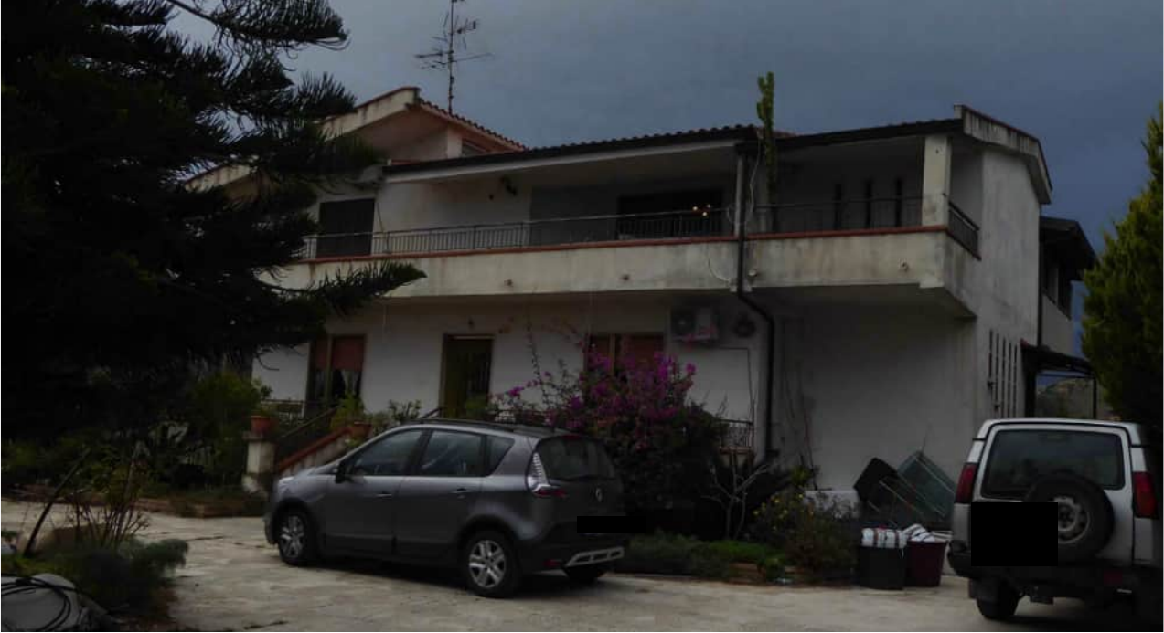
Foto Esterno 1. Fg 29 P.IIa 276 (Maggior fabbricato)
