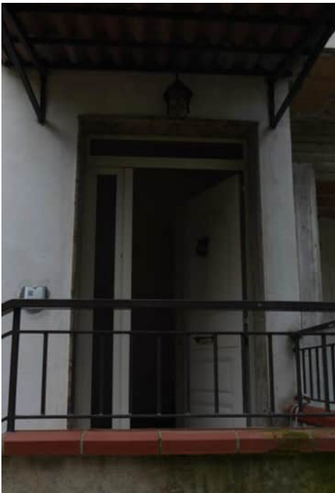
Foto Esterno 2. Fg 29 P.IIa 276 Ingresso Esterno al Sub 11
