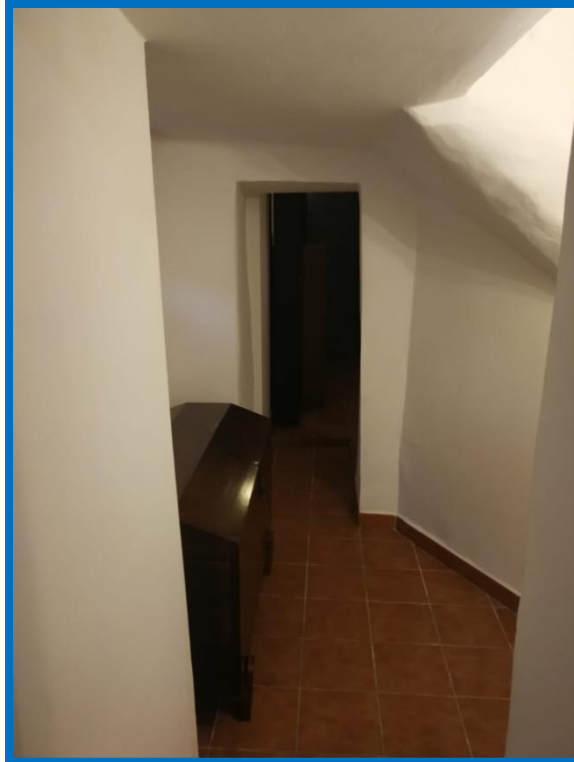
Foto n. 13 - Ingresso dal sottoscala (dal soggiorno al corridoio)
