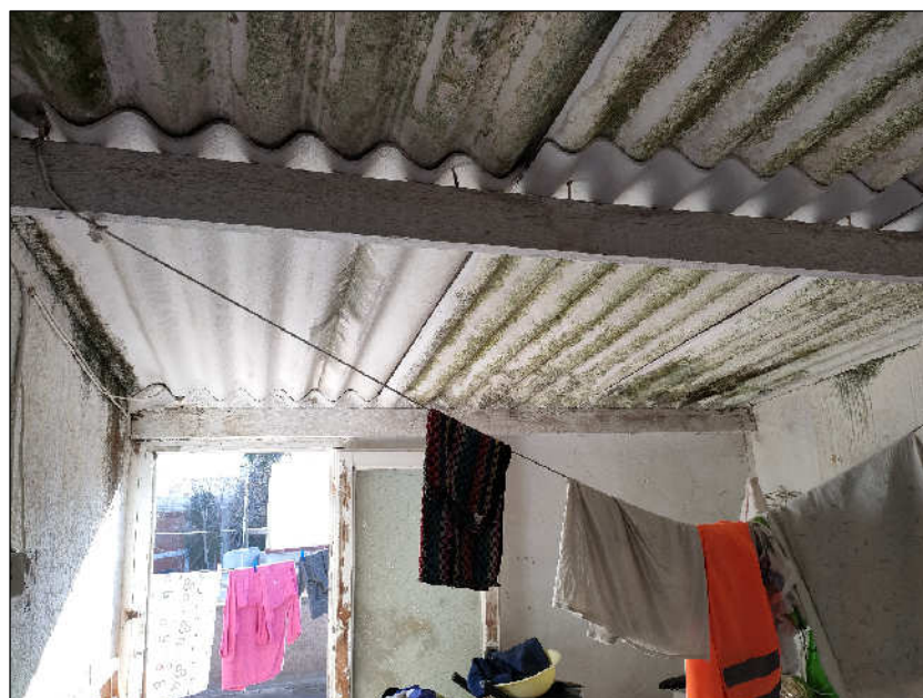
Foto n°16 : vista della copertura in eternit della lavanderia
