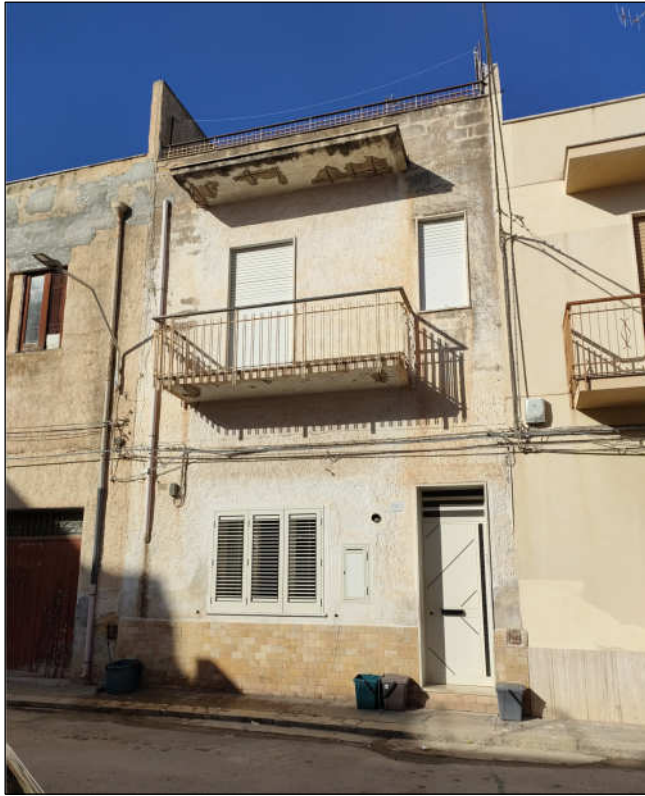
Foto n°1 : vista dall'esterno dell'edificio
