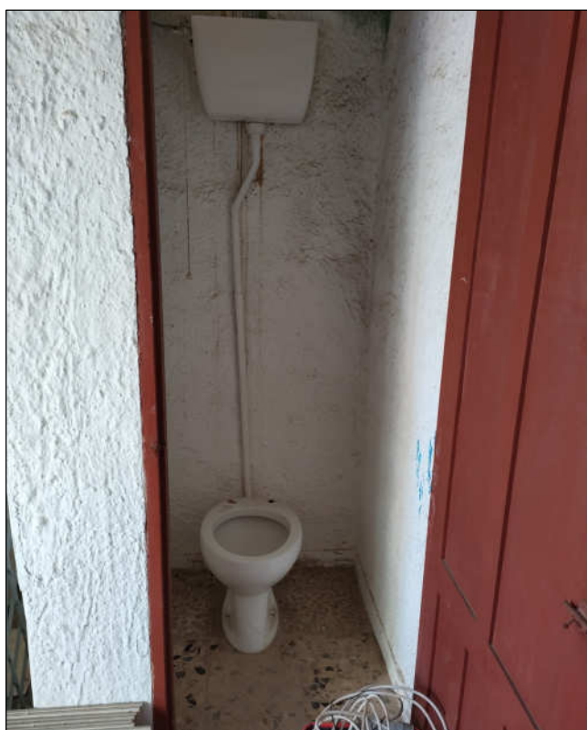
Foto n°15 : vista del bagno
