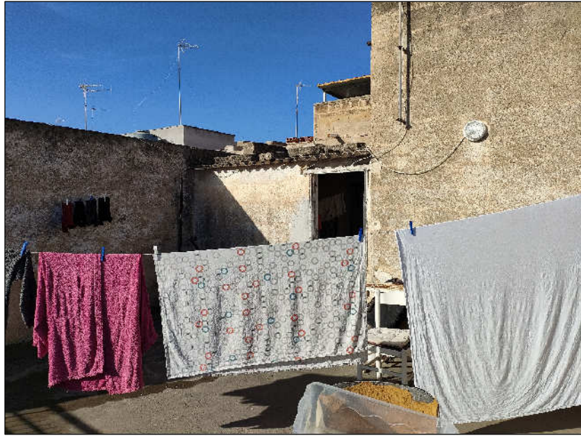
Foto n°17 : vista del terrazzo
