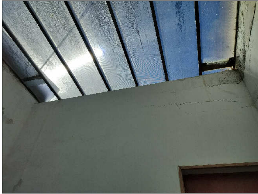
Foto n°11 : vista del lucernario
