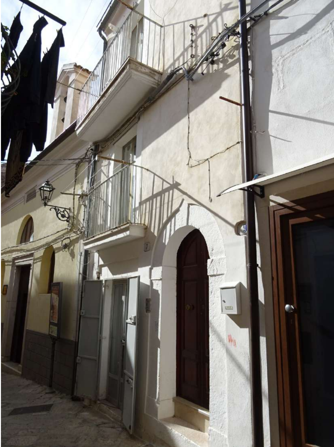
Foto quarto sopralluogo del 07.02.2024
