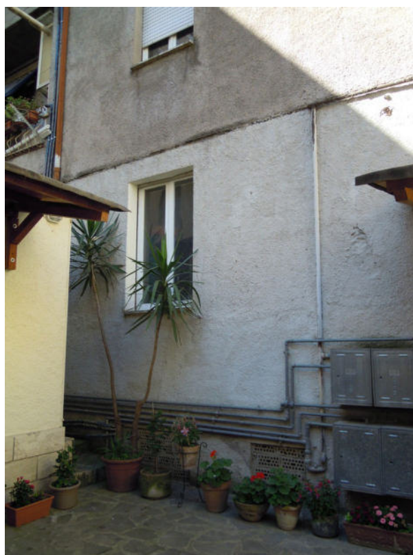
FOTO 16 – vista dal cortile interno
