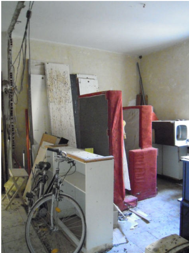
FOTO 5 – vista del soggiorno dal corridoio
