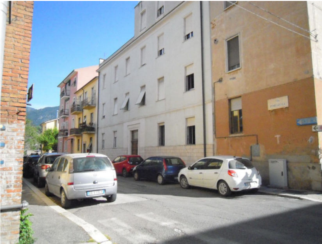
FOTO 1 – vista dell'edificio condominiale da via Eugenio Chiesa
