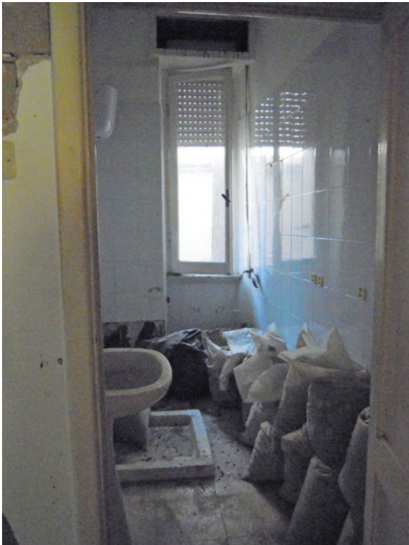
FOTO 7 – vista del WC
