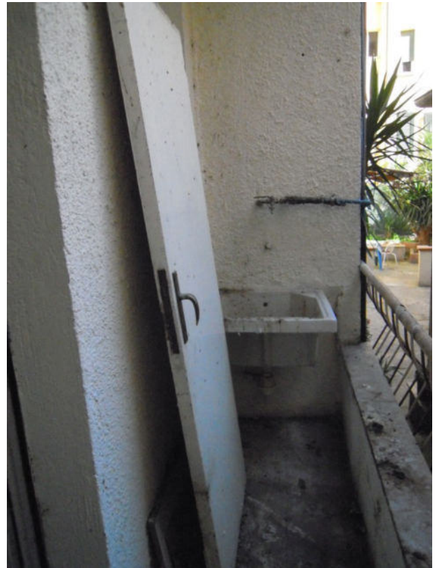
FOTO 12 – vista del terrazzino verso nord
