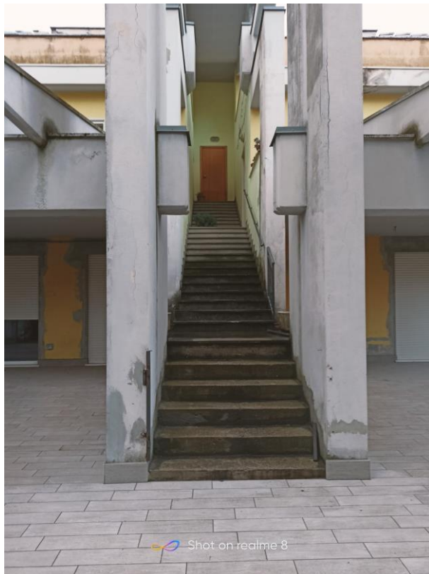
Foto 3 (vista scala esterna)
