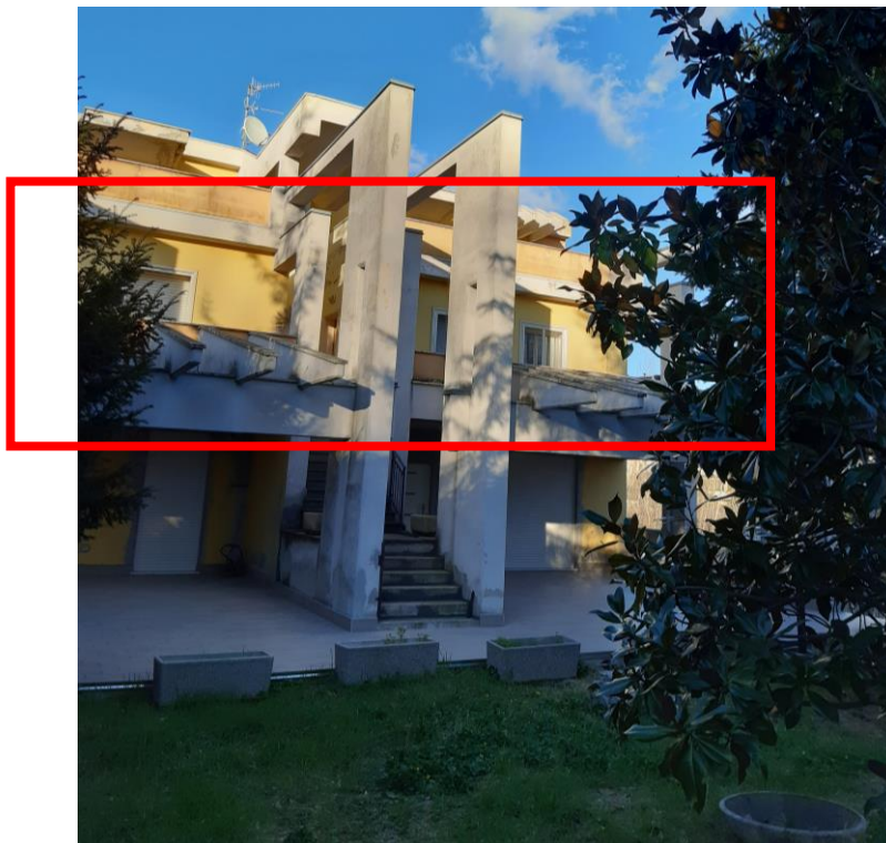
Foto 1 (vista prospetto su via Foggia)
