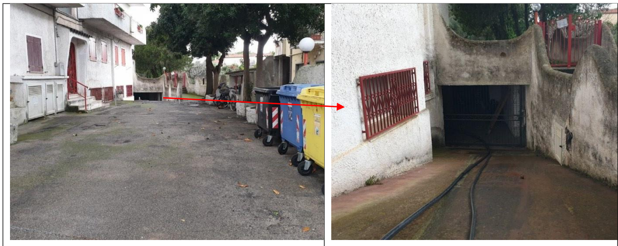
Figura 4 – Rampa di accesso al garage
