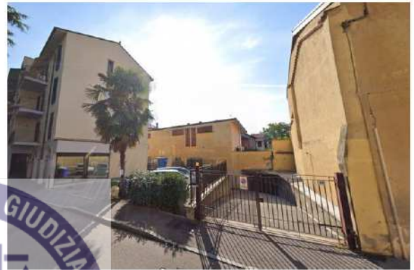
Ingresso al piano interrato
