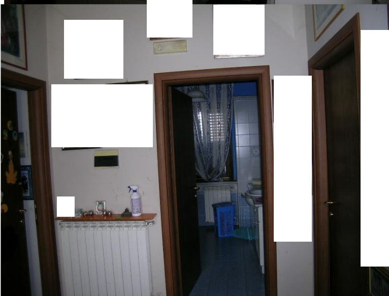
Foto 9 : Interni Corpo A bagno al primo piano
