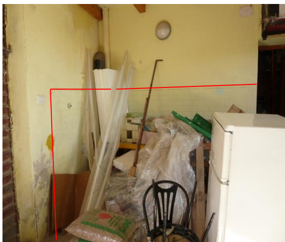
Foto n. 5 area ex bagno
