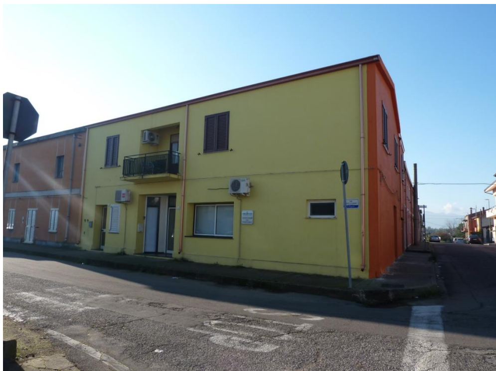
Foto n. 1 prospetto principale sulle via Dante e via Is Argiolas
