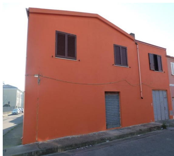
Foto n. 3 prospetto via Is Argiolas
