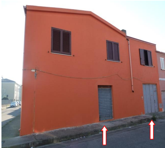
Foto n 1 fabbricato e accessi
