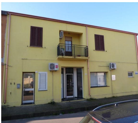
Foto n. 2 prospetto via Dante
