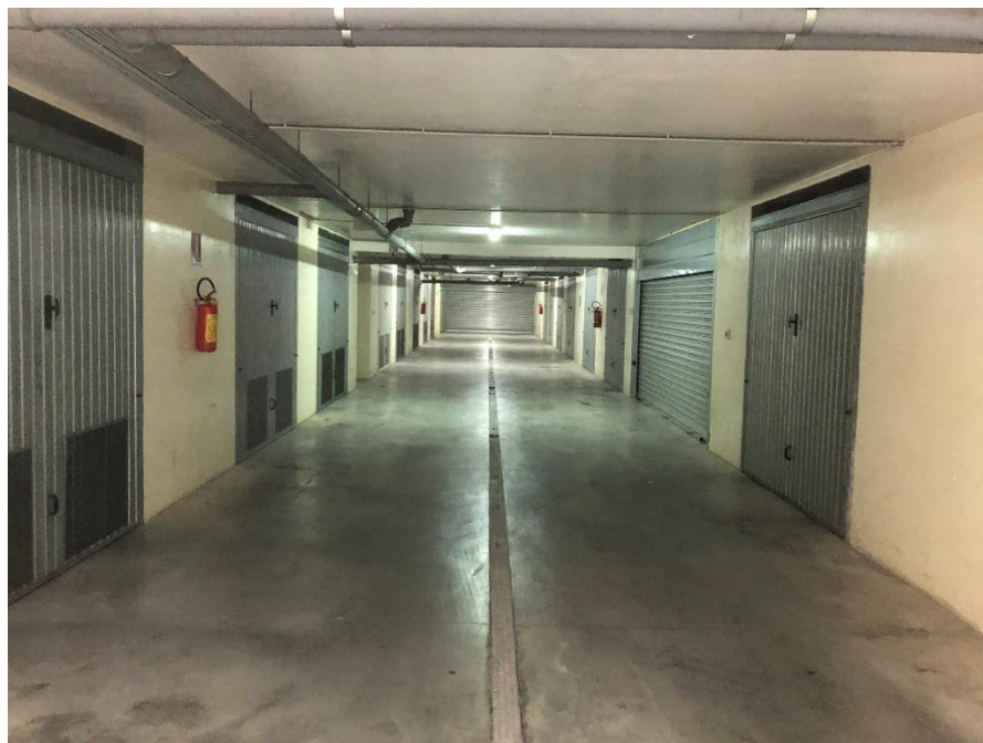
Foto n. 4: Area di manovra box
