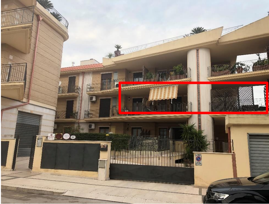
Foto n. 1: Ingresso fabbricato – via Aldo Moro n. 134
