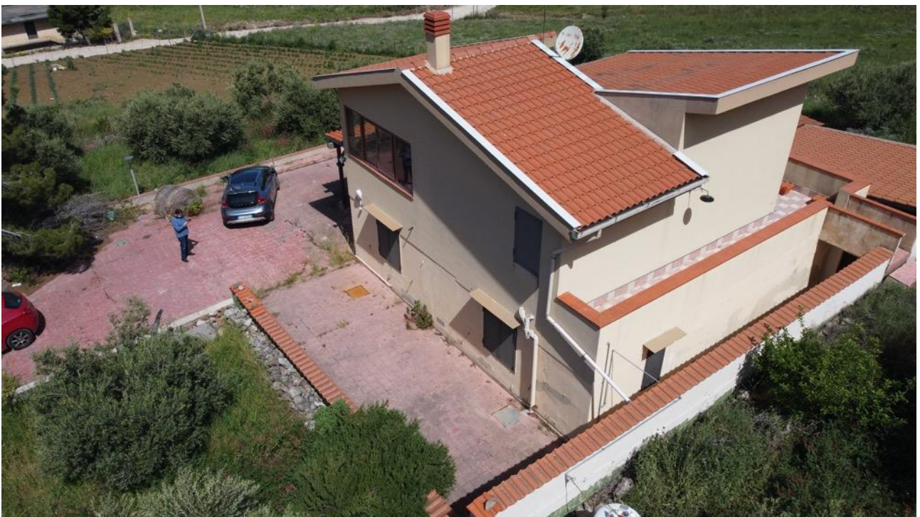
Foto 2 – Vista panoramica prospetto sud.
