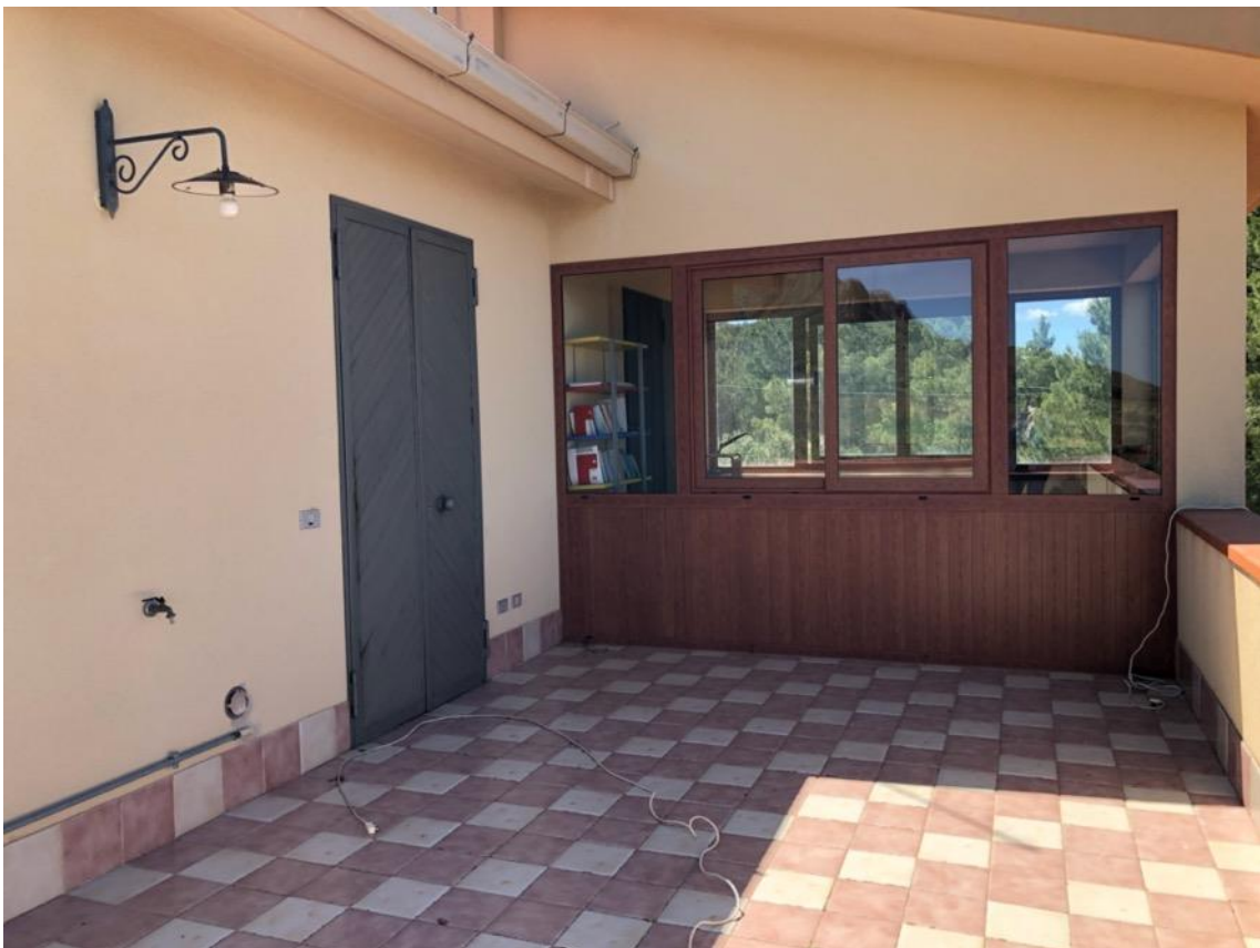
Foto 20 – Portico chiuso al piano terra
