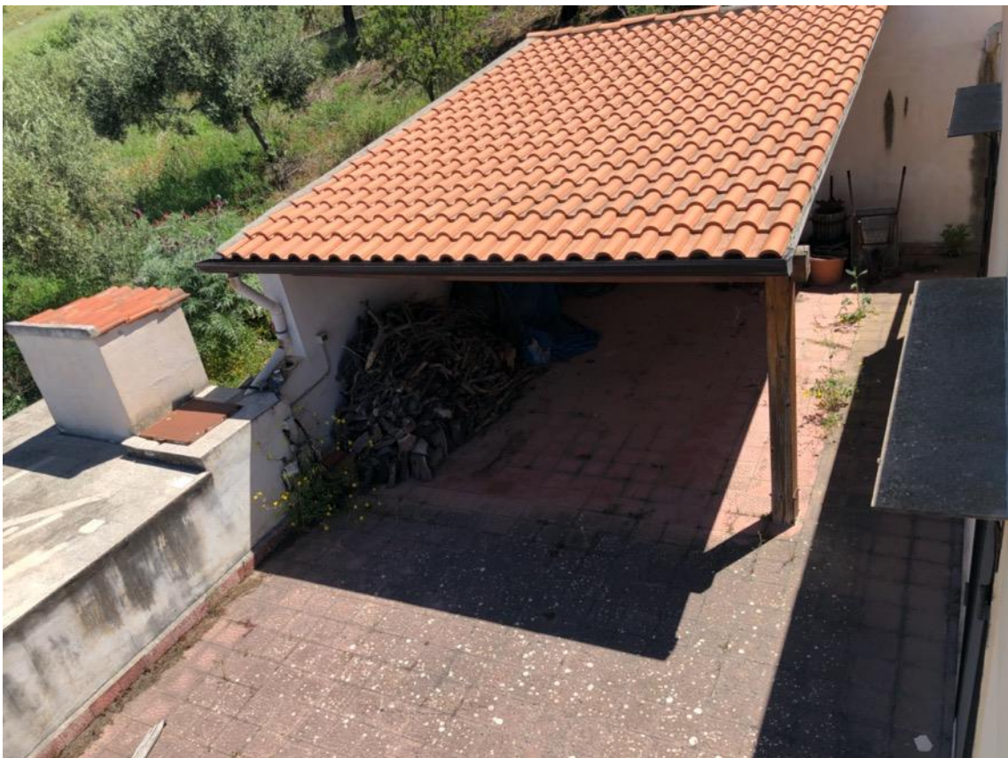
Foto 6 – Tettoia posta sul lato nord
