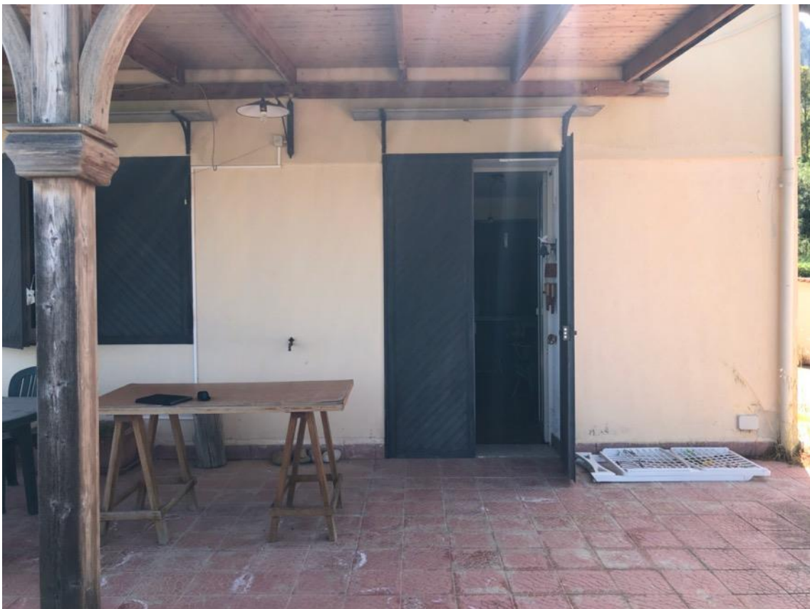
Foto 8 – Porta di ingresso al seminterrato
