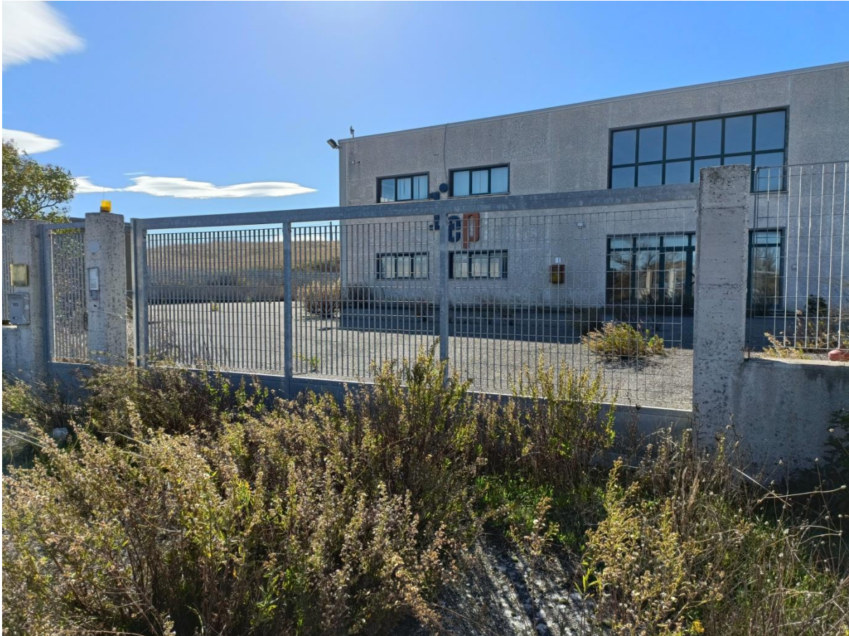
Figura 1 – Panoramica Ingresso Stabilimento.
