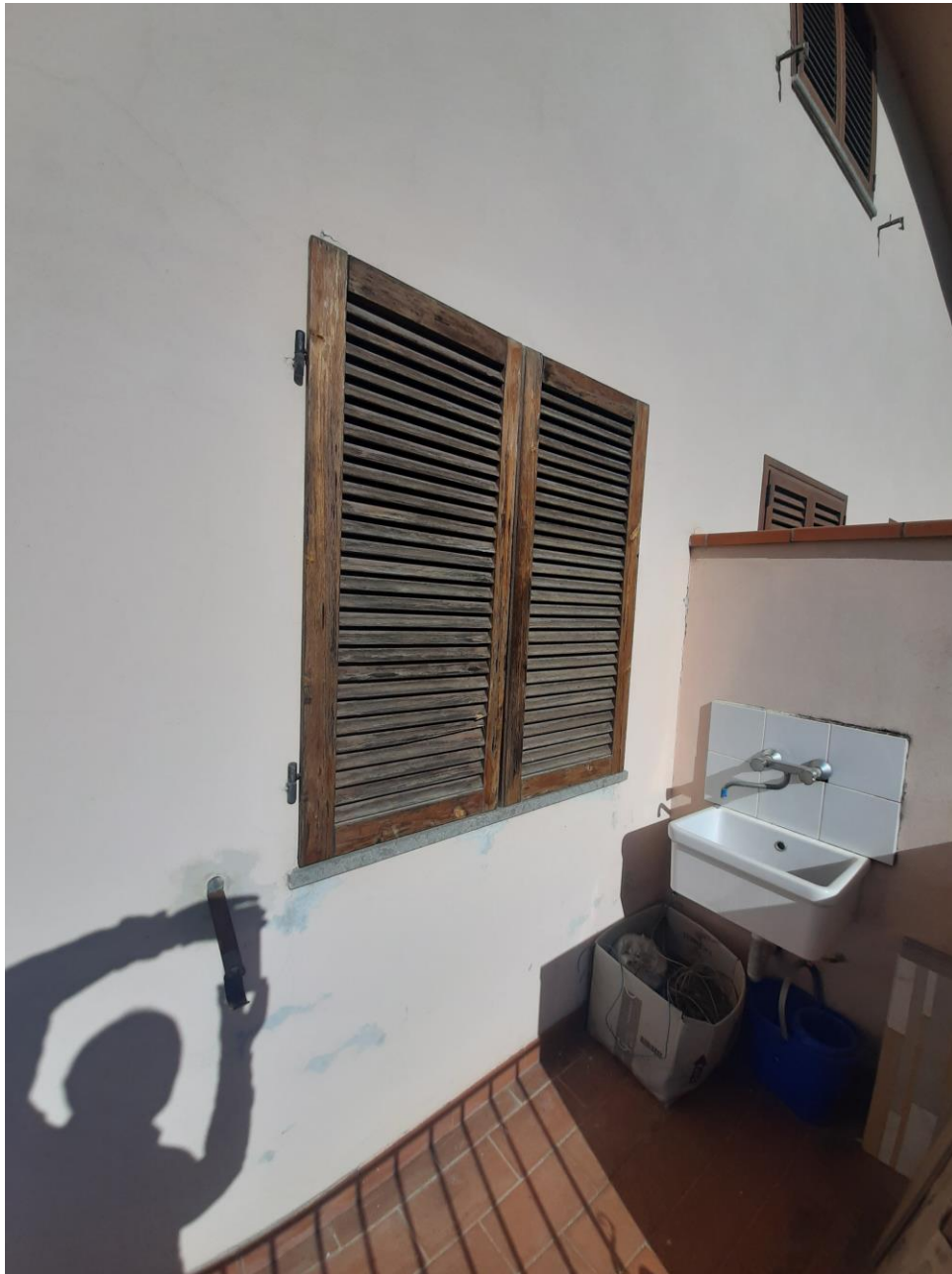
Foto n. 25 – pilozzo su balcone accessibile dalla camera
