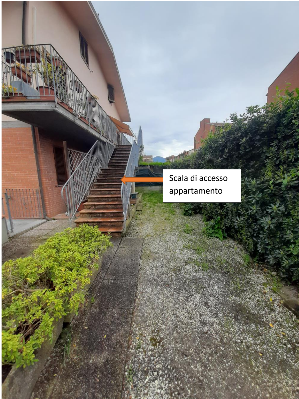
Foto n. 6 – lato est accesso al fabbricato
