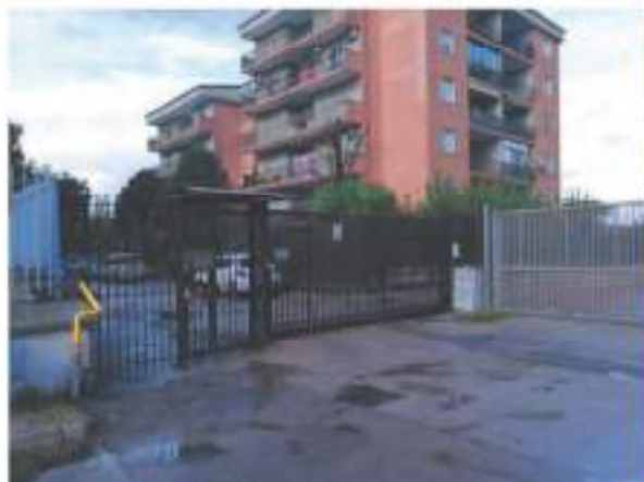
Vista Esterna ingresso alla p.la710
