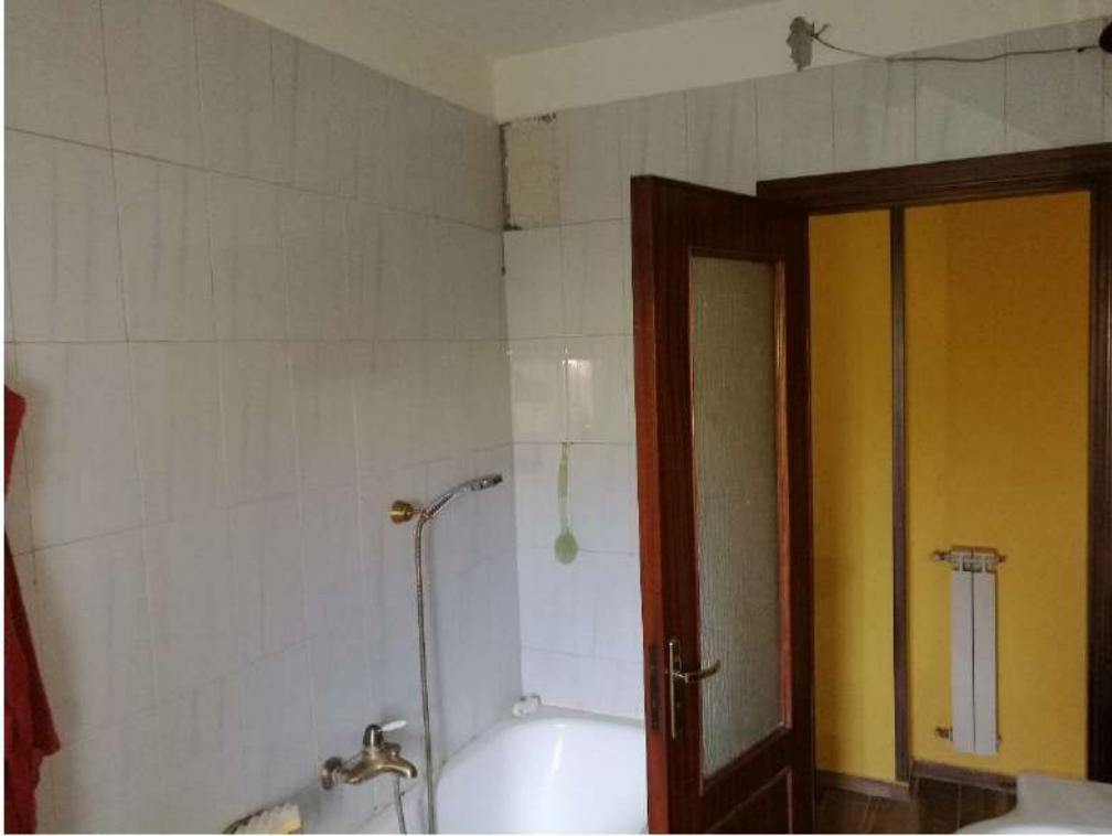
Foto n°21 : Vista Interna Bagno B2
