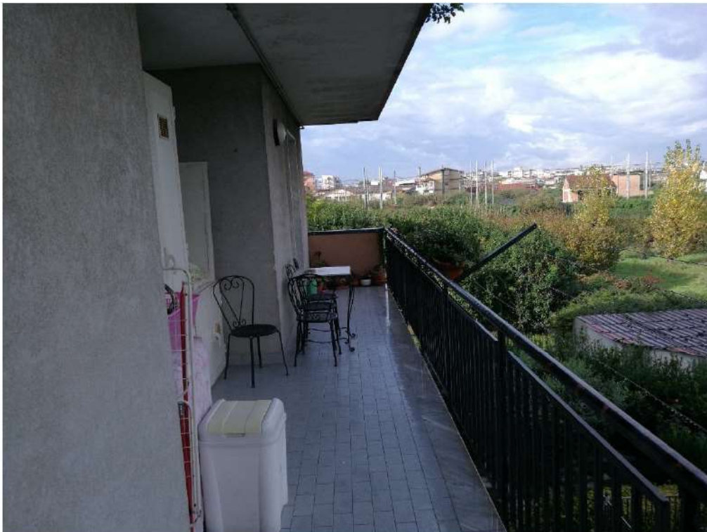
Foto n°16 : Vista Esterna Balcone lato Est
