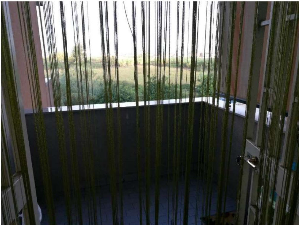
Foto n°12 : Vista Esterna Balcone angolo Sud-Est
