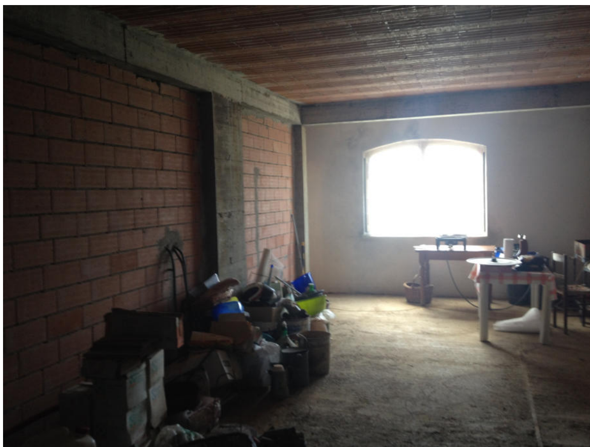
FOTO 27 - Bene n. 2: Magazzino, non ancora ultimato, si presenta a rustico ..
