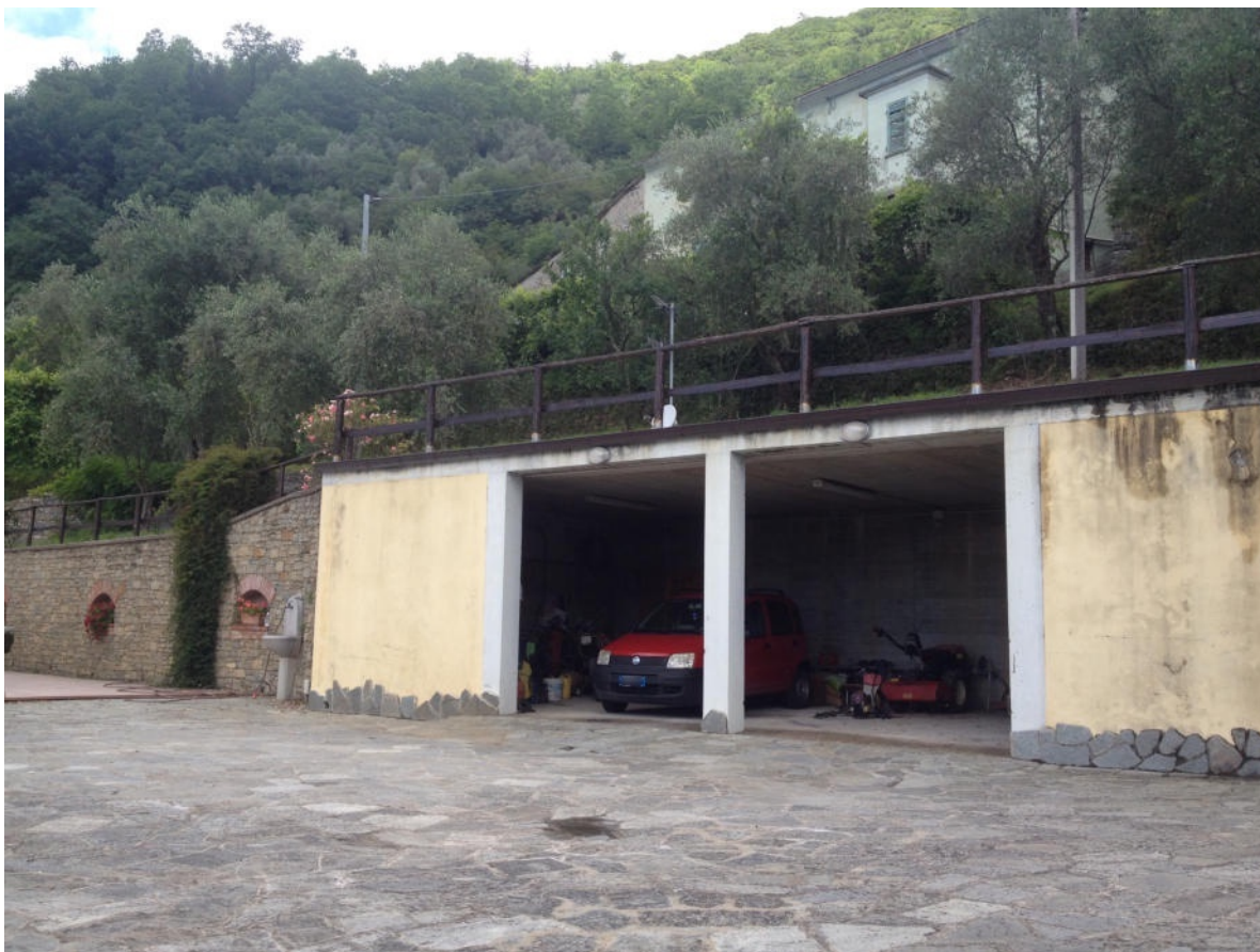
FOTO 31 - Bene n. 3: Autorimessa, ultimata a rustico.
