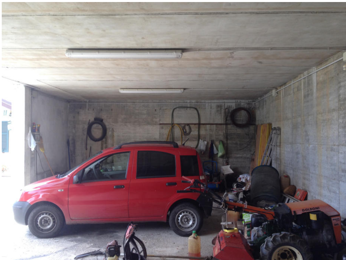
FOTO 33 - Bene n. 3: Autorimessa, ultimata a rustico.
