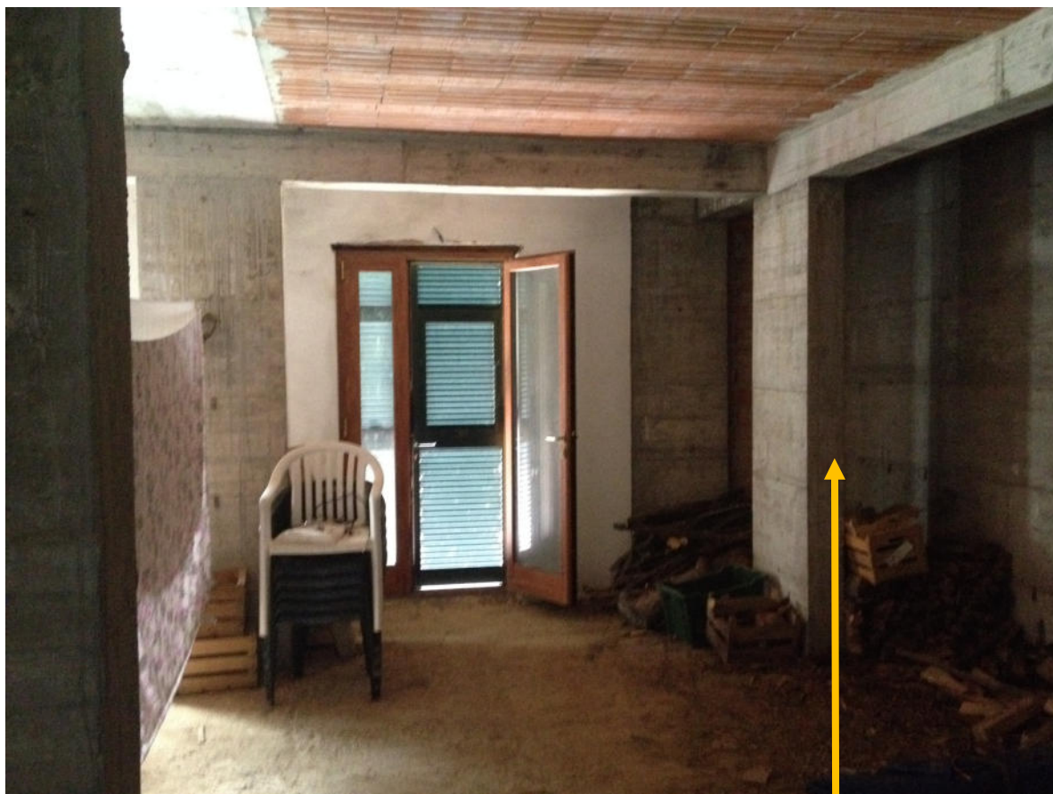
FOTO 28 - Bene n. 2: Magazzino, non ancora ultimato, si presenta a rustico ..
