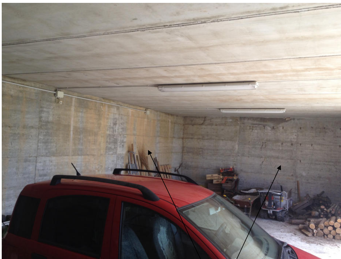
FOTO 34 - Bene n. 3: Autorimessa, ultimata a rustico.
