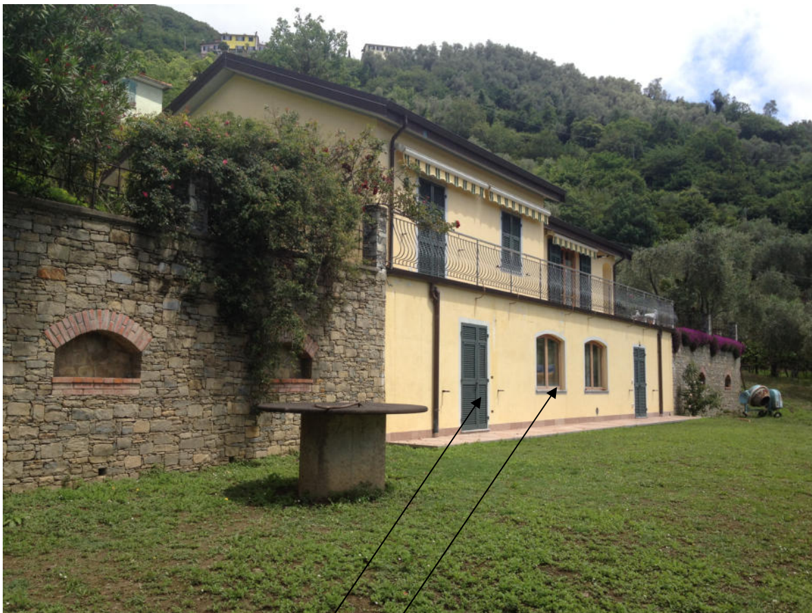
FOTO 5 - Bene n. 1 : Scorcio sud/ovest della villetta civ. 84 di via A. G. Norero. al piano seminterrato le finestre del Bene n. 2 (Magazzino)
