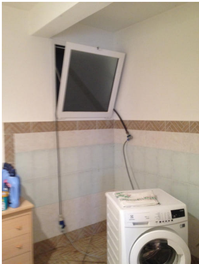
FOTO 23: Bene n. 1 : Bagno/lavanderia.
