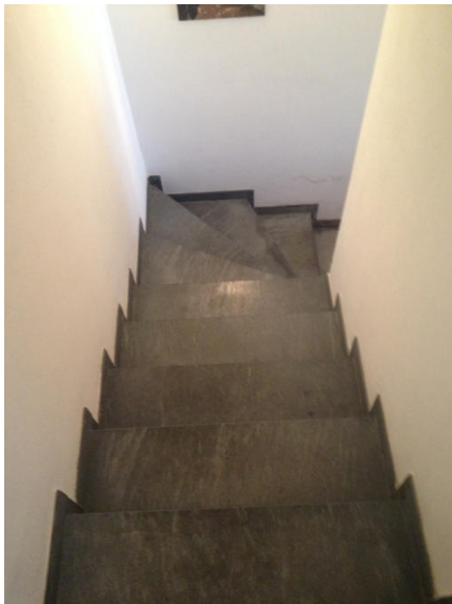
FOTO 24: Bene n. 1 : scala tra piano terra e piano 1°.
