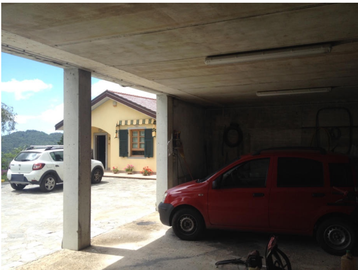
FOTO 32 - Bene n. 3: Autorimessa, ultimata a rustico.
