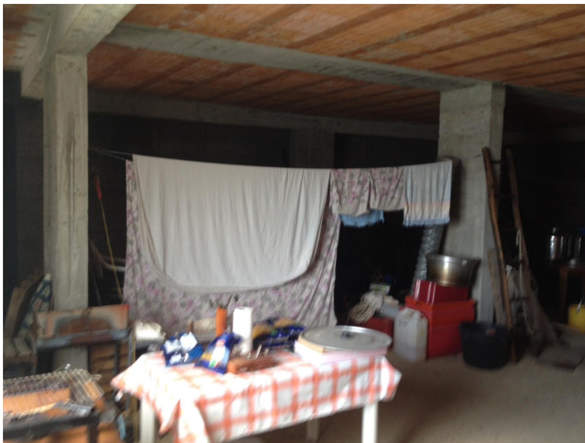
FOTO 25 - Bene n. 2 : Magazzino, non ancora ultimato, si presenta a rustico .
