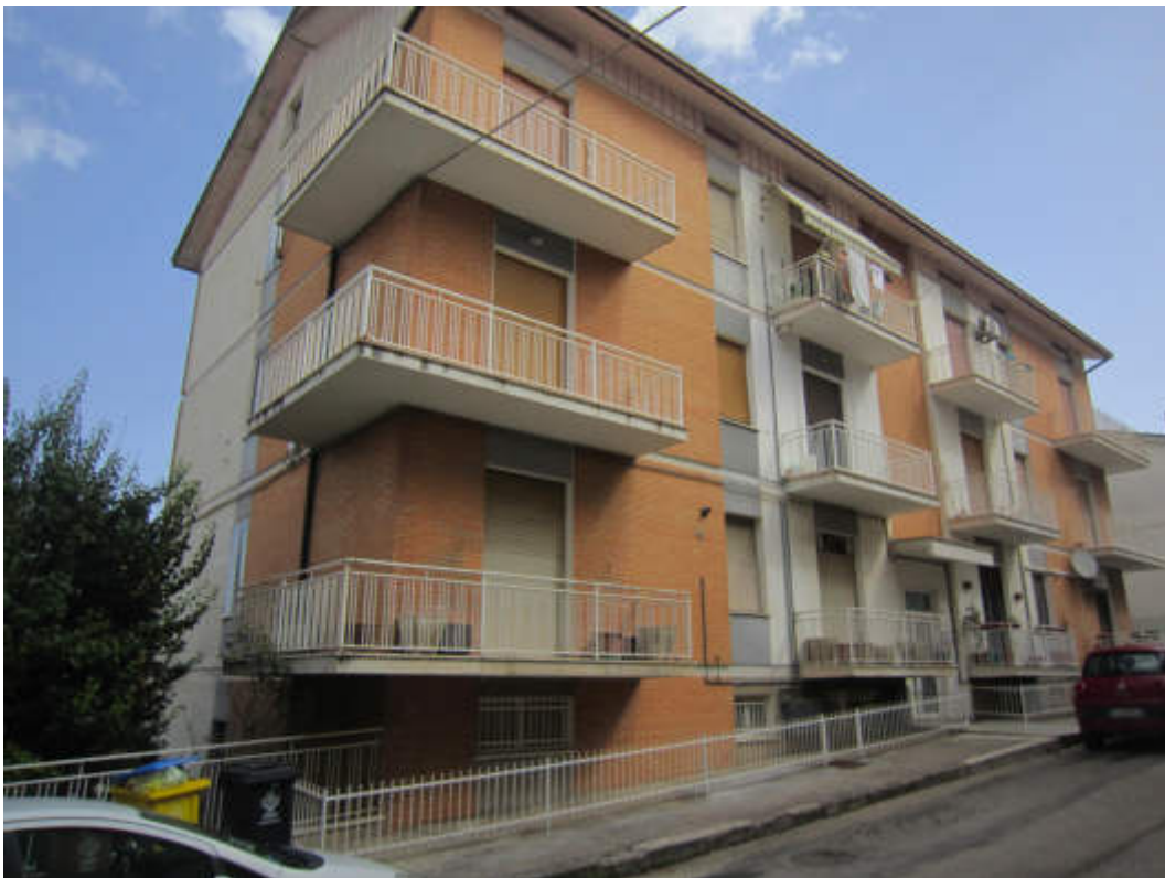
Foto n.06 (via G.Carducci-lato sud)
