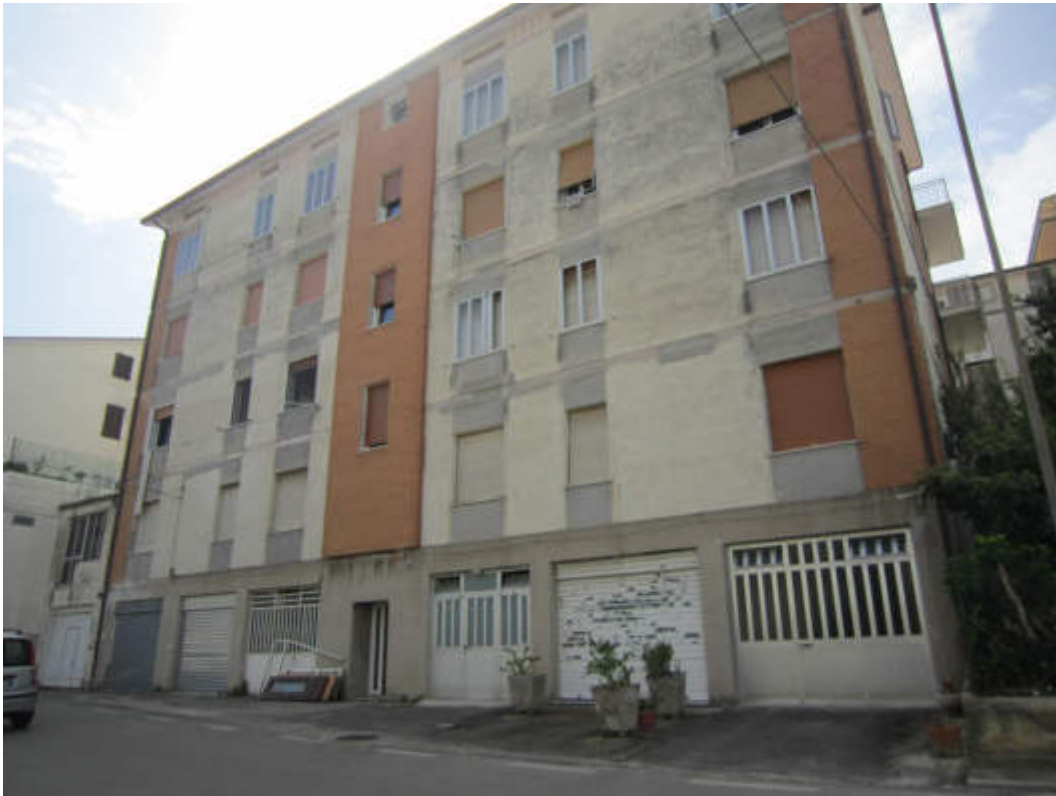
Foto n.05 (via Manzoni-lato nord)
