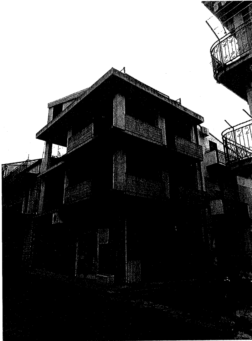
Figura 1 – Immobile identificato al Foglio 48, Part. 1842, Sub 2.
