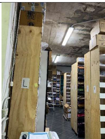
VISTA INTERNA SECONDO MAGAZZINO (Cespite 2)
