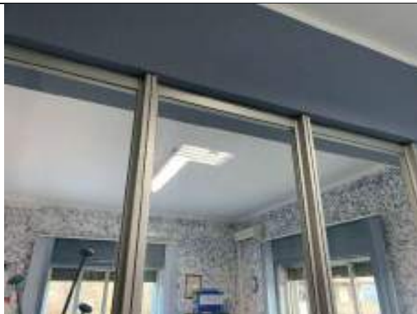
VISTA INTERNA NEGOZIO (Cespite 3) UFFICI
