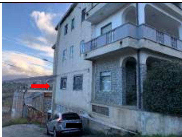
VISTA FRONTE NEGOZIO (Cespite 3) DA STRADA LATERALE
