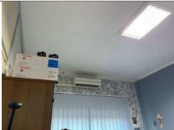
VISTA INTERNA NEGOZIO (Cespite 3) UFFICI
