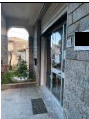
VISTA INGRESSO NEGOZIO (Cespite 3) PORTICO SU VIA M. di SAVOIA
