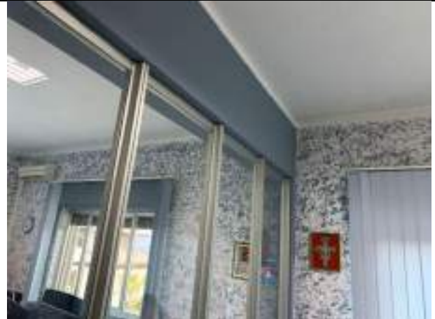
VISTA INTERNA NEGOZIO (Cespite 3) UFFICI
