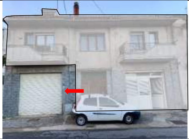
VISTA INGRESSO MAGAZZINI (Cespiti 1 e 2) DA VIA M. di SAVOIA
