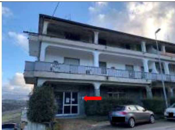
VISTA INGRESSO NEGOZIO (Cespite 3) DA VIA M. di SAVOIA
