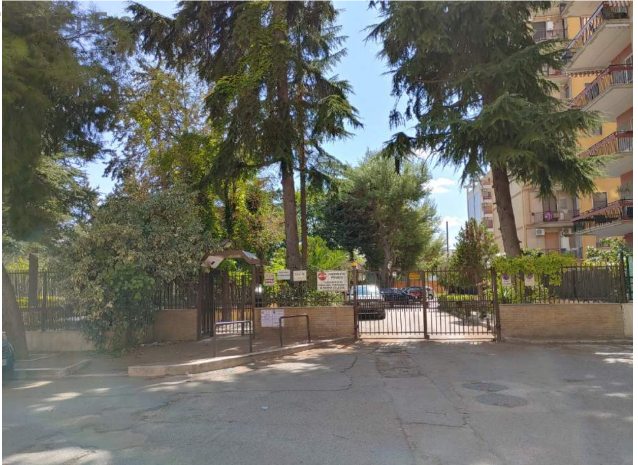
Foto C3 - STABILE DI VIA R. GRIECO N. 19 - FOGGIA
