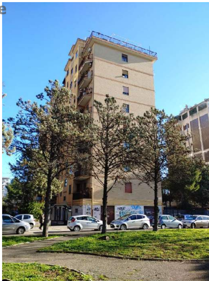
FOTO C1 - STABILE DI VIA R. GRIECO N. 19 - FOGGIA
