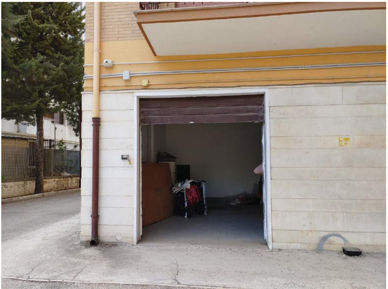
Foto C22 - BOX AUTO AL PIANO TERRA - INGRESSO
