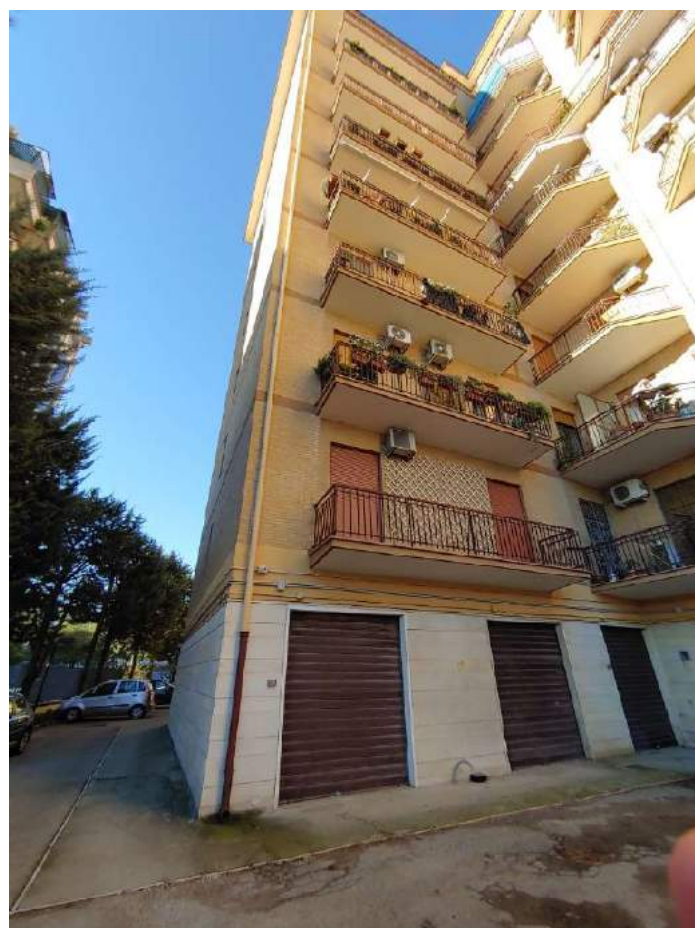
FOTO C2 - STABILE DI VIA R. GRIECO N. 19 - FOGGIA
