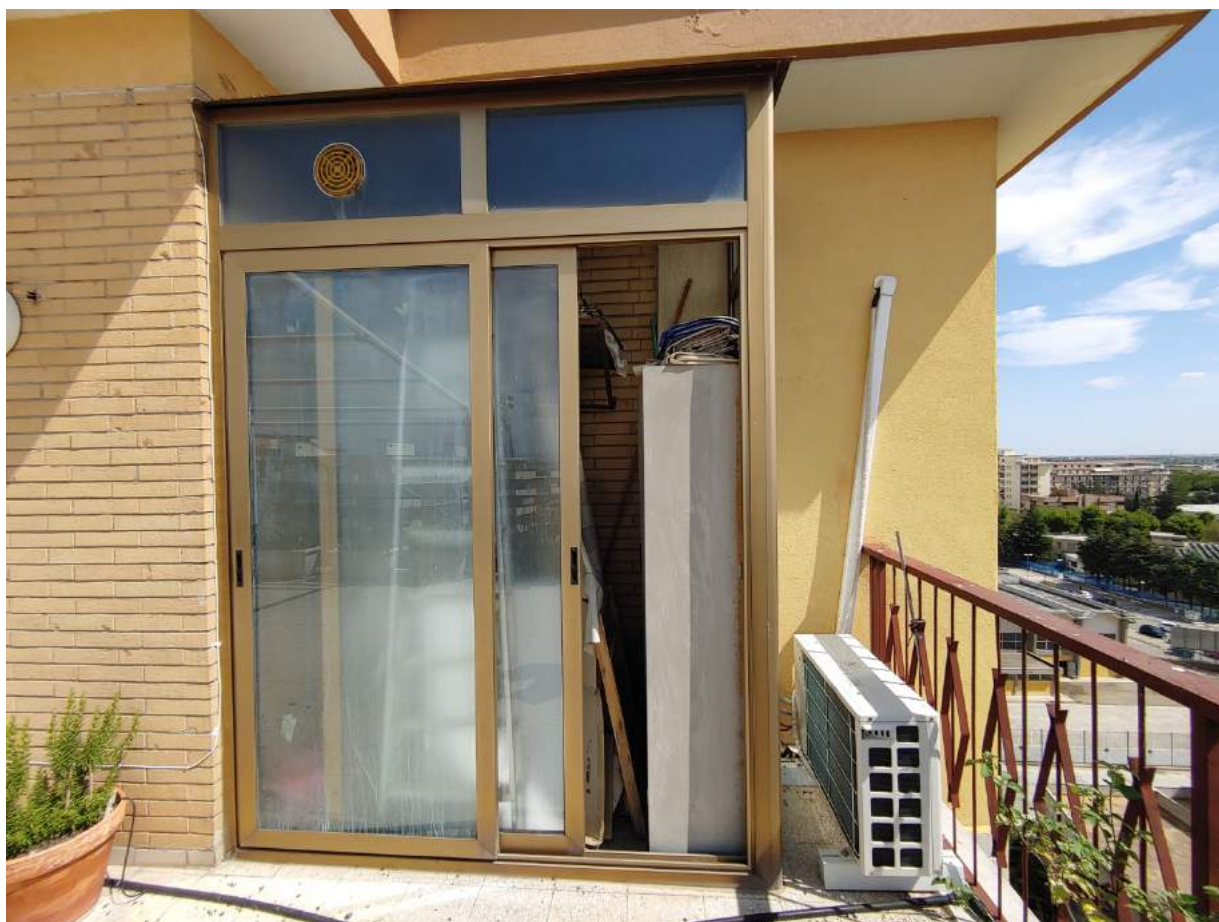
Foto C20 - APPARTAMENTO PIANO ATTICO - TERRAZZO - RIPOSTIGLIO ABUSIVO
