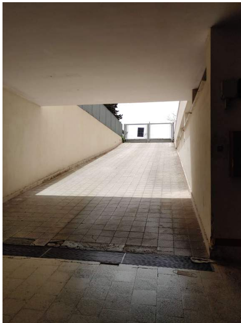
Foto C26 - Box AUTO AL PRIMO PINO INTERRATO - RAMPA DI ACCESSO
