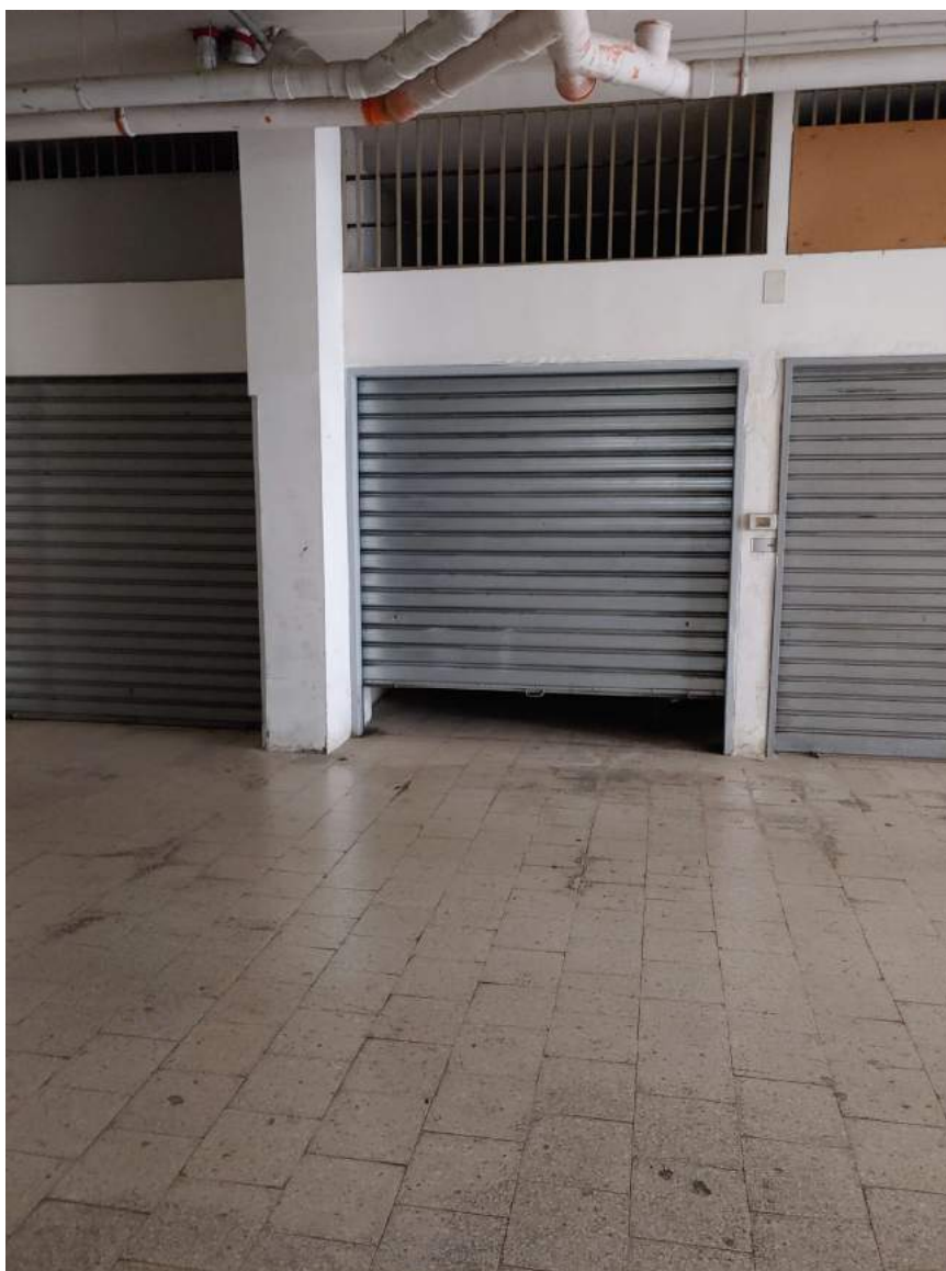
Foto C22 - BOX AUTO AL PRIMO PIANO INTERRATO - CORSIA DI MANOVRA/INGRESSO
