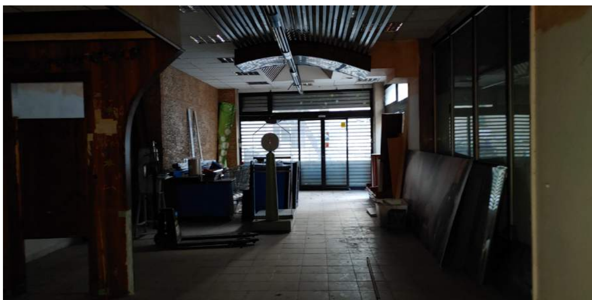
FOTO C8 - LOCALE COMMERCIALE - INTERNI - AREA VENDITA
