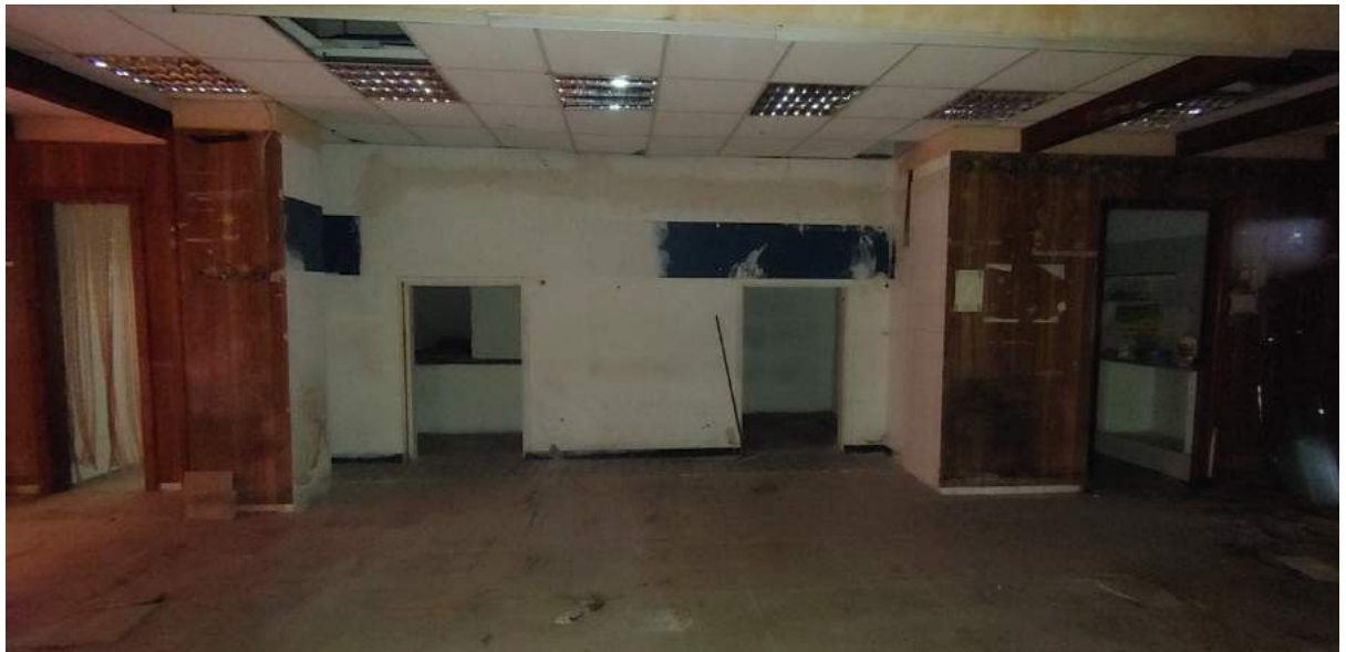
Foto C9 - LOCALE COMMERCIALE - INTERNI - AREA VENDITA
