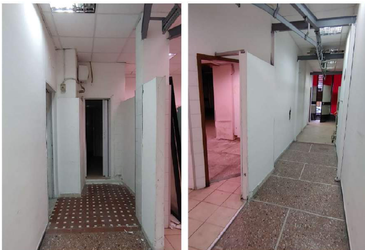
Foto C24 - LOCALE COMMERCIALE - INTERNI - DISIMPEGNI
