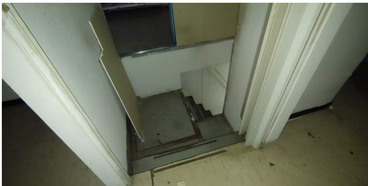
Foto C16 - LOCALE COMMERCIALE - INTERNI - SOPPALCO N. 1
