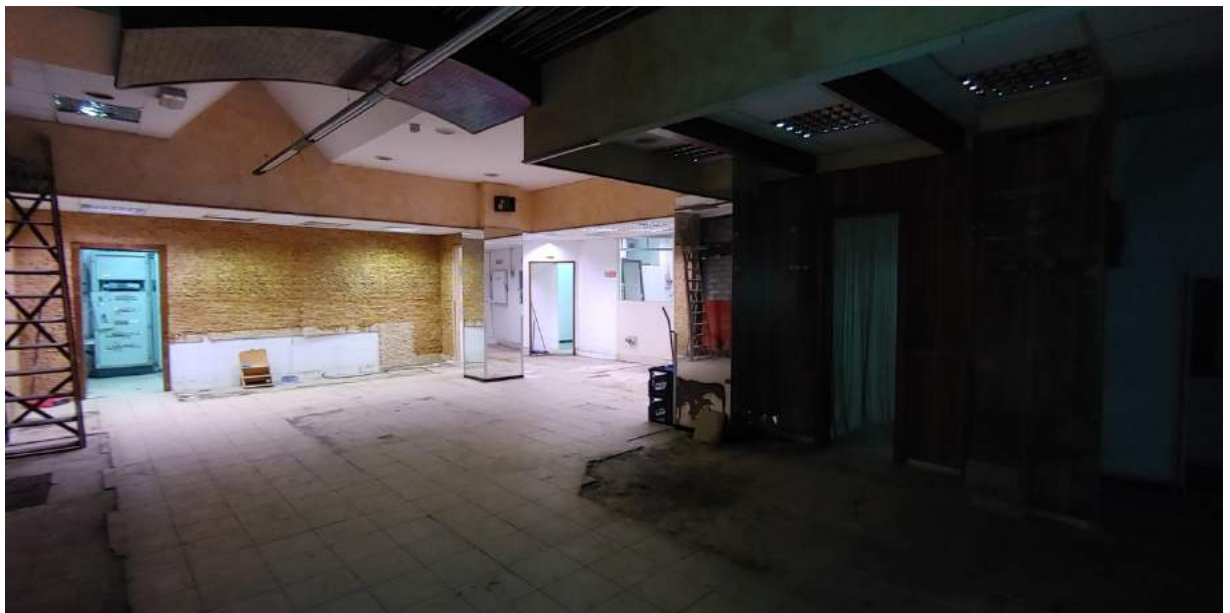
Foto C10- LOCALE COMMERCIALE - INTERNI - AREA VENDITA
