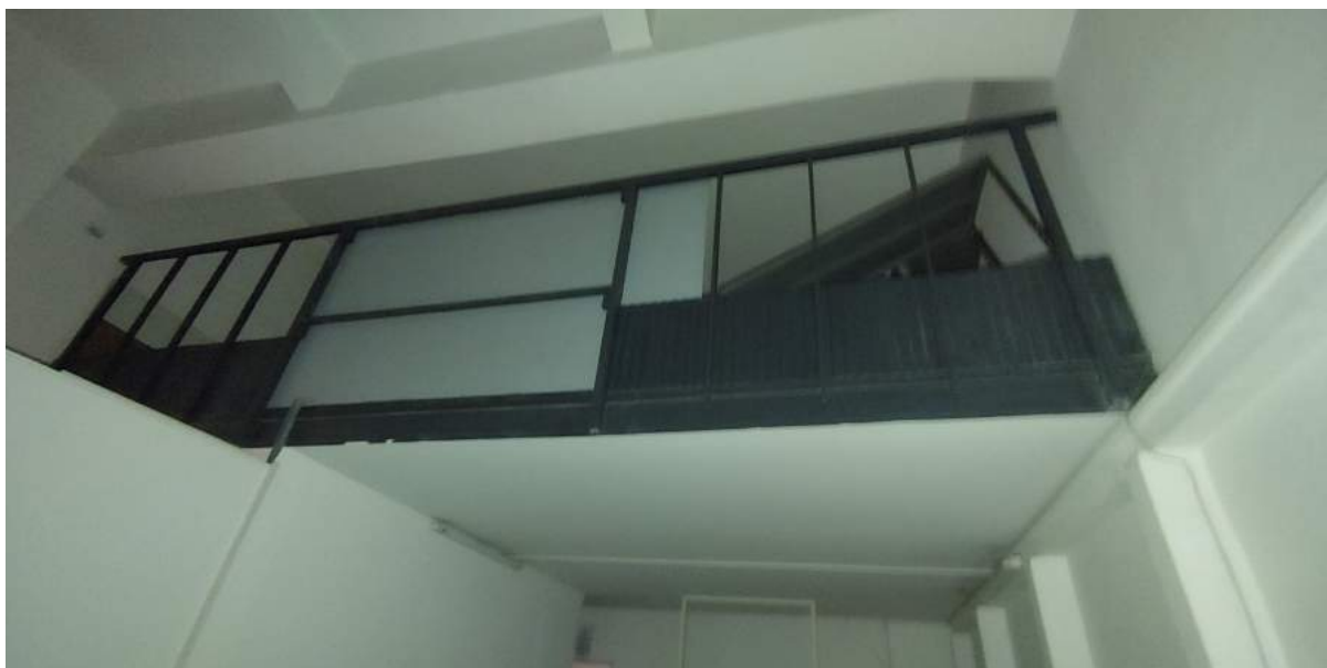
Foto C18 - LOCALE COMMERCIALE - INTERNI - SOPPALCO N. 2
