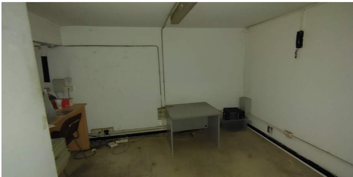
Foto C14 - LOCALE COMMERCIALE - INTERNI - SOPPALCO N. 1
