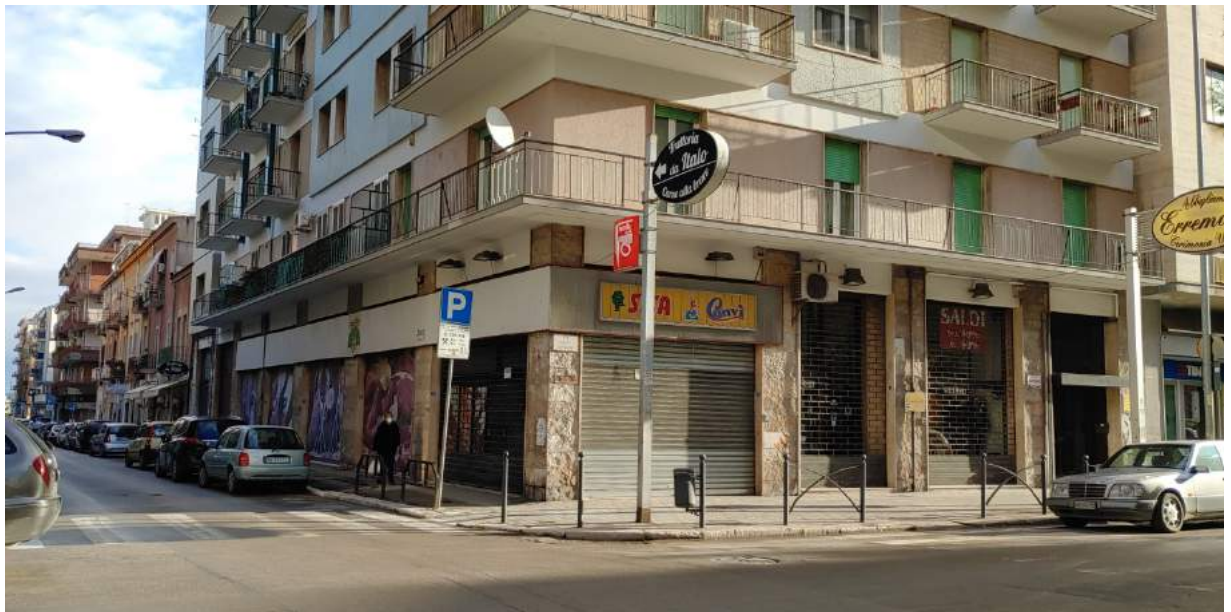
FOTO C4- LOCALE COMMERCIALE - VIA CONTE APPIANO ANGOLO VIA FIUME - FOGGIA
