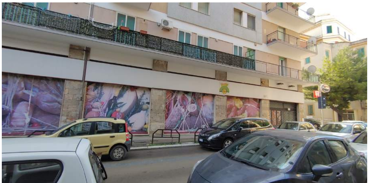
FOTO C5 - LOCALE COMMERCIALE - VIA FIUME N. 4 /A-F- FOGGIA
