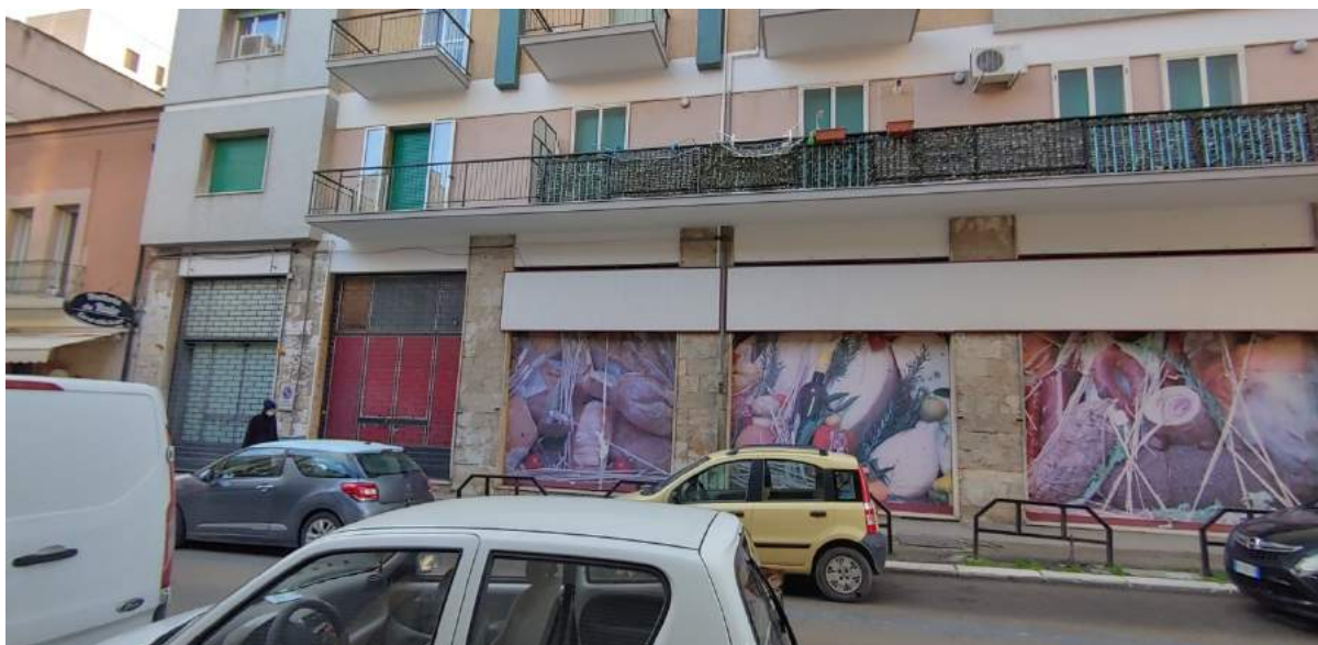
FOTO C6 - LOCALE COMMERCIALE - VIA FIUME N. 4 /A-F - FOGGIA
