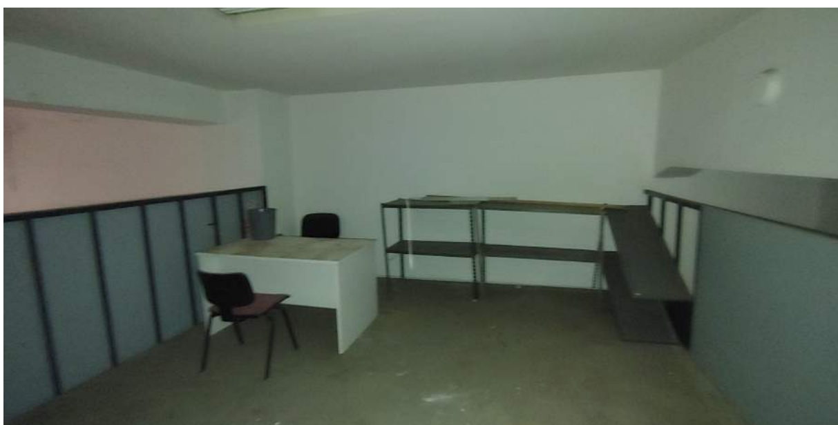
Foto C19 - LOCALE COMMERCIALE - INTERNI - SOPPALCO N. 2
