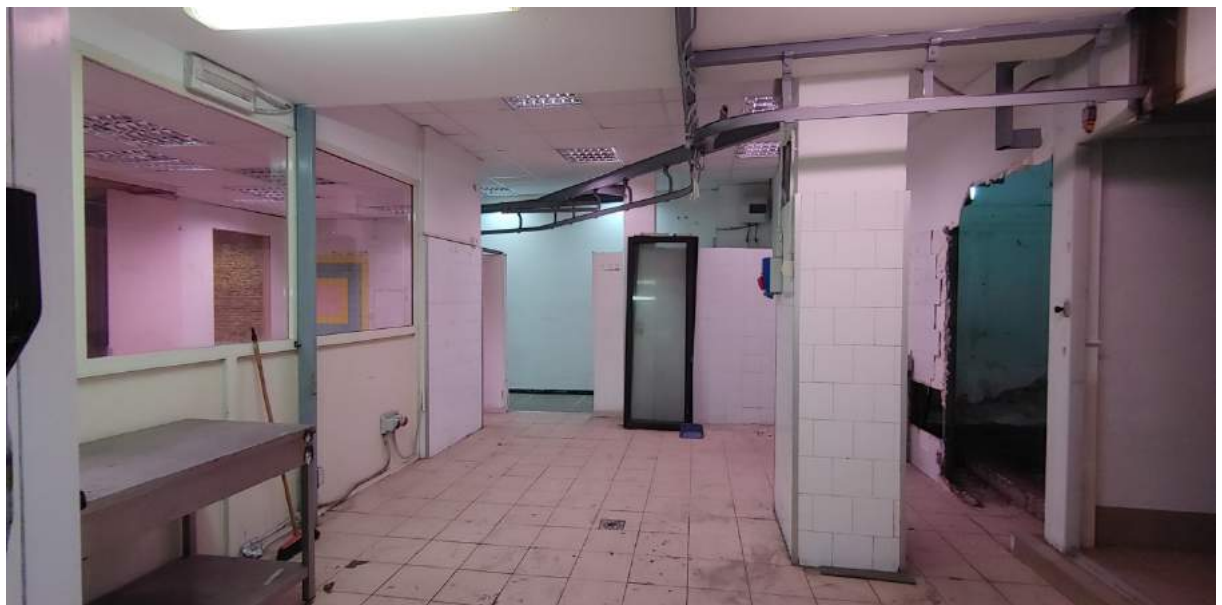
Foto C11 - LOCALE COMMERCIALE - INTERNI - AREA LAVORAZIONE CARNI/CELLE FRIG.
