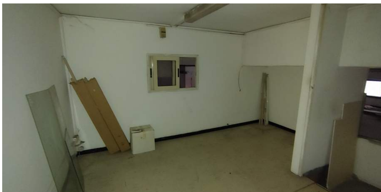
Foto C15- LOCALE COMMERCIALE - INTERNI - SOPPALCO N. 1
