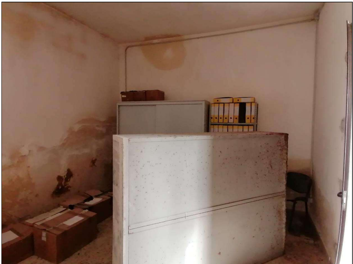
Foto 10 – Edificio p.la 1114 sub 1
