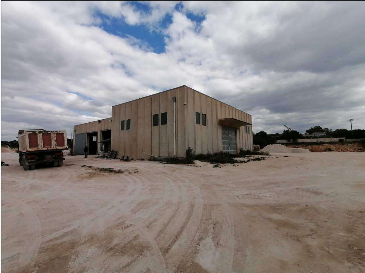
Foto 3 – Capannone p.la 998 sub 1
