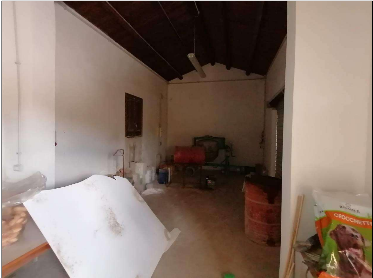
Foto 9 – Edificio p.la 1114 sub 1
