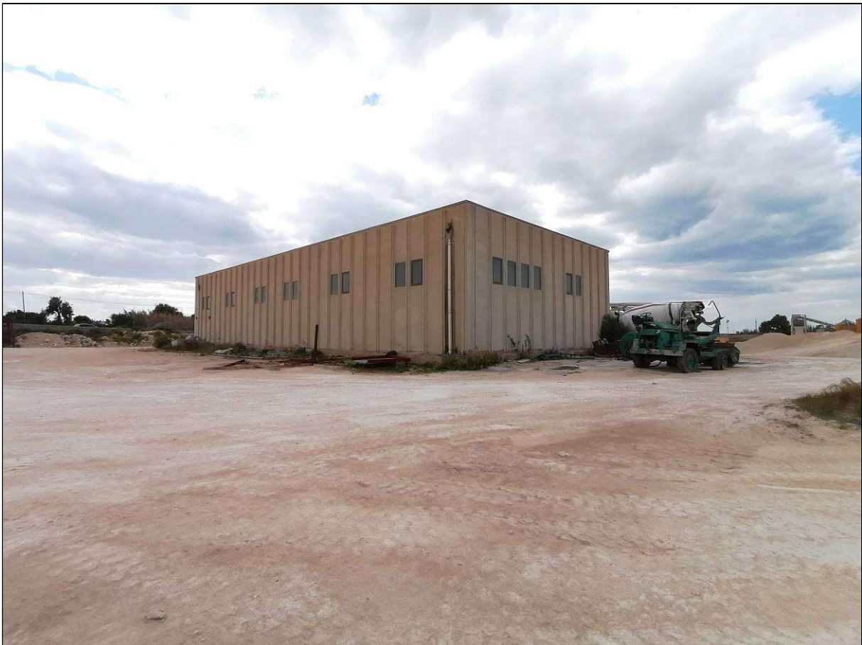
Foto 4 - Capannone p.la 998 sub 1
