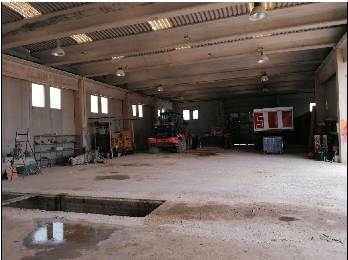
Foto 6 - Capannone p.la 998 sub 1
