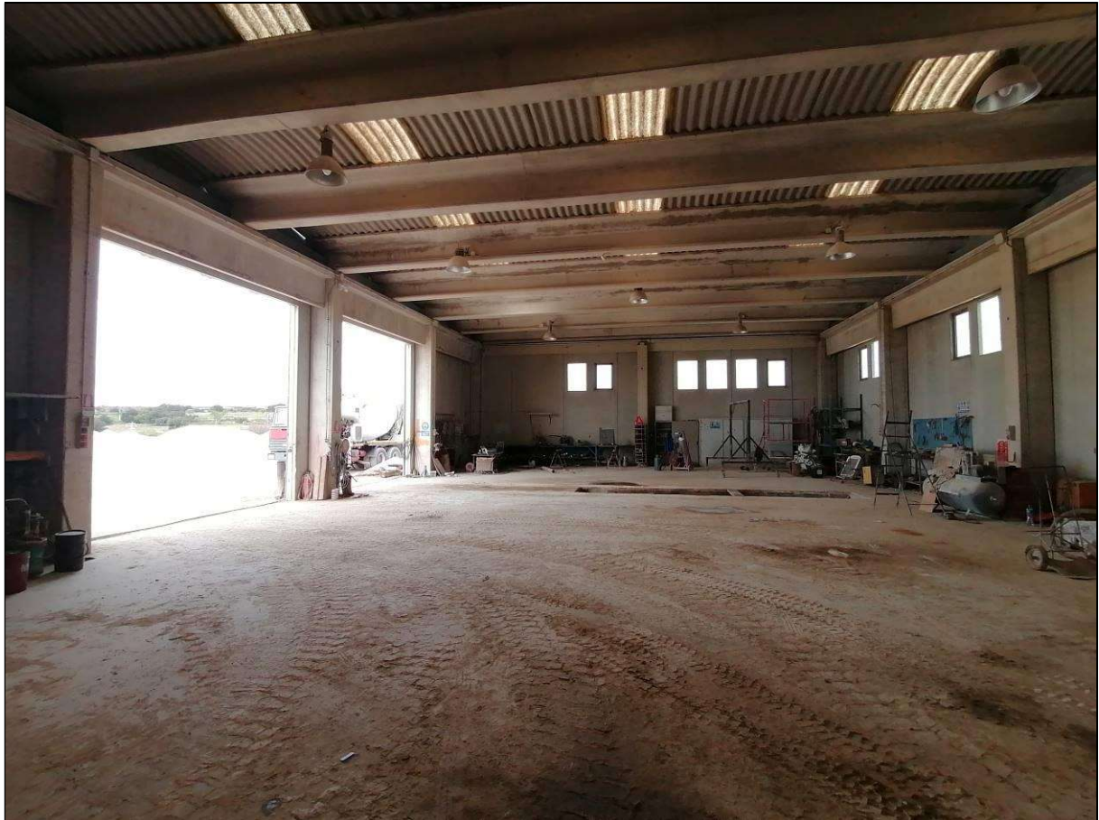
Foto 5 - Capannone p.la 998 sub 1
