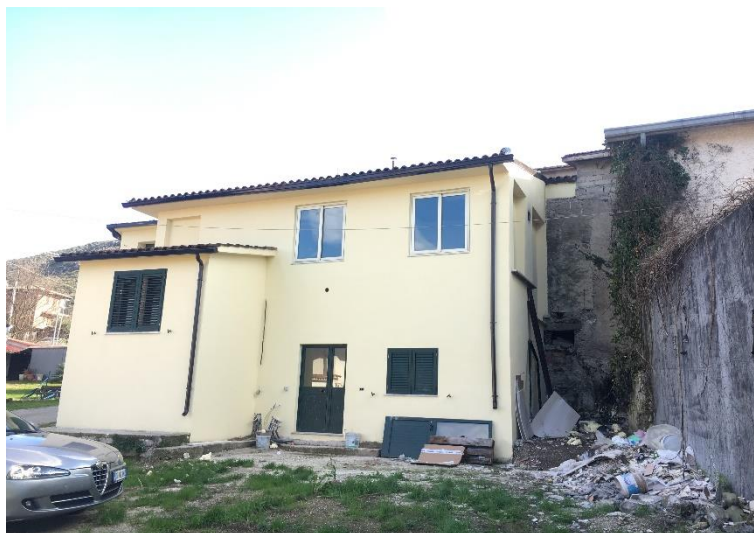
Foto n.8 – Foto terreno antistante l'edificio principale
