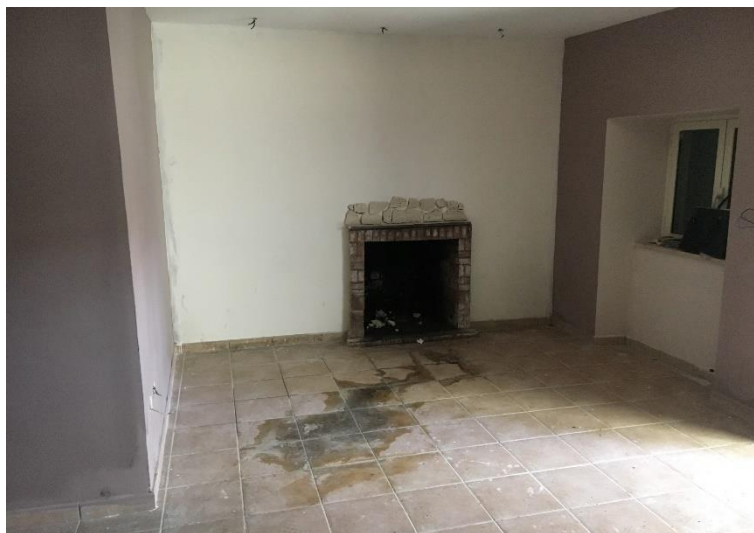
Foto n.4 – Foto parete camino posto nel soggiorno N.C.E.U. Fg 36 Mapp. 80 sub 13 (ex sub 9)
