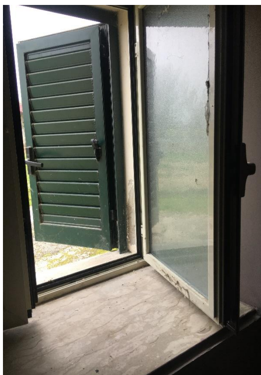
Foto n.7 - Foto particolare finestra
