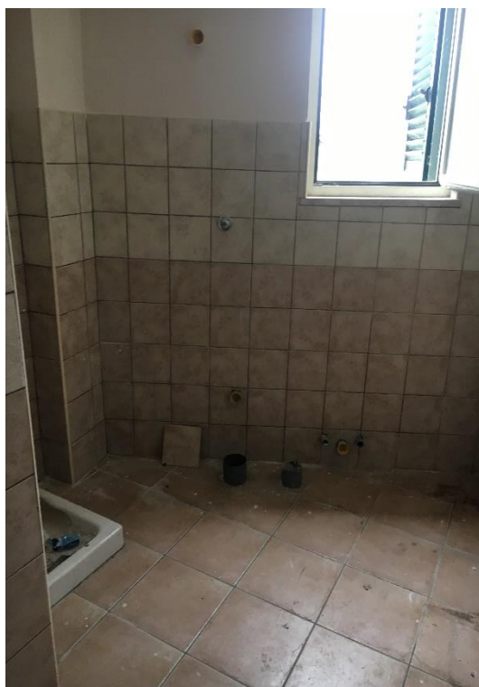
Foto n.6 - Foto stanza bagno, particolare rivestimenti
