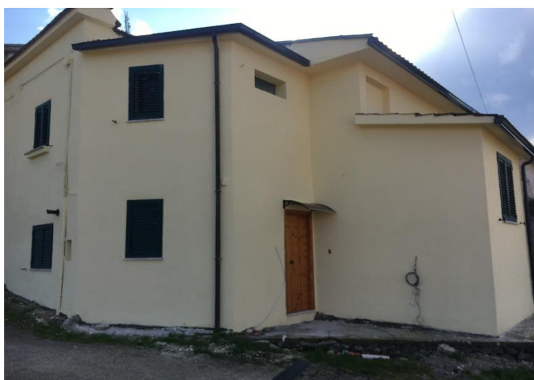
Foto n.2 – Foto prospetto laterale N.C.E.U. Fg 36 Mapp. 80 sub 13 (ex sub 9)
