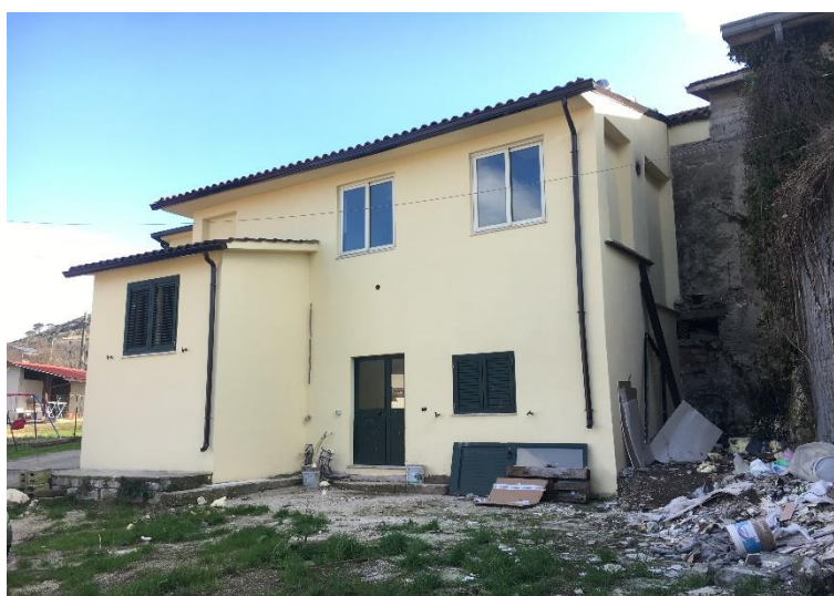
Foto n.1 – Foto ingresso fabbricato principale posto al piano terra N.C.E.U. Fg 36 Mapp. 80 sub 13 (ex sub 9)
