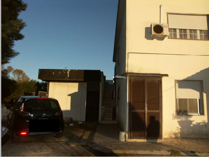
Foto esterno lato corte
